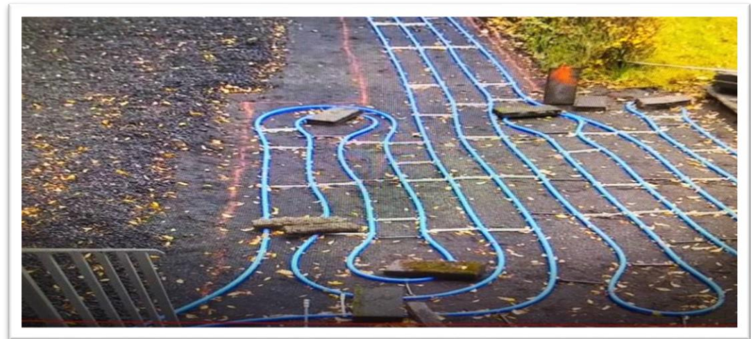
Şekil 2.15. Amerika'da jeotermal ile kar ve buz çözme tekniği Google (2020)
