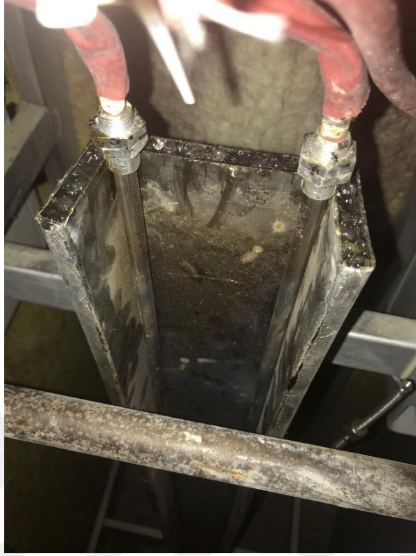
Şekil 4.16. Polipropilen malzemenin erimesi
