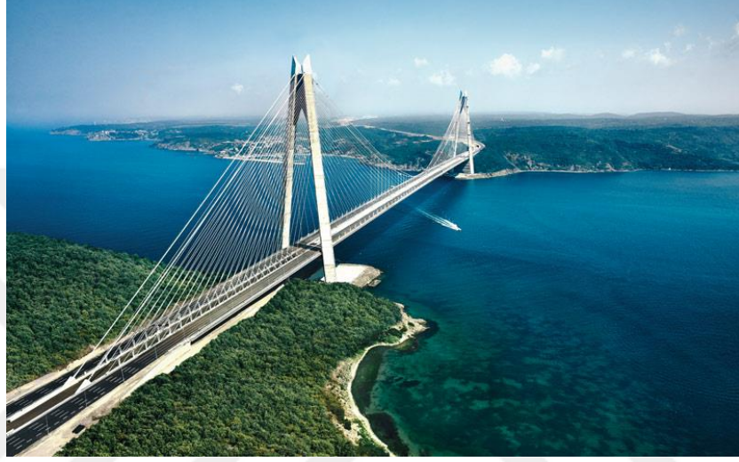
Şekil 3.9. Yavuz Sultan Selim Köprüsü
