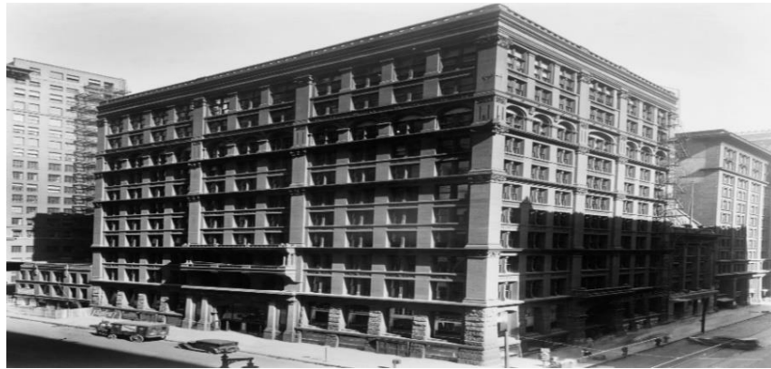
Şekil 3.7. Home Insurance Şirket Binası
