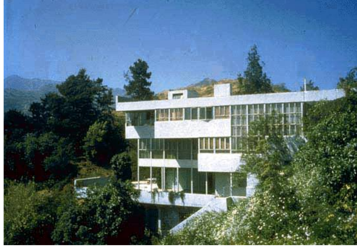
Şekil 3.10. Hafif çelik sistemleriyle inşa edilen bir yapı (Ekinci, 2006)
