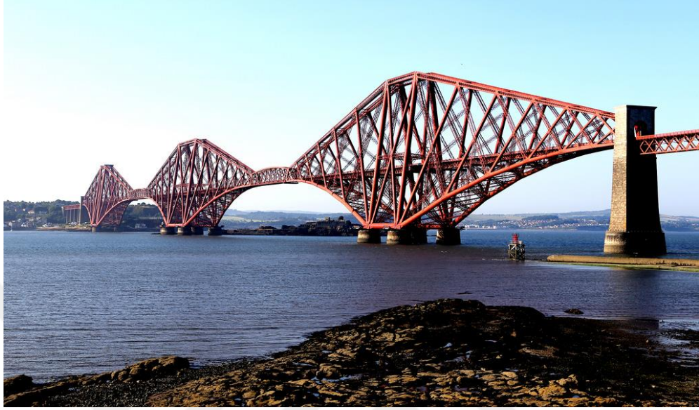
Şekil 3.8. Firth of Forth Köprüsü
