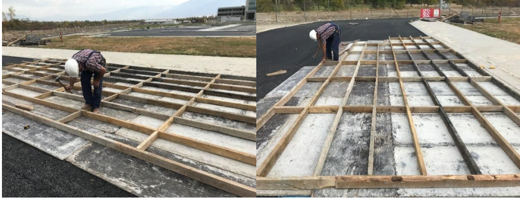
Şekil 4. 5. Kalıp işleri.
