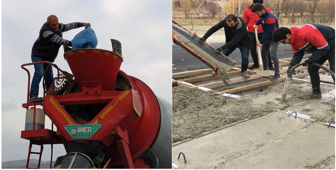
Şekil 4. 7. Beton döküm işleri: (a) plastik liflerin beton mikserine katılması; (b) beton dökümü.
