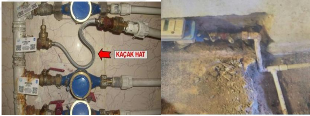
Şekil 2.3. İdari Su Kayıplarına Ait Bir Görüntü (su sayacına by-pass yapılarak izinsiz su kullanımı)
