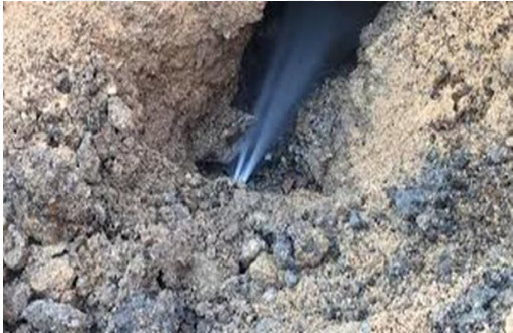
Şekil 2.2. Fiziki su kayıplarına ait bir görüntü (eski bir boruda oluşan sızıntı)
