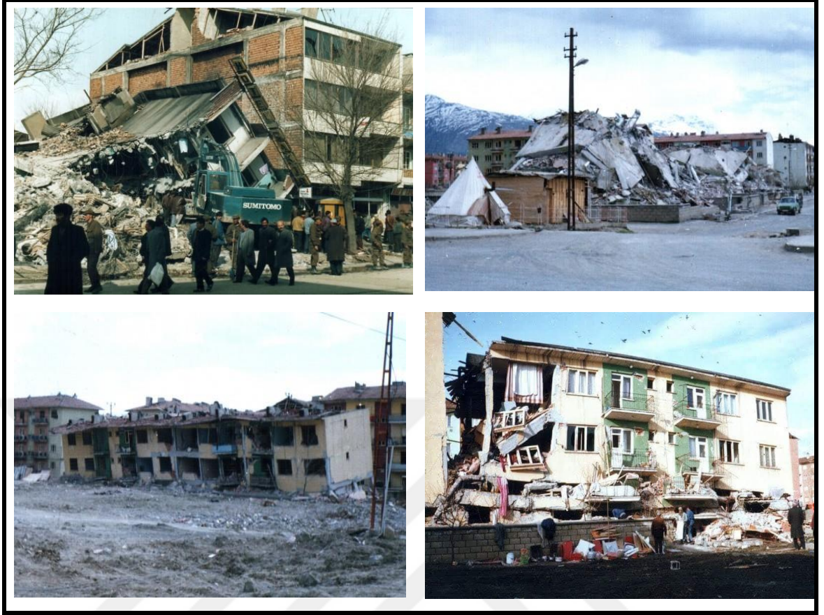
Şekil 4.9. 1992 Erzincan Depreminde binalarda meydana gelen hasarlar (Doğu Gazetesi, 2020)
