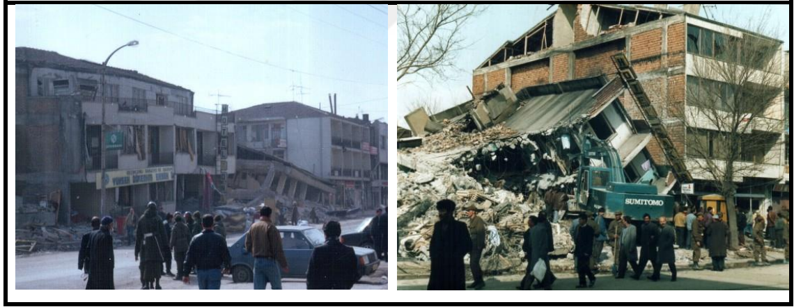
Şekil 4.7. 1992 Erzincan Depreminde çarpışma etkisiyle meydana gelen hasar (Doğu Gazetesi, 2020)
