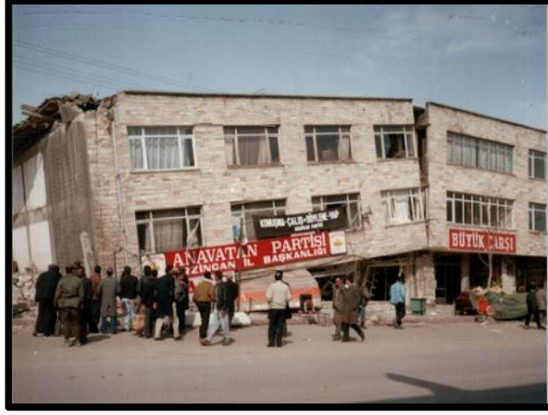
Şekil 4.6. 1992 Erzincan Depreminde yumuşak kat sebebiyle meydana gelen hasar (Doğu Gazetesi, 2020)
