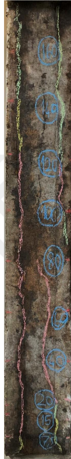
Şekil 5.16. C5 Betonarme kolonu için çatlak deseni
