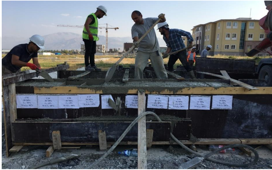
Şekil 4.6 Beton dökümü
