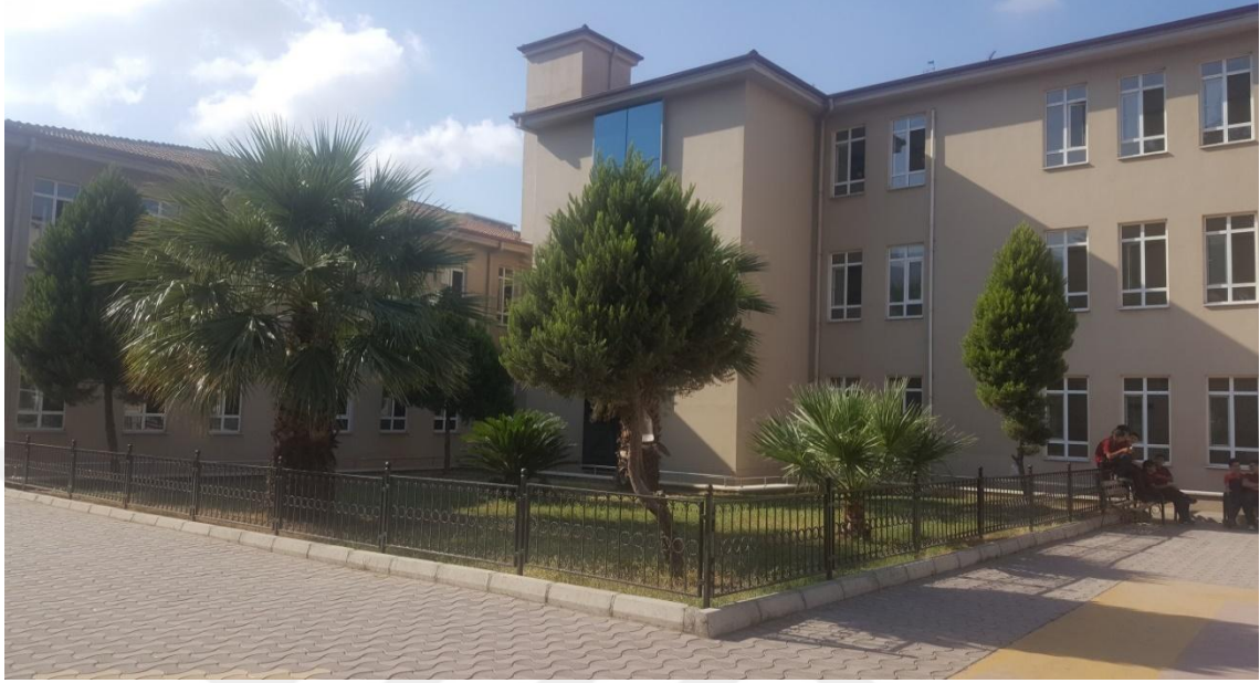
Şekil 4.7. Erol Bilecik Lisesi bahçesi mevcut bitki örtüsü
