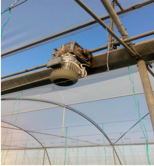
Şekil 3.6 Seradaki doğal havalandırma sistemi
