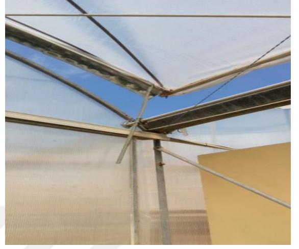
Şekil 3.5 Seradaki doğal havalandırma açıklıkları
