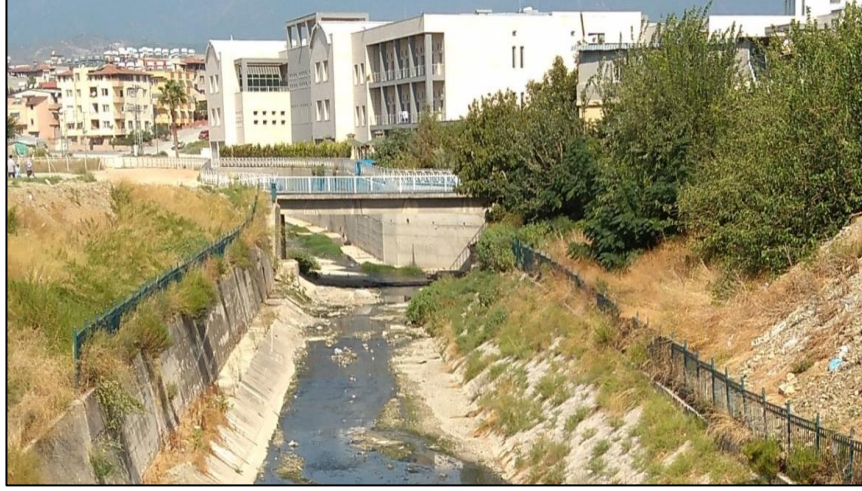
Şekil 4.6. Altınçay deresinde yarı trapez kanal geometrisi
