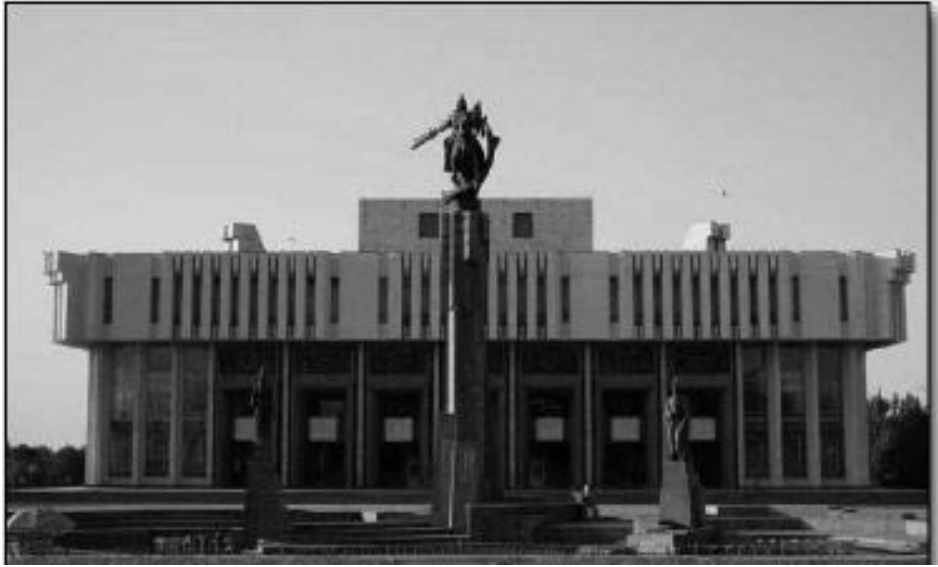
Toktogul Satılganov Adındaki Bişkek Filarmoni Binası
