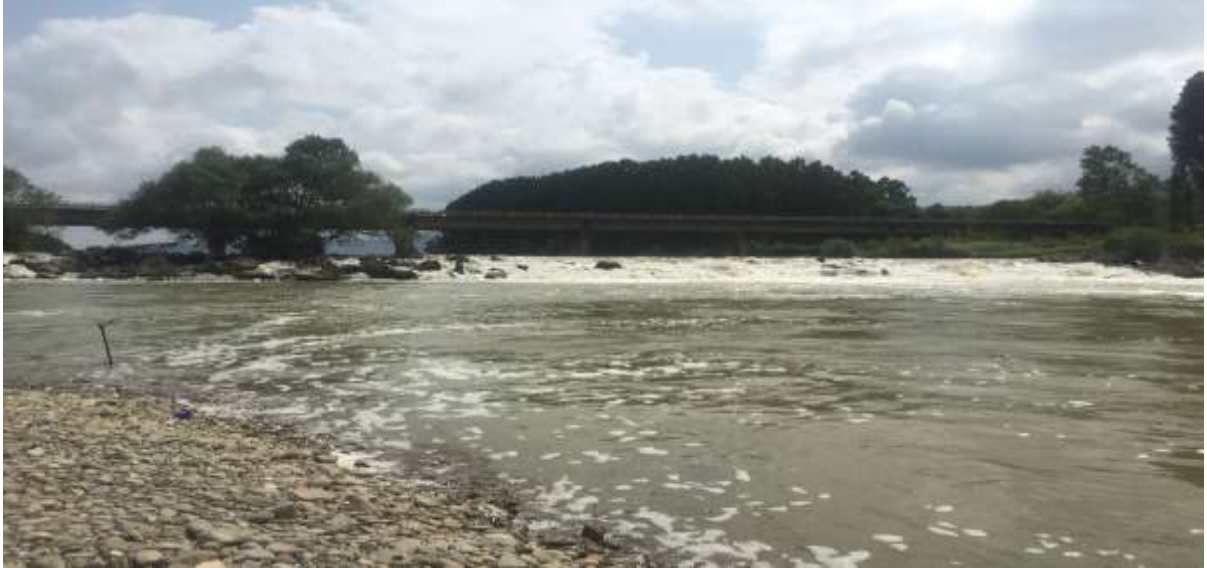
Şekil 4.5 F2 istasyonu (Saltukova Köprü)
