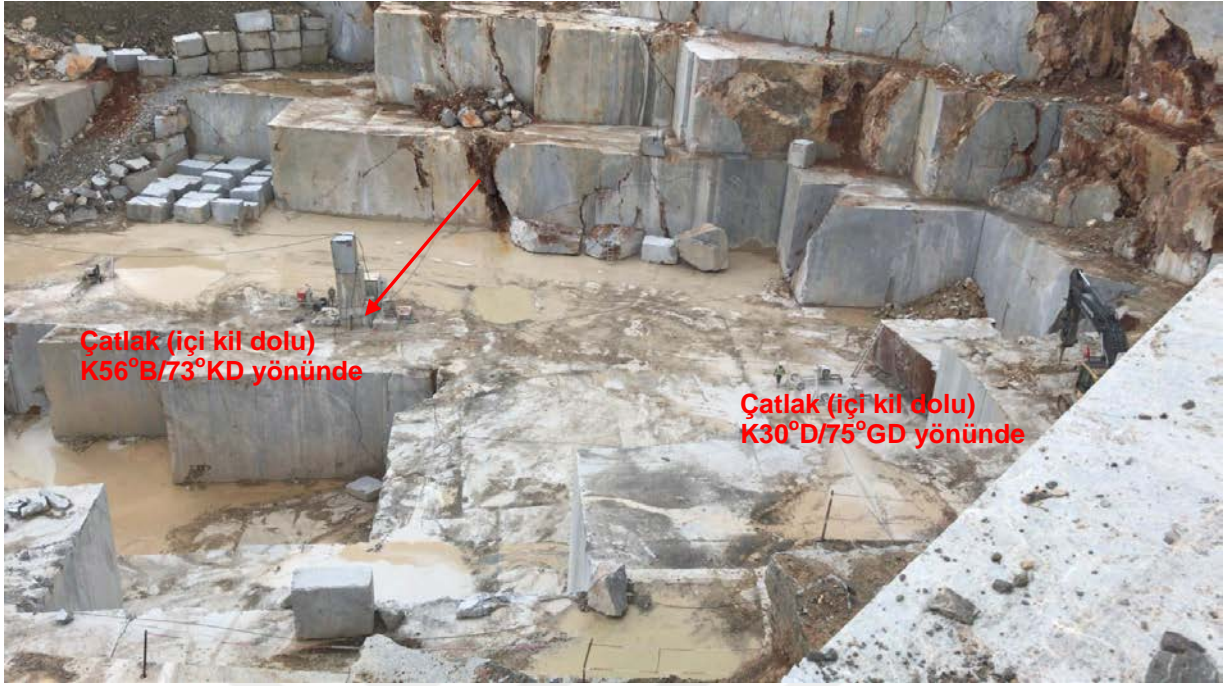
Şekil 6.1 Azdavay Sarnıçköy sahasındaki çatlakların yönü (1).
