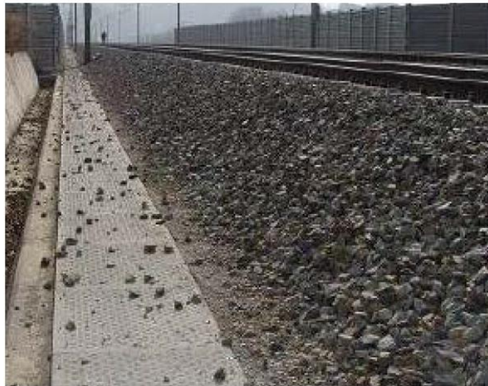
Şekil 3.11 Balast tabakasının iyi sıkılanmaması sonucu taş fırlama sorunları (Jing 2016).
