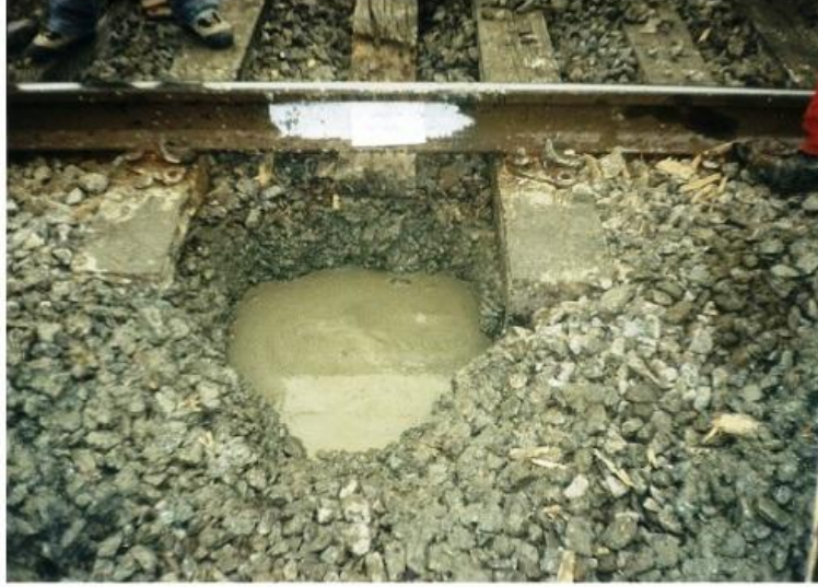
Şekil 3.12 Balastın kirlenmesinden dolayı travers altında biriken yüzey suyu (Paiva vd. 2015).
