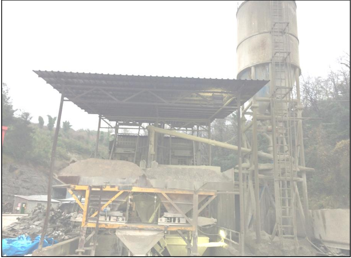
Şekil 6.14 Kuru karışım beton santrali ön görünüm.
