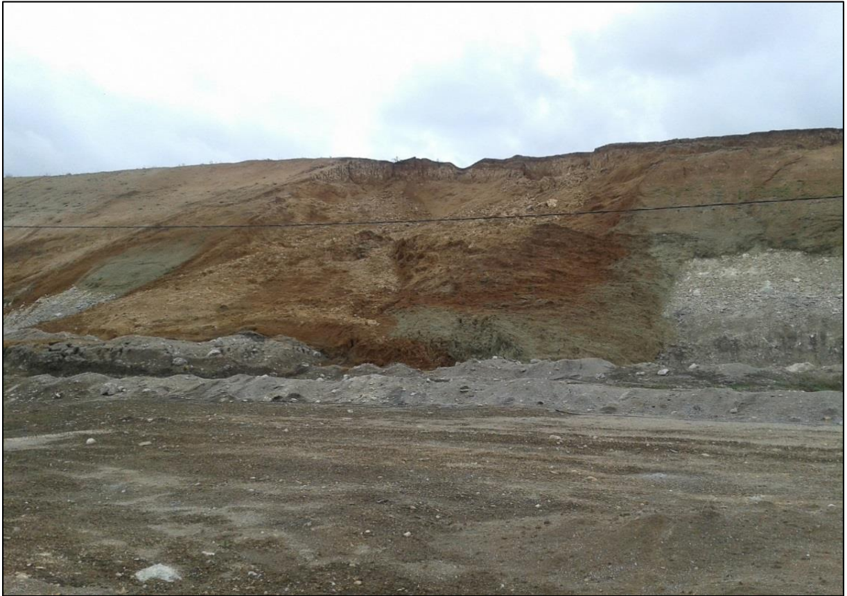
Şekil 5.2 Şev kaymasına ait arazi görüntüsü.
