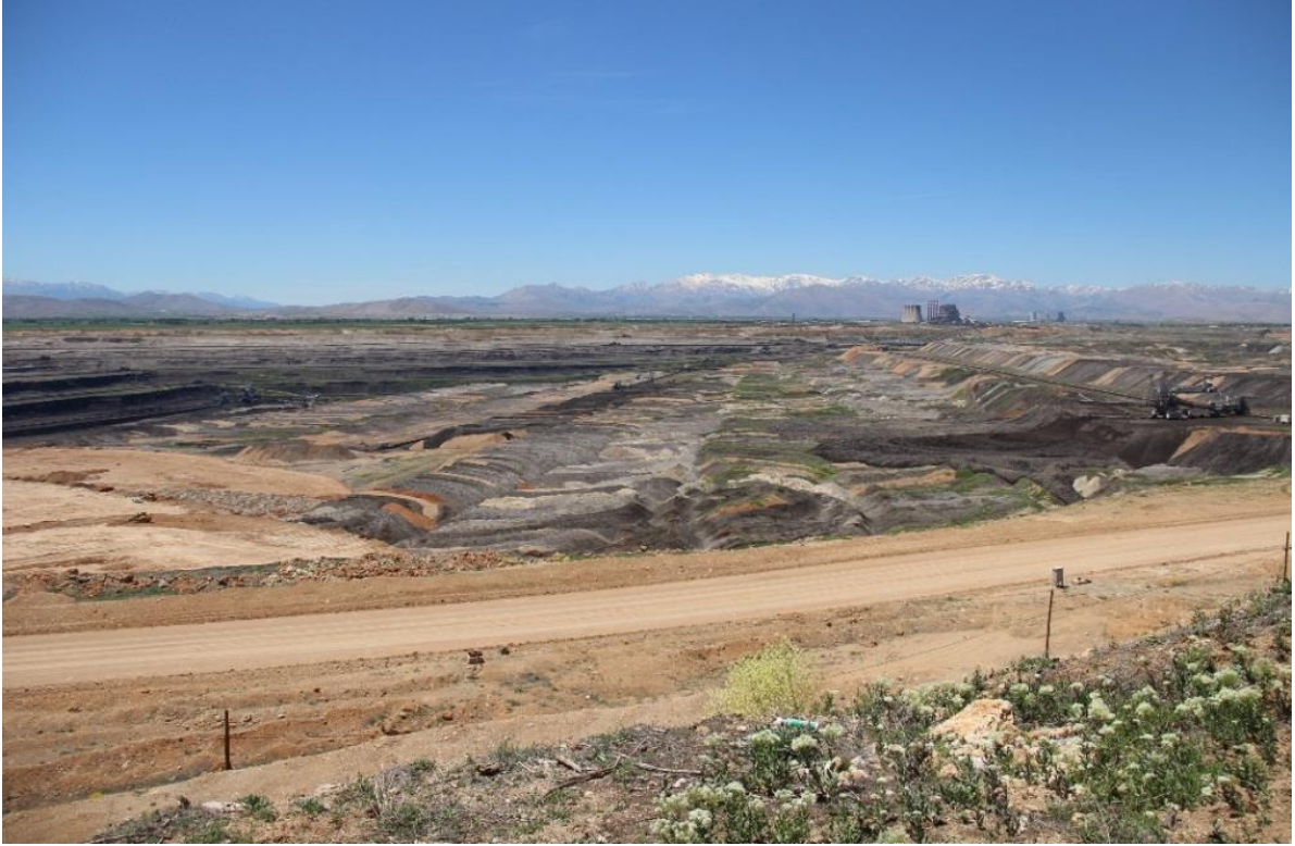
Şekil 5.5 YB-InSAR cihazı ile izlenen batı nihai şevi.
