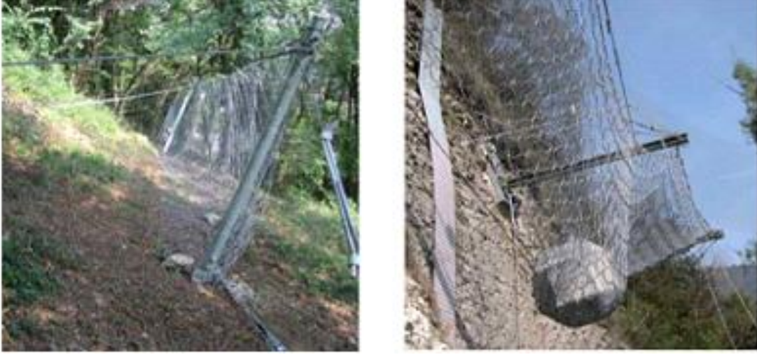
Şekil 6.5 Çelik ağların konumu ve kaya düşmesi olayına karşı uygulamasından görünüm (URL-3).
