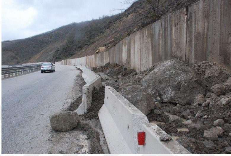
Şekil 6.8 Beton bariyer görünüm (URL-5).
