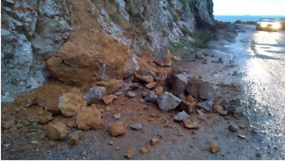
Şekil 3.5 Tez çalışma sahasında düşmüş kaya blokları, 06.01.2018.
