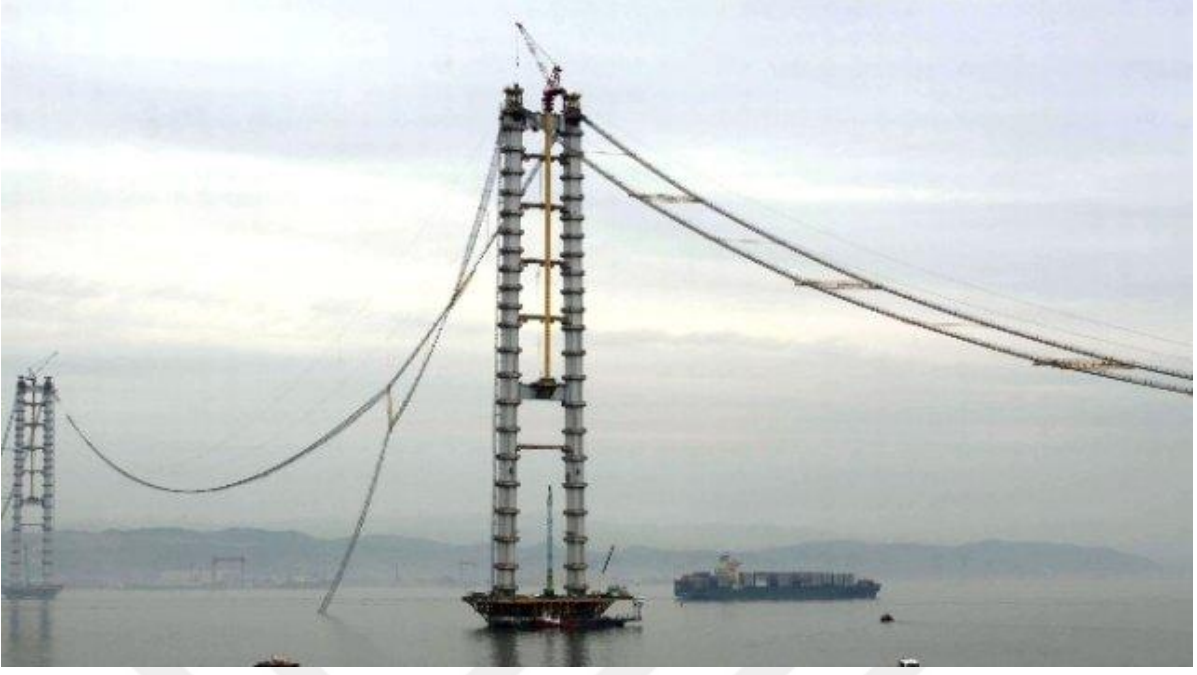
Şekil 1.1 Gebze-Orhangazi-İzmir Otoyol Projesi'nde 21 Mart 2015 tarihinde halat kopmasından kaynaklanan bir kaza [2]
