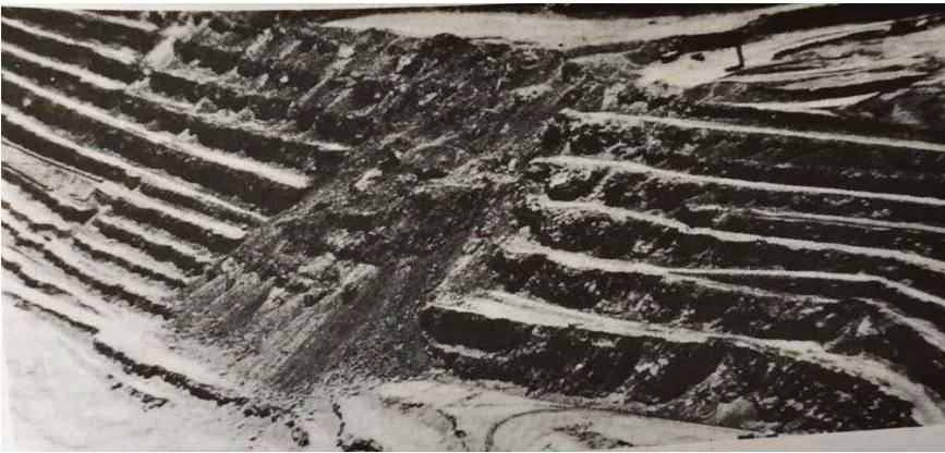
Şekil 2.8 Chuquicamata bakır işletmesinin şev kayması sonrası görünümü (Hoek and Bray 1977).
