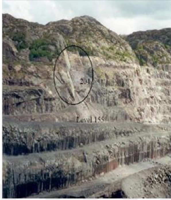
Şekil 2.3 Ana nakliyat yolunun üst tarafında kayma yenilmesi (Nilsen and Ballou 2006).
