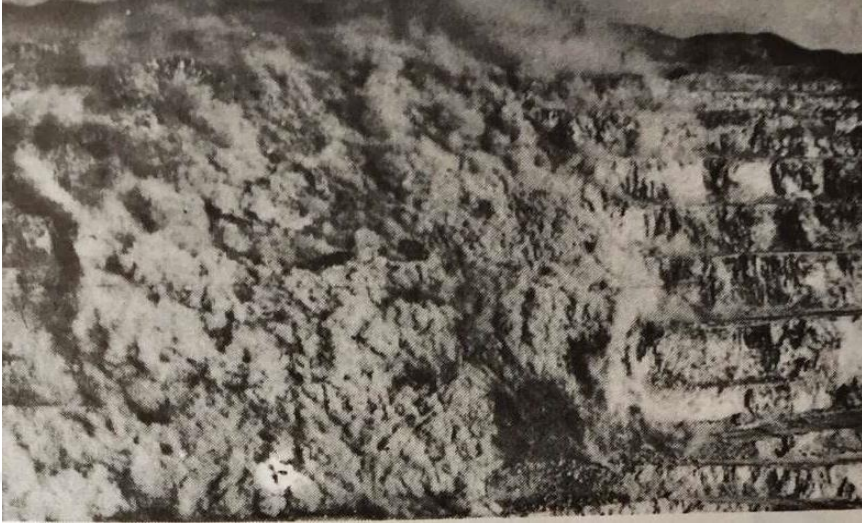
Şekil 2.7 Chuquicamata madeni doğu şevlerinde 18 Şubat 1969'de oluşan kayma anı (Hoek and Bray 1977).
