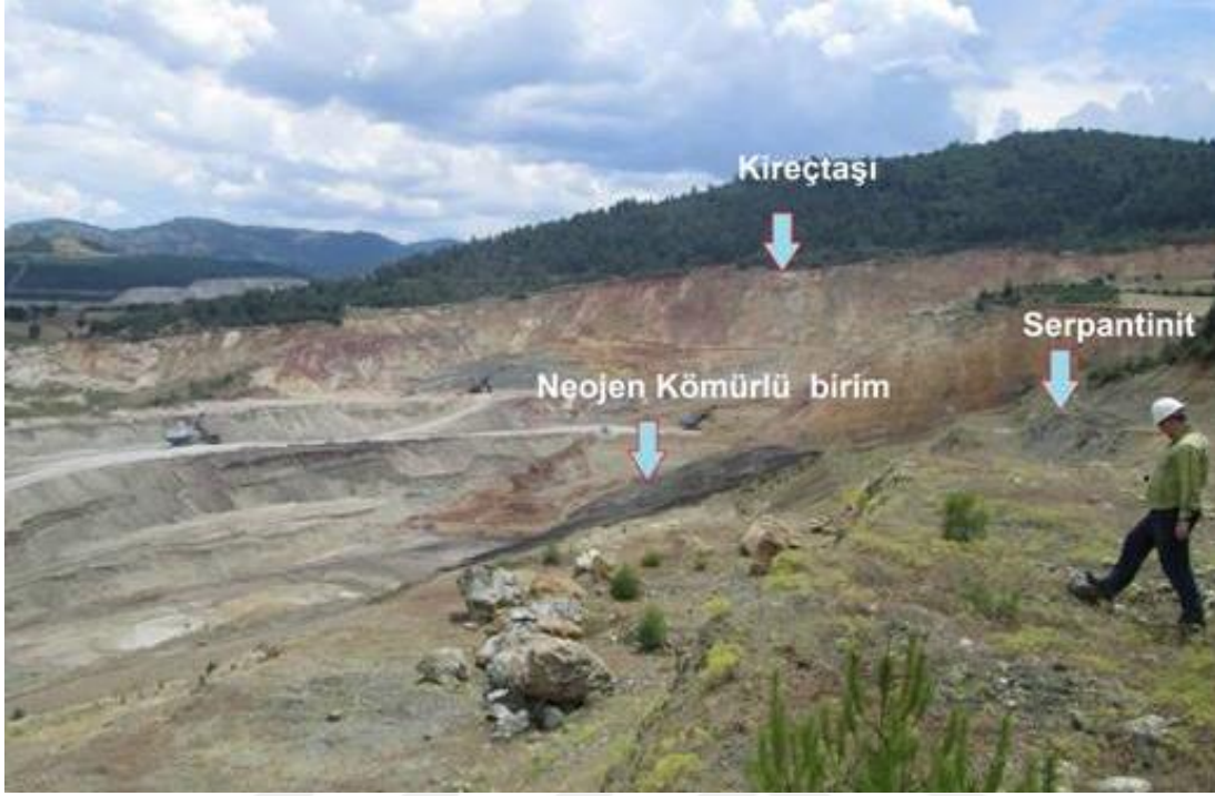
Şekil 3.4 İnceleme sahası güney kesimindeki litolojik birimlerden genel görünüm.
