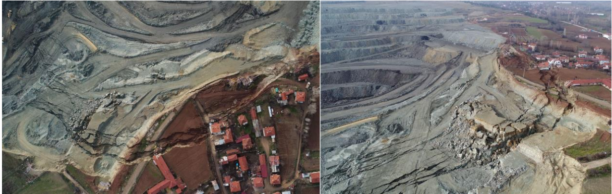
řekil 2.2 Aık iřletmeye komřu olan Himmetođlu Köyü’nde meydana gelen kayma (URL-2 2019).
