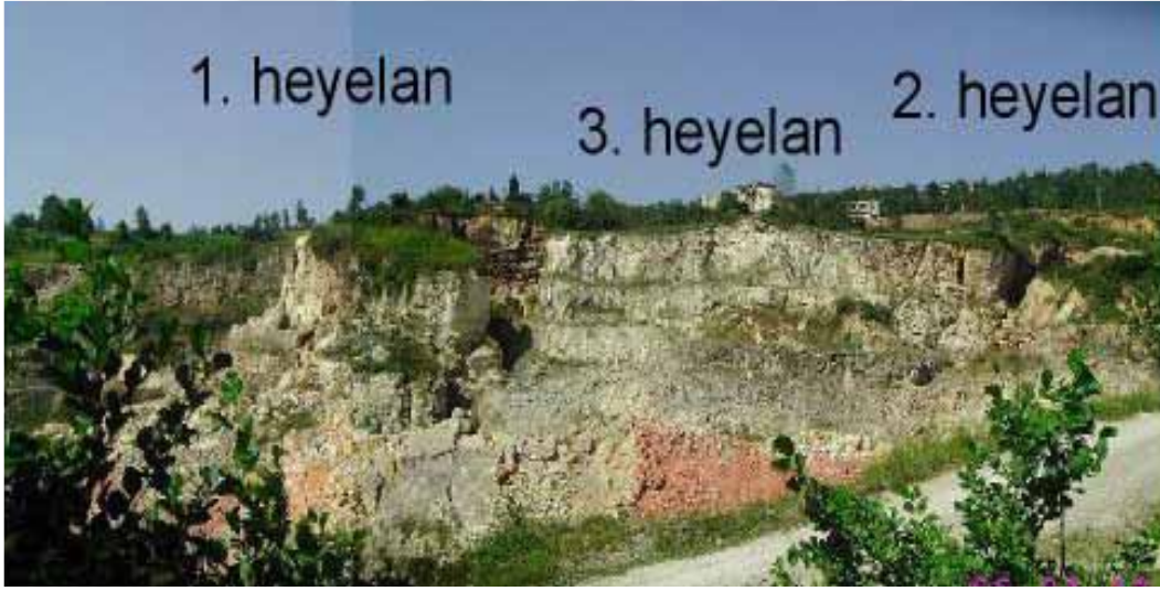
Şekil 2.4 Ekim 2005, Mart ve Ekim 2006 tarihlerinde Taşönü ocağında gelişen düzlemsel yenilmeler (Ceryan vd. 2009).
