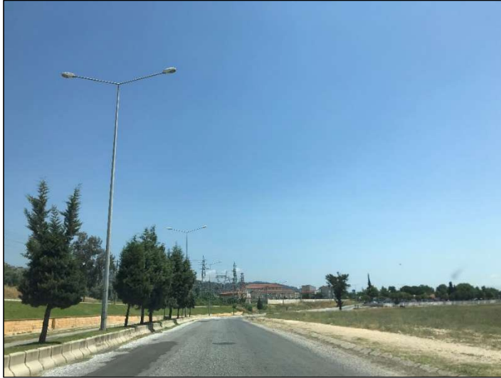
Şekil 4.35. Ilıcabaşı Mahallesi Doğu Gazi Bulvarı
