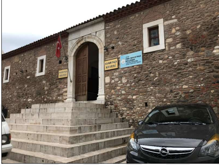
Şekil 4.15. 1629. Sokak Nasuh Paşa Külliyesi
