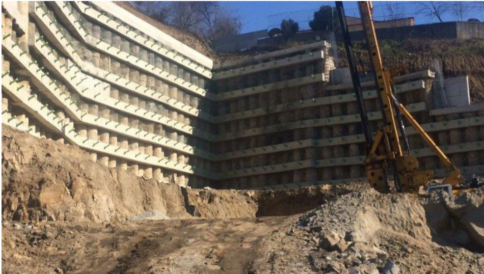
Şekil 6.4 İksa sisteminden bir görüntü.
