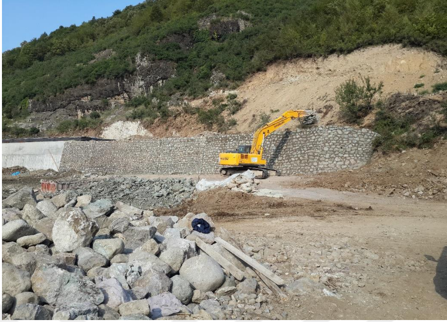
Şekil 7.5 İnceleme alanındaki inşası tamamlanmış bir taş duvar görüntüsü
