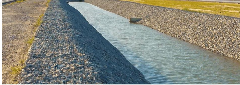
Şekil 7.32 Şilte gabion uygulamasına örnek.
