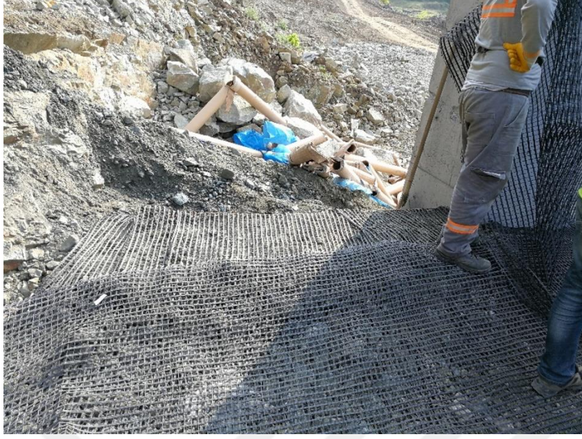
Şekil 7.47 Çalışma alanındaki serilmiş geogrid örneği.
