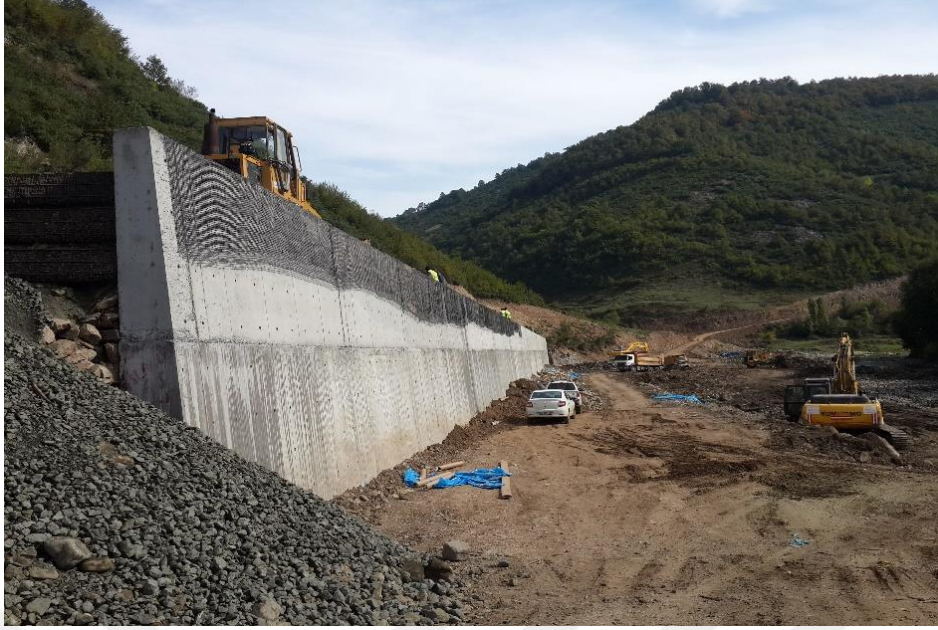
Şekil 7.13 Çalışma alanında betonarme istinat duvarı ve temelini tamamlanmış görüntüsü.
