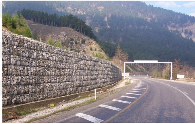
Şekil 7.29 Karayolu şevli arazideki zemin kaymalarının önlenmesi için gabion uygulaması.
