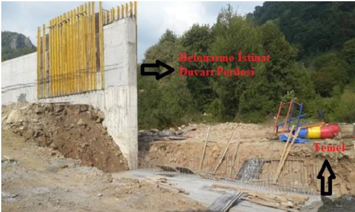
Şekil 7.12 Çalışma alanında betonarme istinat duvarı inşası görüntüsü.
