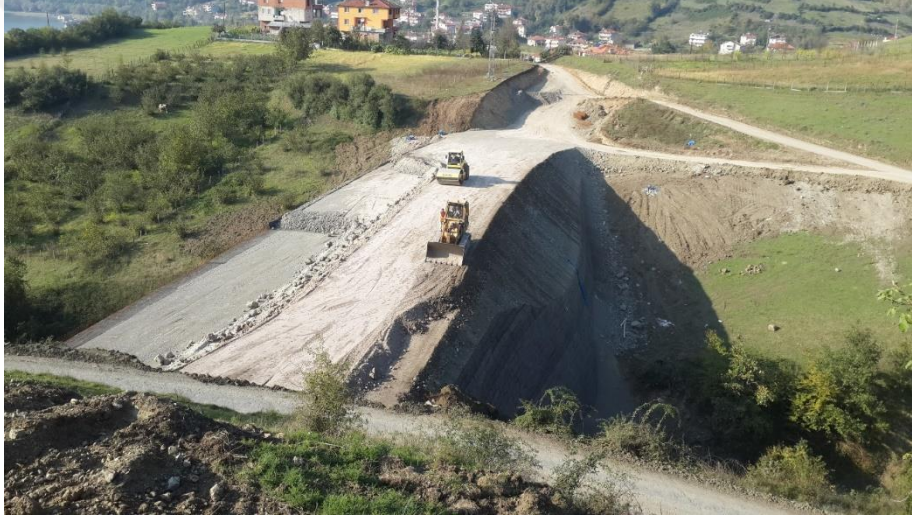
Şekil 7.48 Çalışma alanındaki inşası süren geogrid donatılı istinat duvarı.
