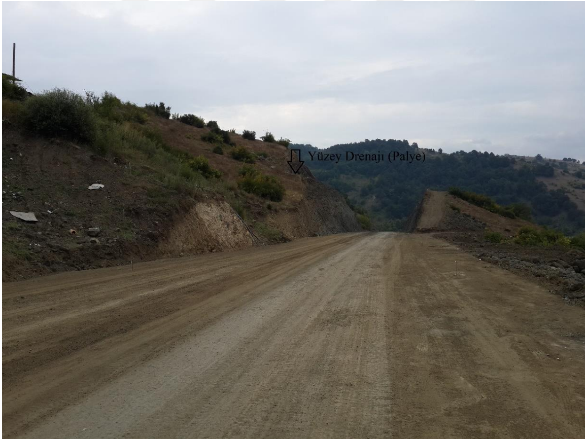
Şekil 5.6 Çalışma sahasında yüzey drenajı.
