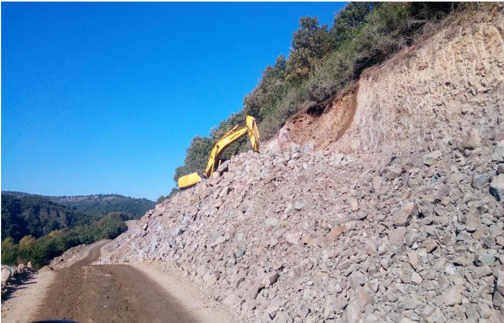
Şekil 5.5 Çalışma sahasında kazı yöntemi ile iyileştirme.
