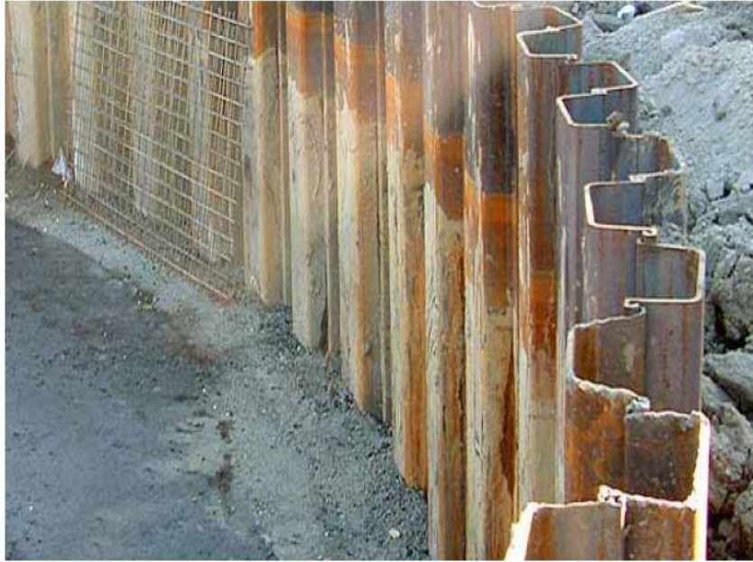
Şekil 7.21 Palplanş perdenin yakından görünümü.
