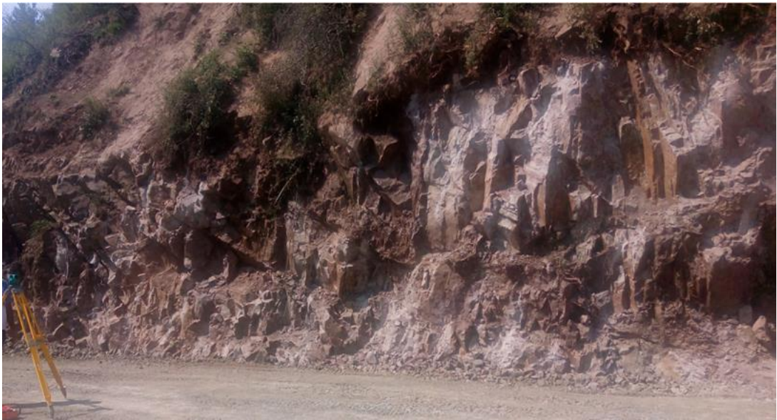
Şekil 3.12 Çalışma alanında yarma örneğinde hâkim andezit kayacı.
