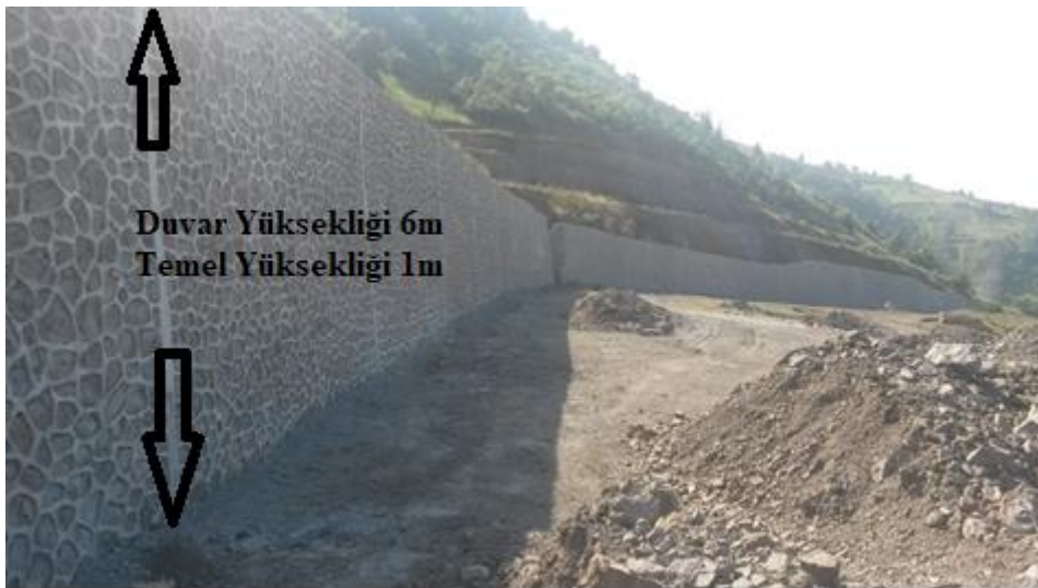
Şekil 7.1 İnceleme alanındaki taş duvar görüntüsü.
