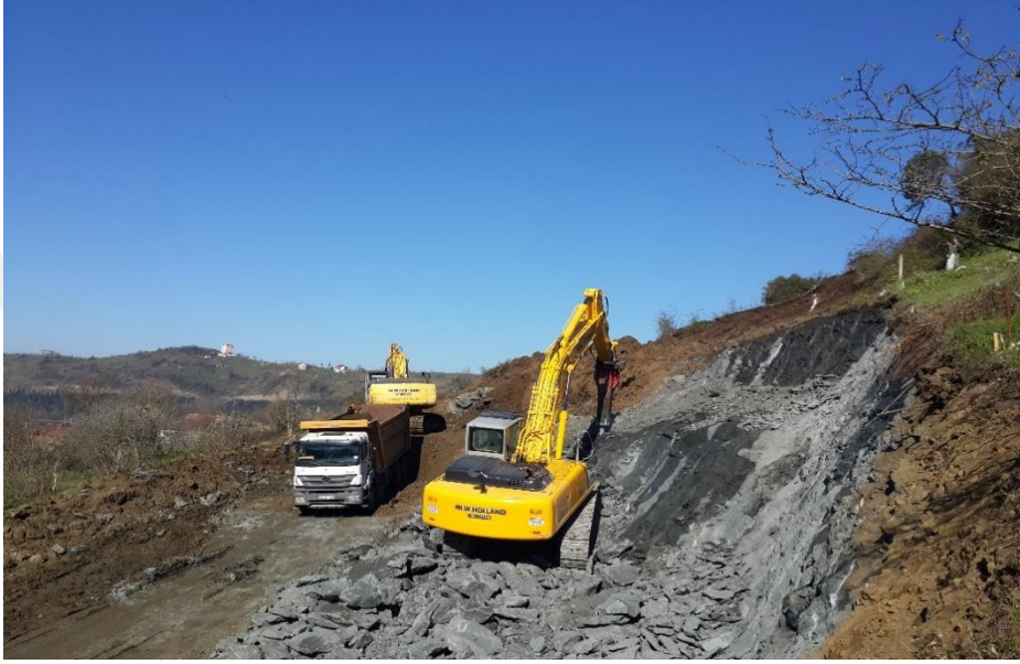
Şekil 2.3 Çalışma alanı yol inşası görünümü.
