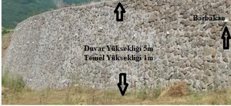
Şekil 7.4 İnceleme alanındaki taş duvar içindeki barbakan görüntüsü.
