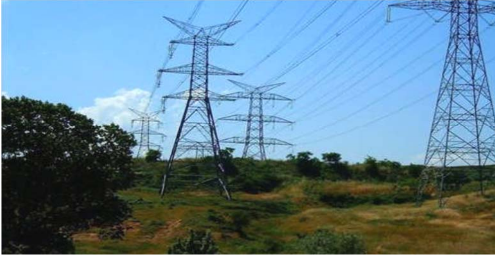
Şekil 4.3 Enerji nakil hattı kontrolünde arazi örneği. Tehlikeler; engebe, eğim, yoğun bitki örtüsü, yaban hayvanı, kene vb. (MEGEP 2011).
