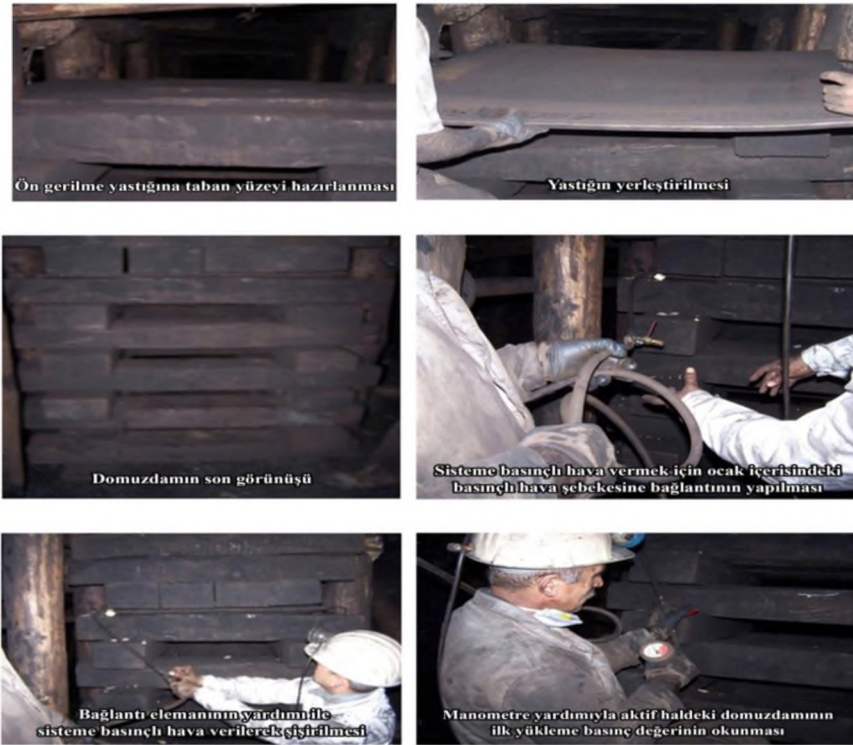
Şekil 4.17 ÖGADD sisteminin Sistemin Kozlu Sulu Panoda kurulum aşamaları (Yamudi 2008)
