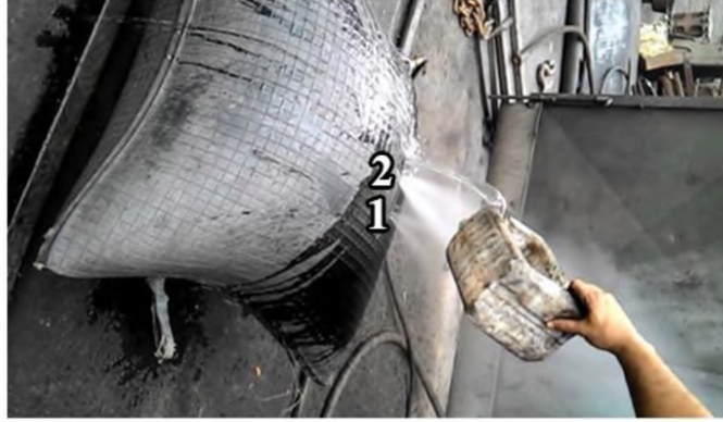
Şekil 4.23 Şişirilmiş hava yastığının su ile kontrolü.
