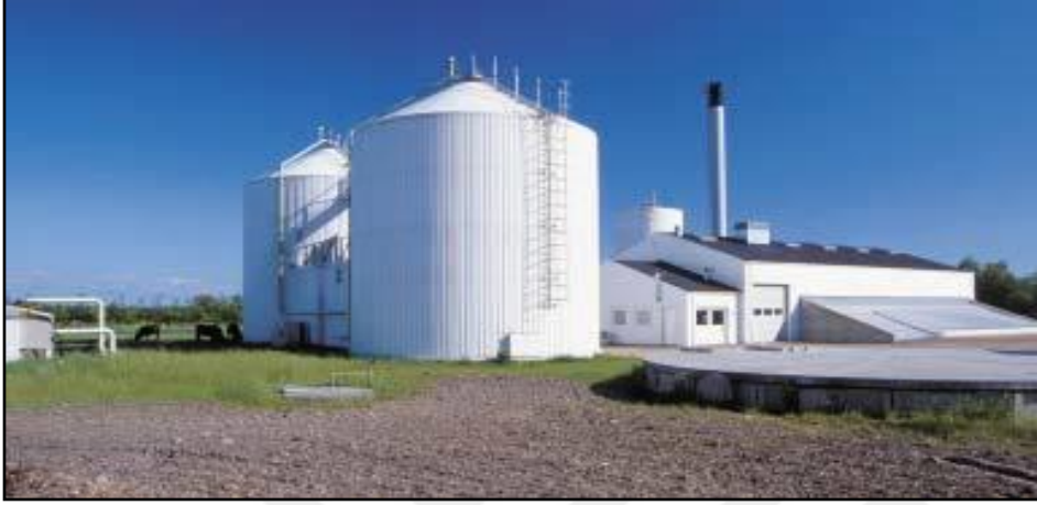
Şekil 1.20 Danimarka’da inşa edilmiş merkezi bir biyogaz tesisi (Yokuş, 2011)
