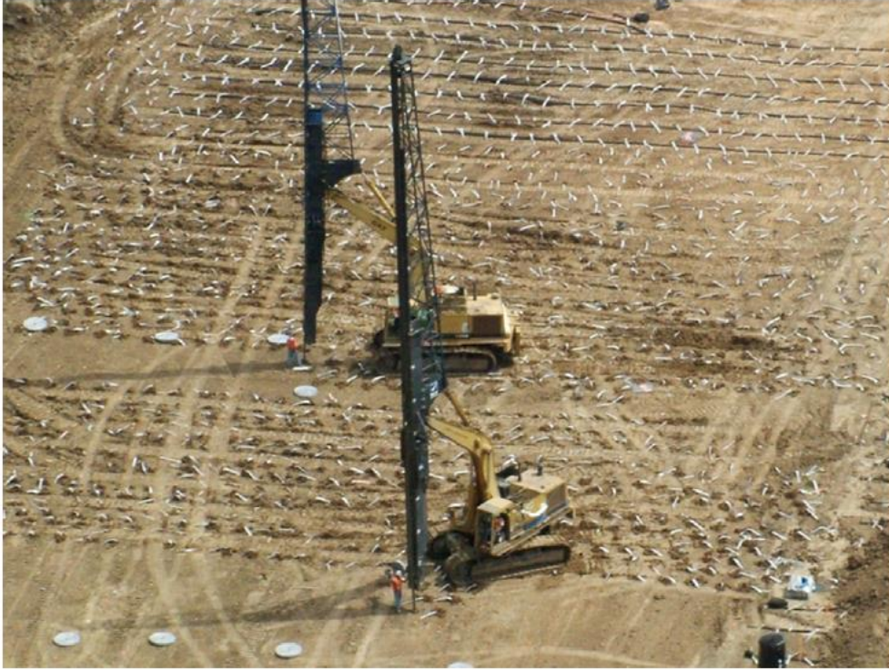
Şekil 3.5 İnşaat Sahasında PDD Uygulaması Örneği (Nicholson 2015).
