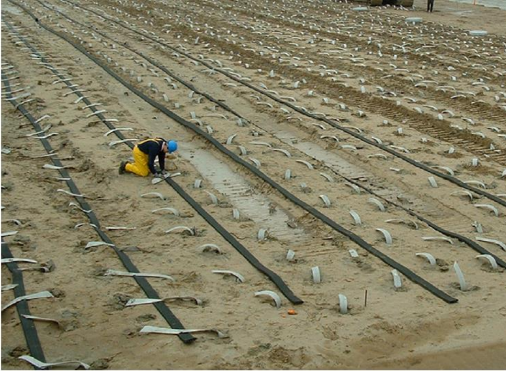
Şekil 3.6 İnşaat Sahasında PDD Yatay Olarak Bağlanan Şerit Drenlerin Yerleştirilmesi (Nicholson 2015).
