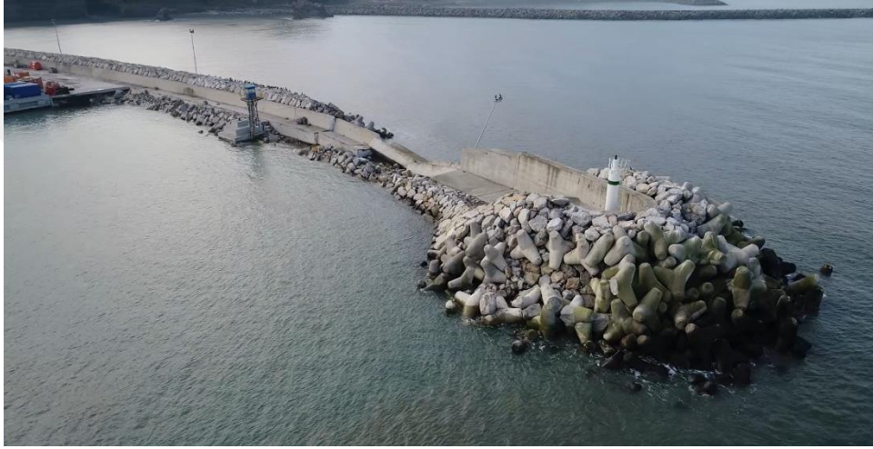
řekil 4.10 Eren Limanı Tali Mendirek Hasar G6r6nt6s6
