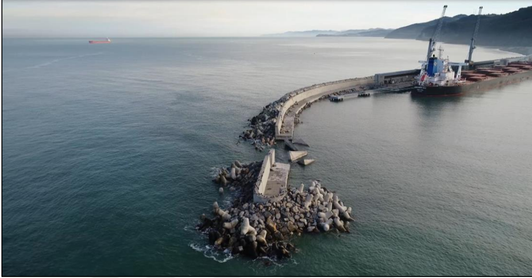
Şekil 4.8 Eren Limanı Ana Mendirek Hasar Görüntüsü
