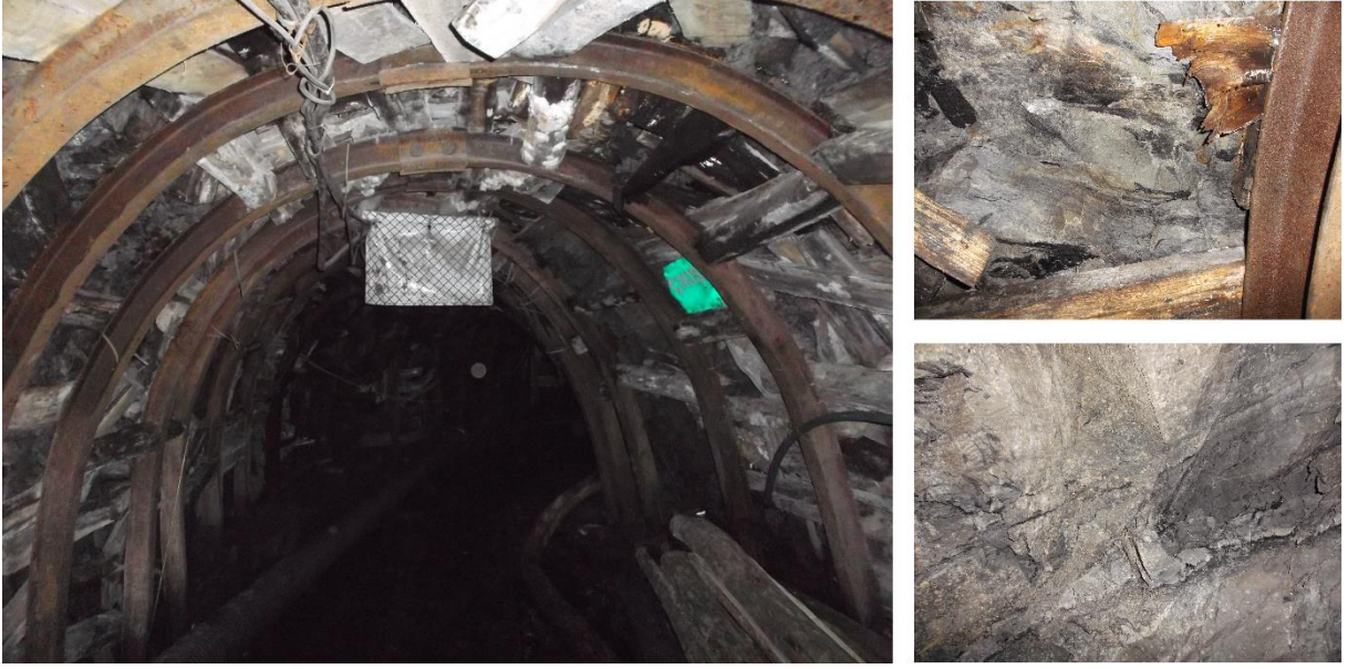
Şekil 4.27 +175 galerisinin 25 m ile 38 m arasından görünüşü.
