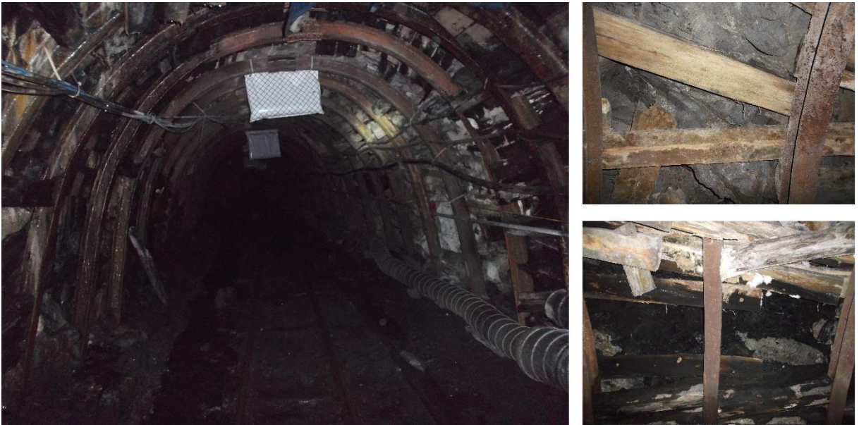
Şekil 4.10 +205 ana galerisinin 430 m ile 435 m arasından görünüşü.
