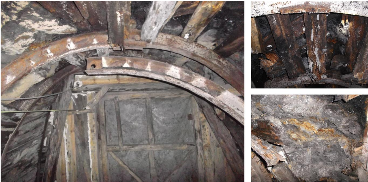
Şekil 4.13 +205 ana galerisinin 502. m'sinden görünüş.
