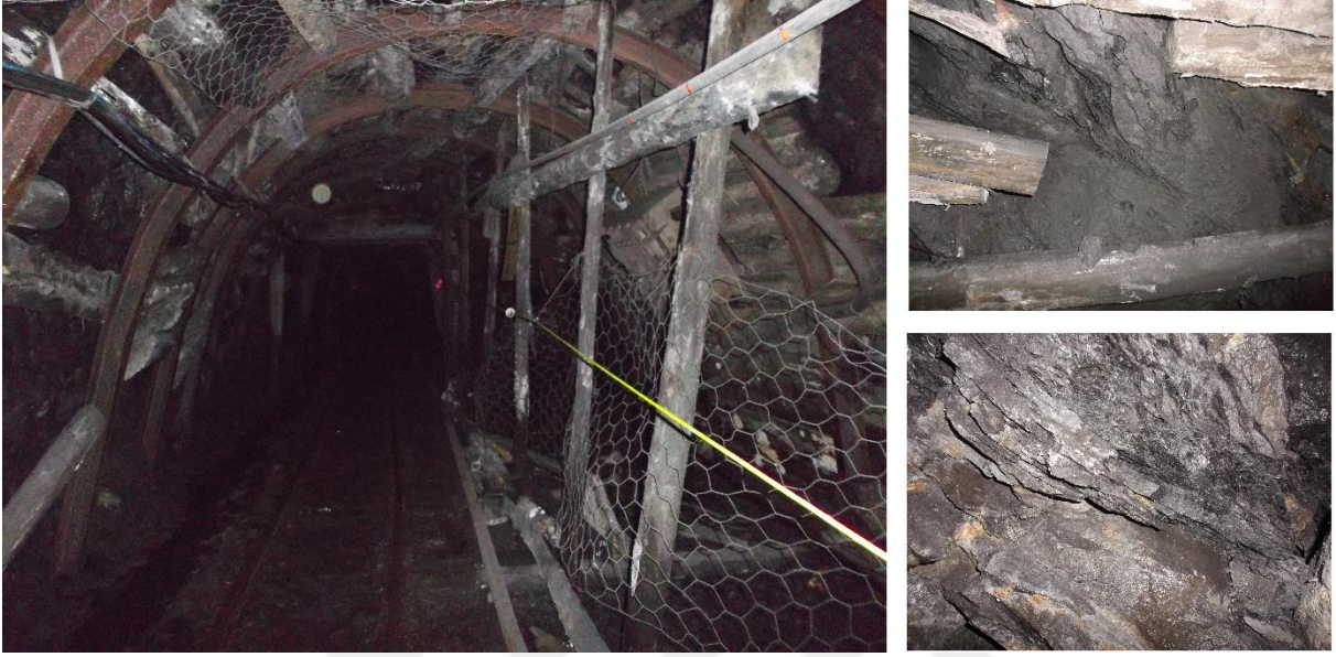
Şekil 4.7 +205 ana galerisinin 320. m'sinden görünüşü.
