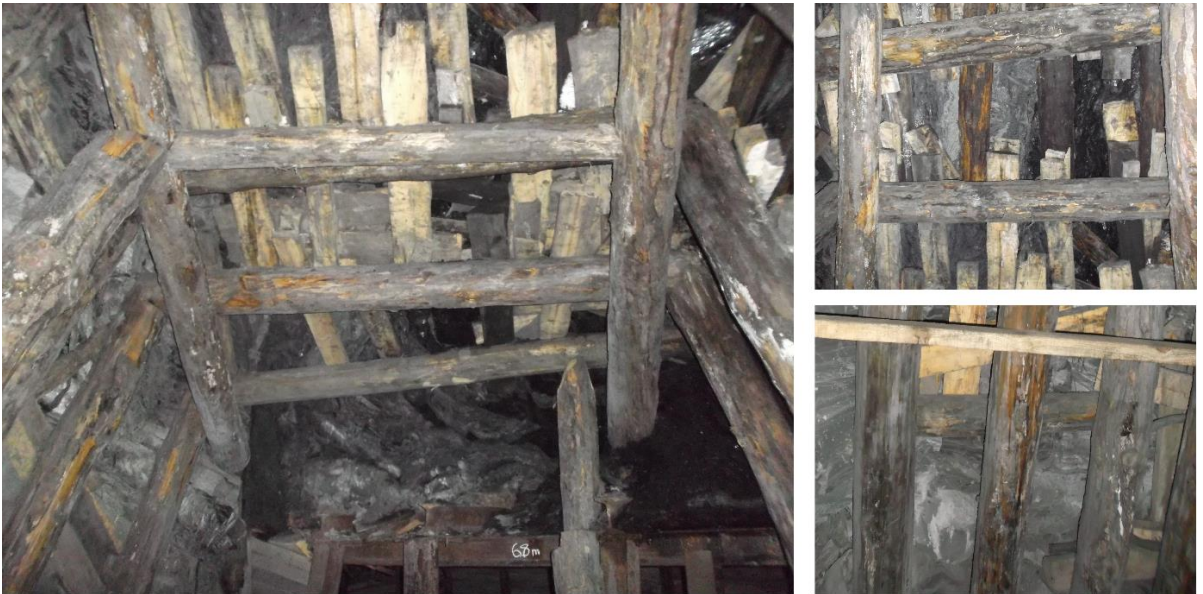
Şekil 4.38 +205/+175 yeni desandrenin 53.50 m ile 68 m arasından görünüşü.
