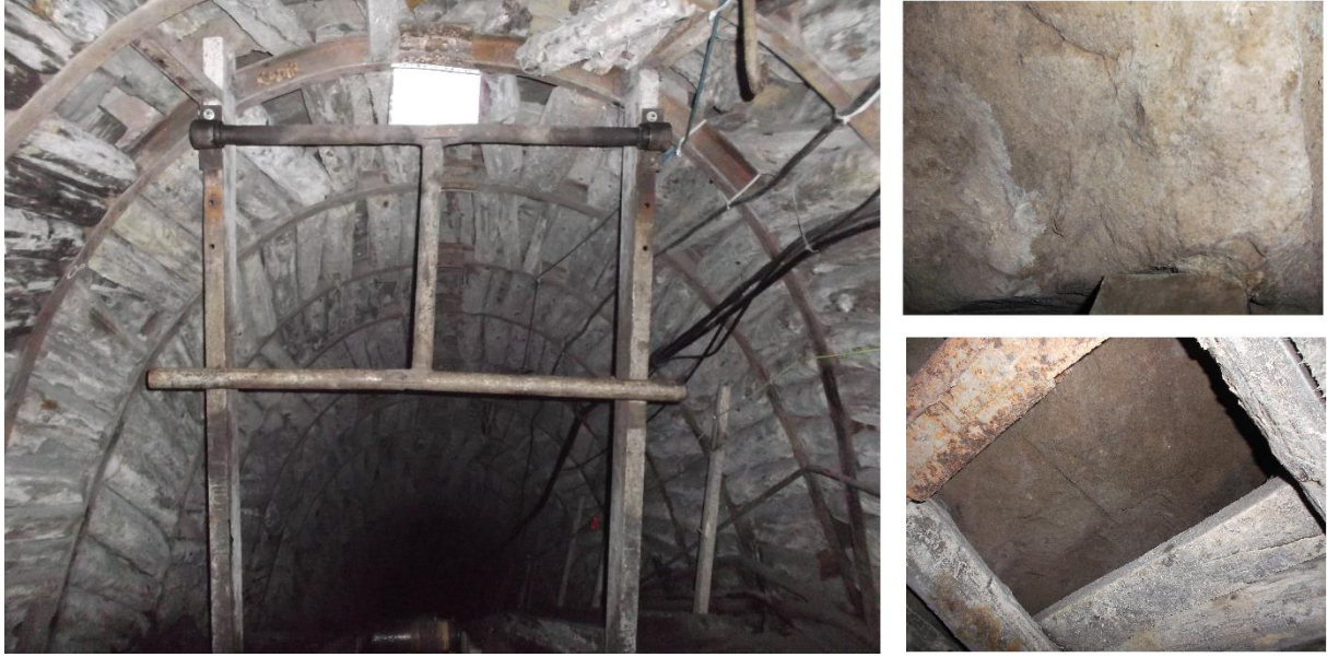
Şekil 4.17 +205/+175 ana nakliyat desandresinin 0 m ile 19 m arasından görünüşü.
