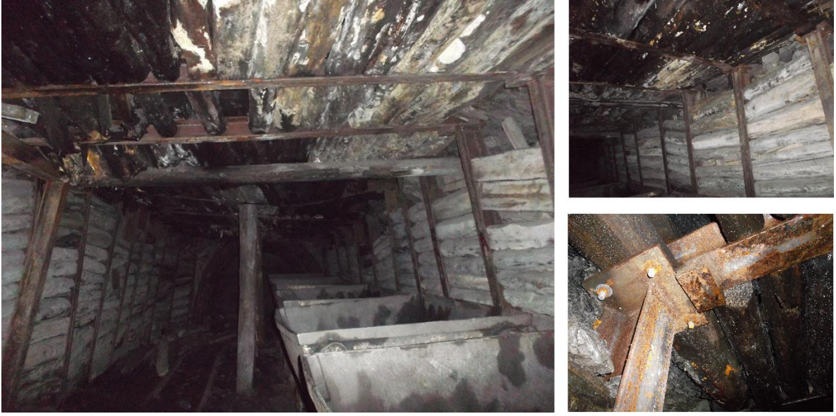
Şekil 4.30 +175 galerisinin 60 m ile 70 m arasından görünüşü.
