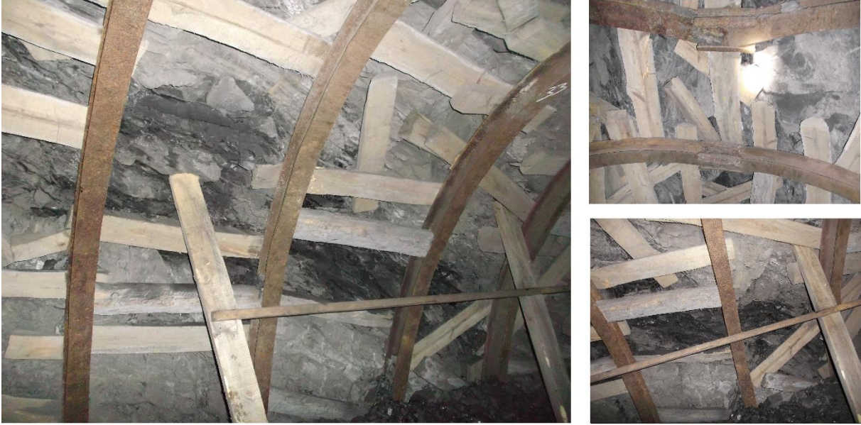
Şekil 4.36 +205/+175 yeni desandrenin 30 m ile 33 m arasından görünüşü.
