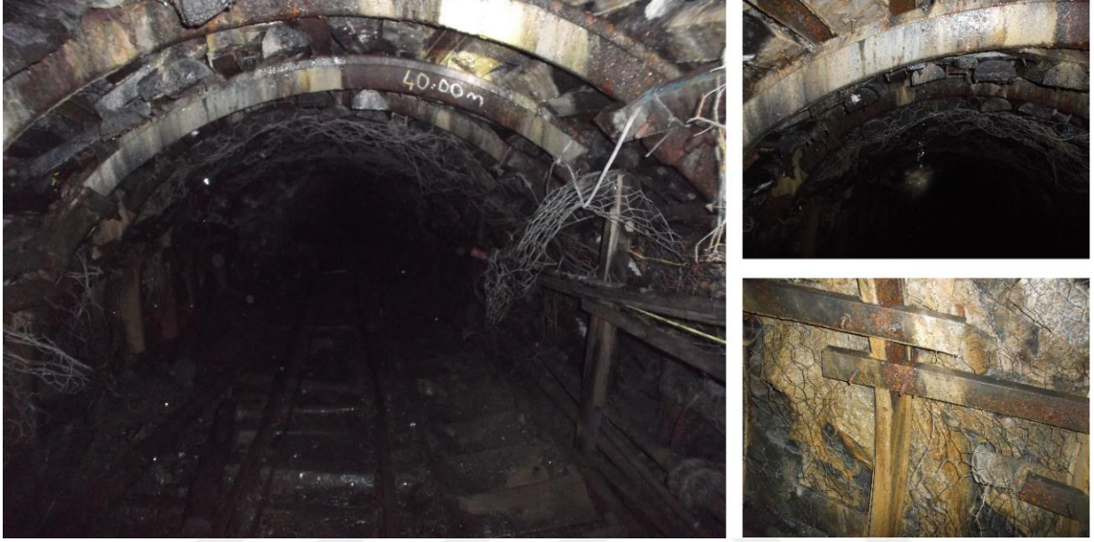
Şekil 4.21 +205/+175 ana nakliyat desandresinin 38 m ile 44 m arasından görünüşü.
