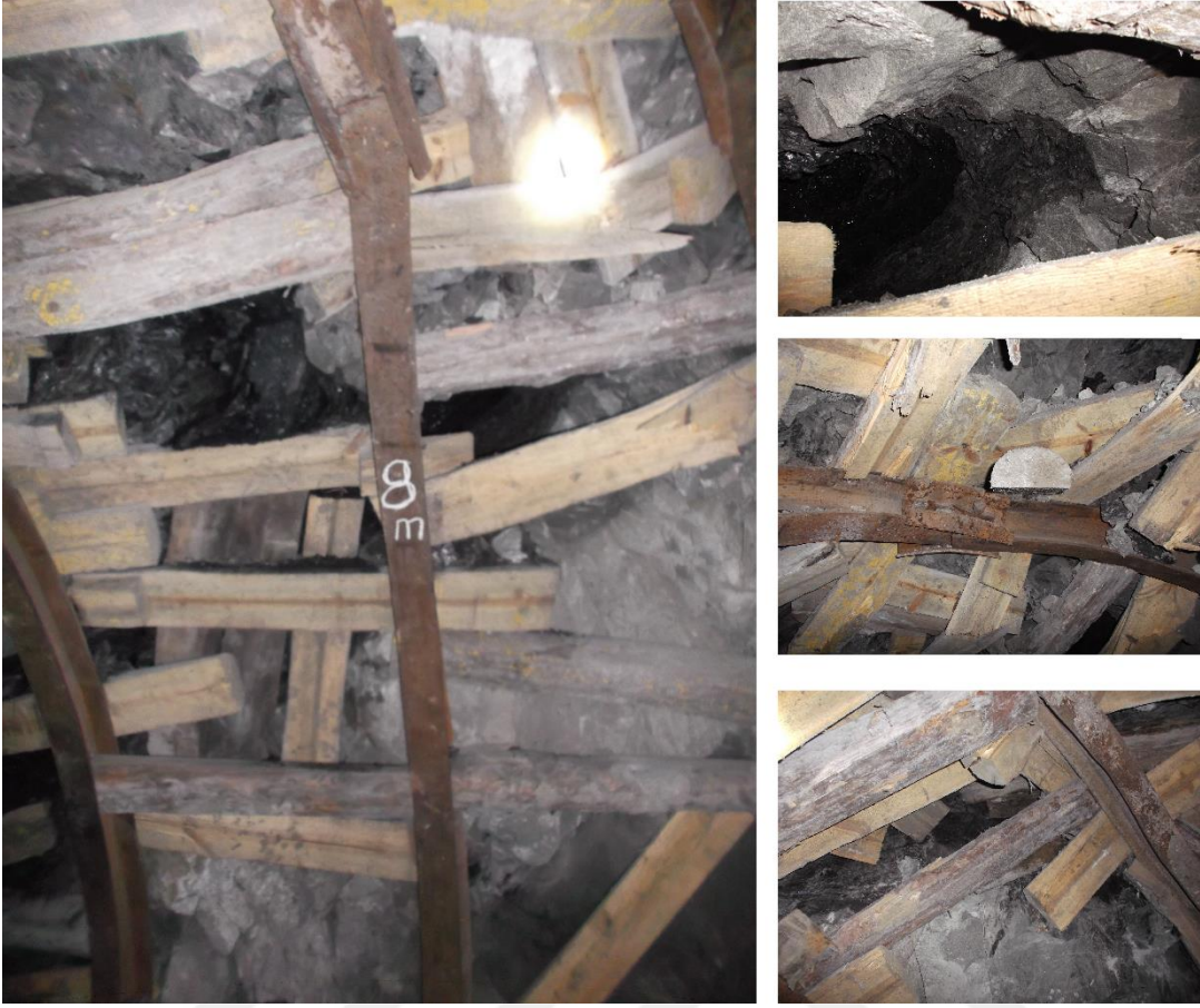
Şekil 4.33 +205/+175 yeni desandrenin 8 m ile 16.5 m arasından görünüşü.
