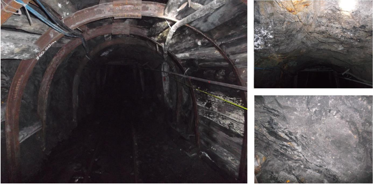
Şekil 4.8 +205 ana galerisinin 360. m'sinden görünüş.
