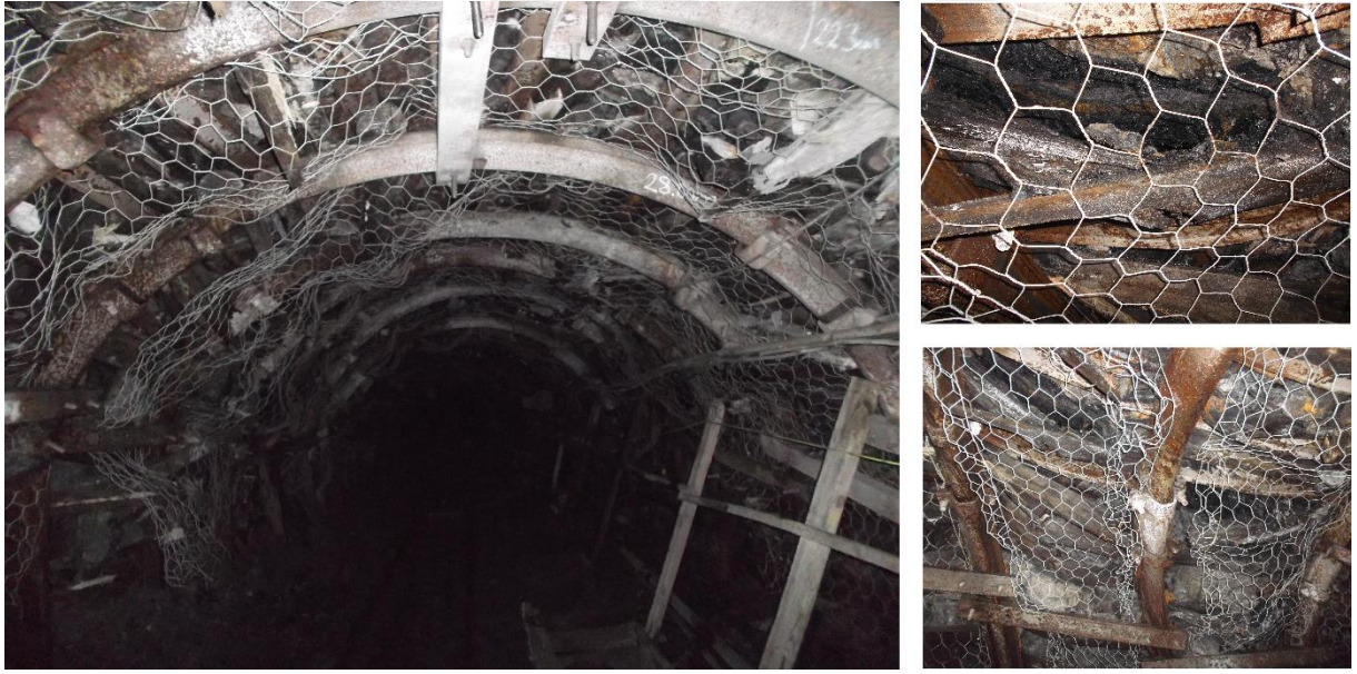
Şekil 4.20 +205/+175 ana nakliyat desandresinin 28 m ile 38 m arasından görünüşü.
