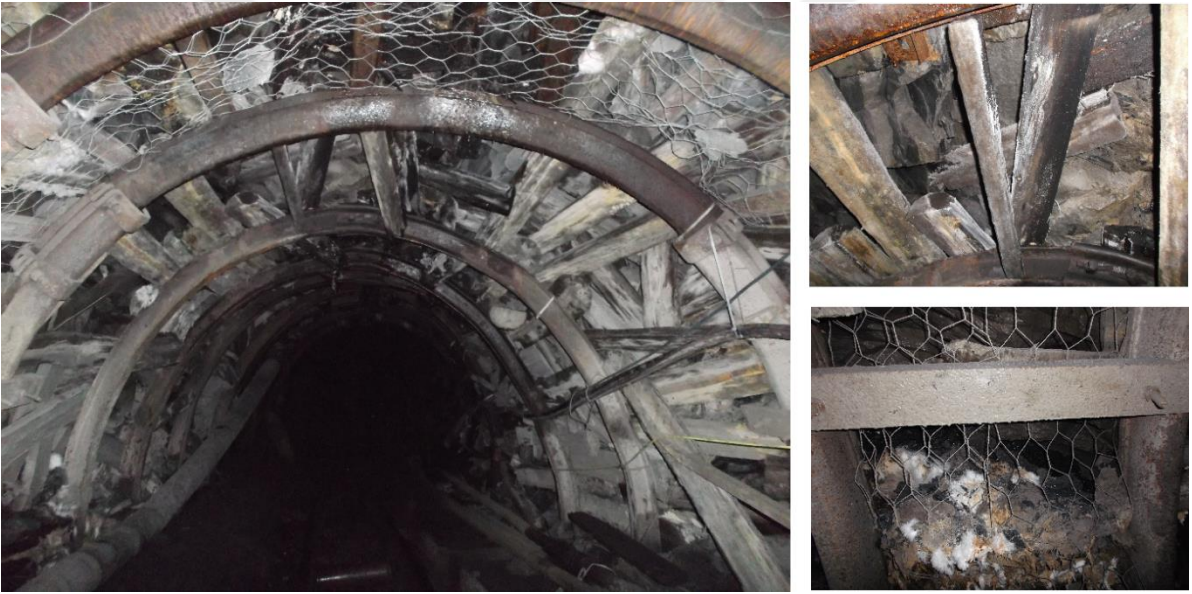
Şekil 4.23 +205/+175 ana nakliyat desandresinin 58. m'sinden görünüşü.
