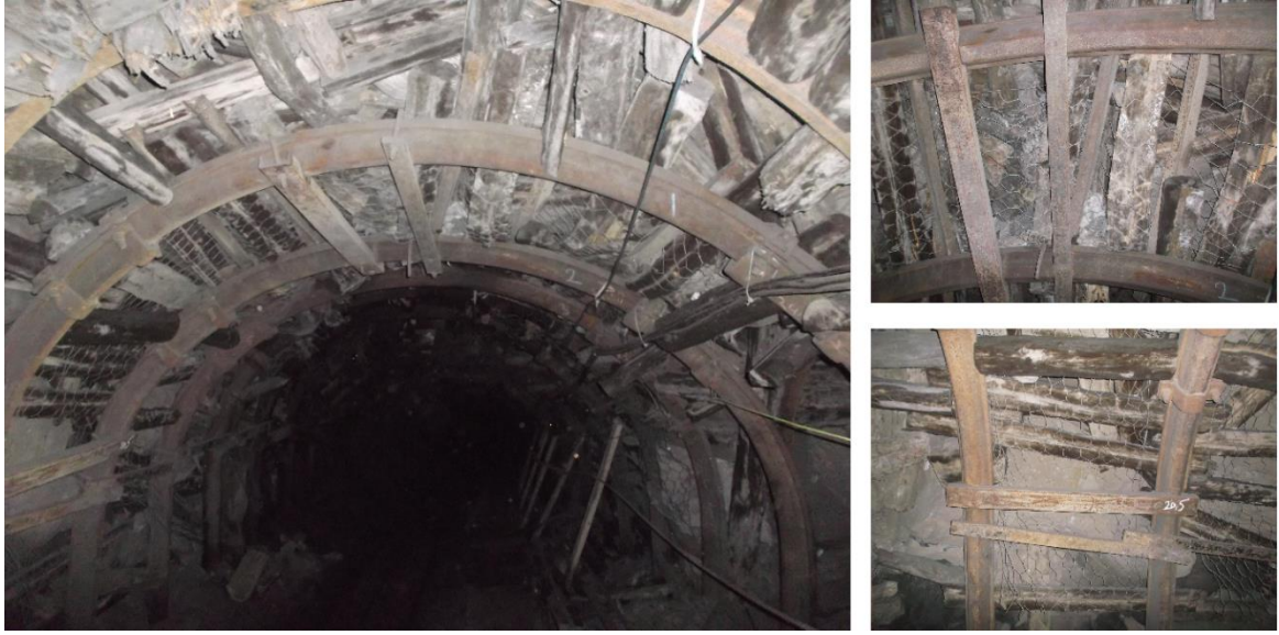
Şekil 4.18 +205/+175 ana nakliyat desandresinin 20. m'sinden görünüşü.
