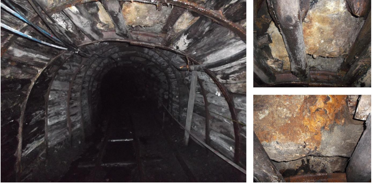
Şekil 4.9 +205 ana galerisinin 396. m'sinden görünüşü.
