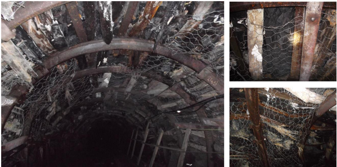
Şekil 4.19 +205/+175 ana nakliyat desandresinin 20 m ile 28 m arasından görünüşü.
