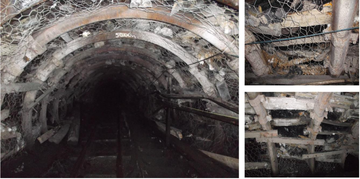
Şekil 4.22 +205/+175 ana nakliyat desandresinin 50. m'sinden görünüşü.
