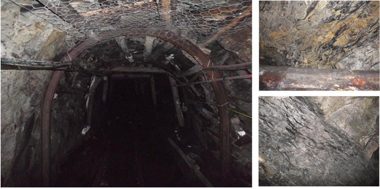
Şekil 4.5 +205 ana galerisinin 230. m'sinden görünüşü.
