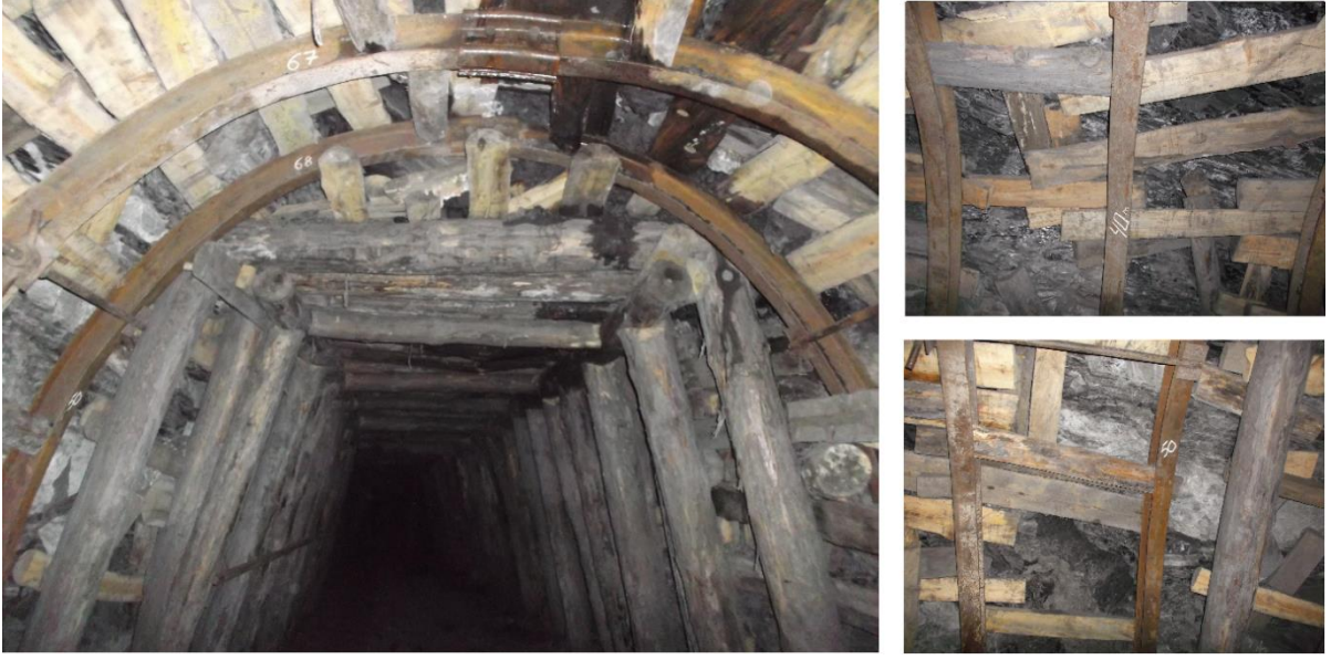
Şekil 4.37 +205/+175 yeni desandrenin 33 m ile 53.50 m arasından görünüşü.
