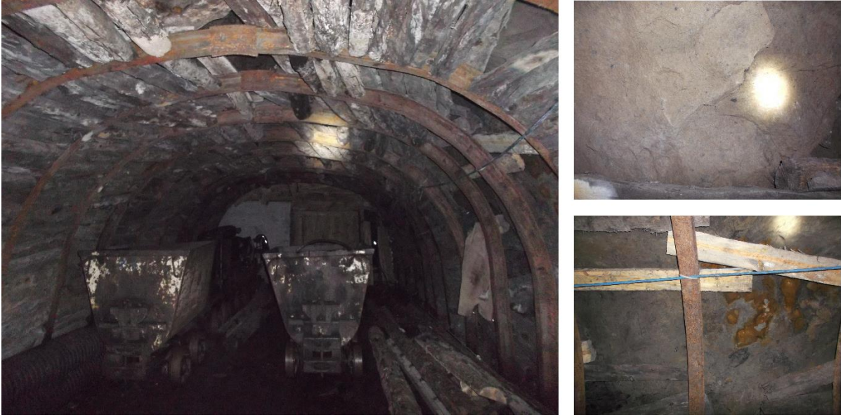
Şekil 4.12 +205 ana galerisinin 475. m'sinden görünüş.
