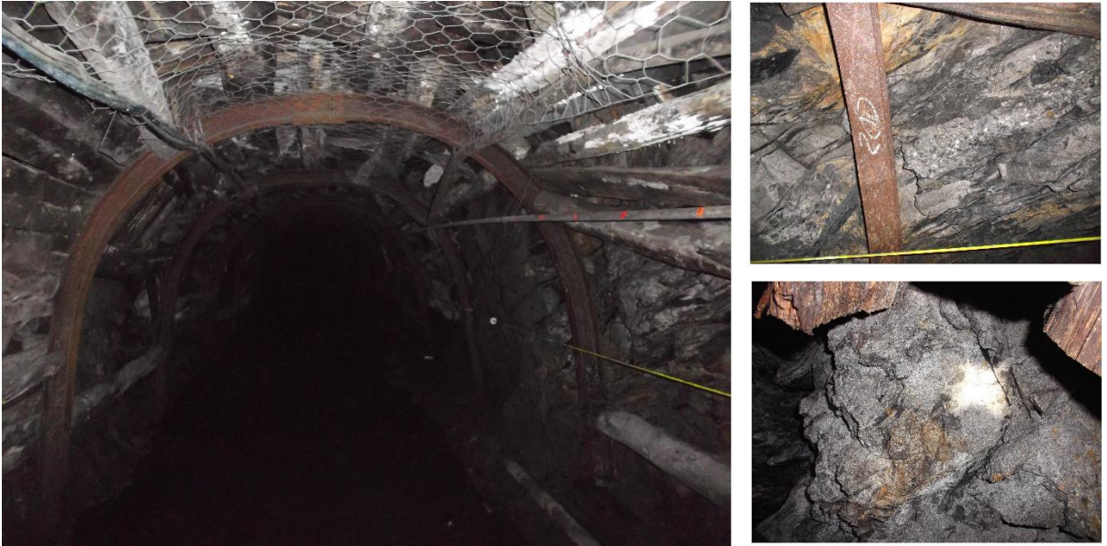
Şekil 4.4 +205 ana galerisinin 200. m'sinden görünüş.
