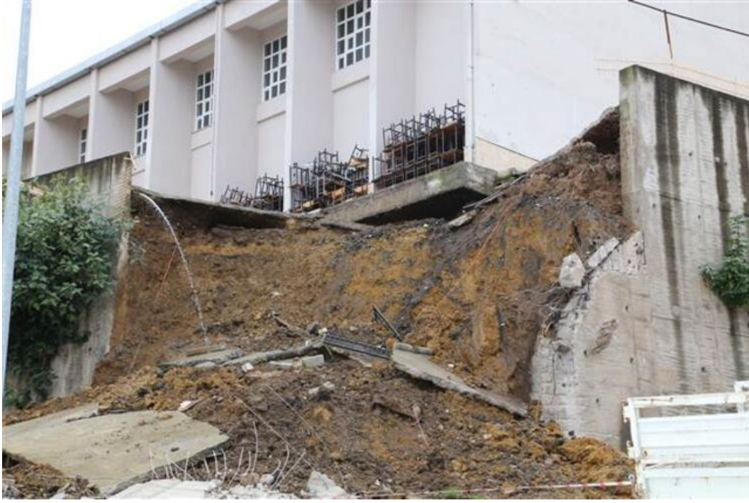
Şekil 1.2 Ekim 2018’de Ordu'nun Altınordu ilçesinde bir liseye ait kapalı spor salonu arkasındaki yağmur sebebi ile çöken istinat duvarı (URL-1).
