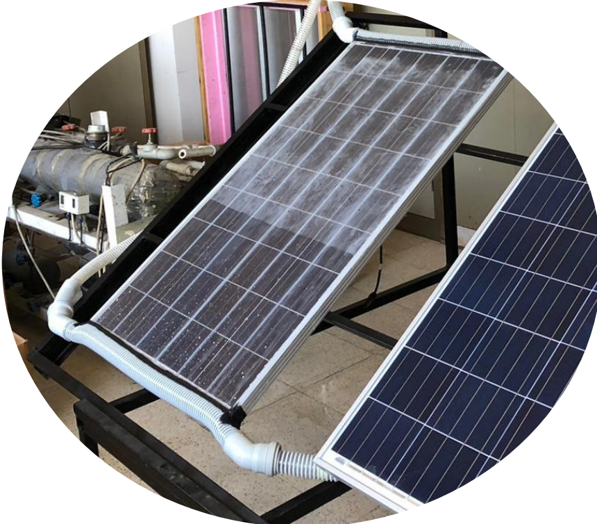
Şekil 3.5 Montaj edilmiş kolektörler.
