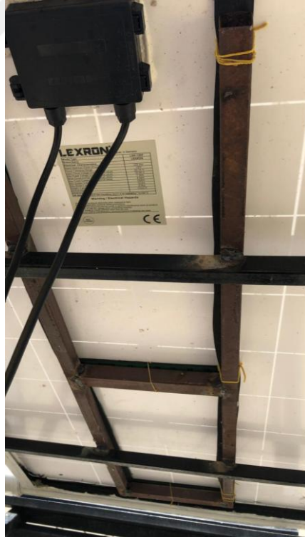
Şekil 3.15 PV-T sisteminin arka yüzeyinin kafes sistemi.
