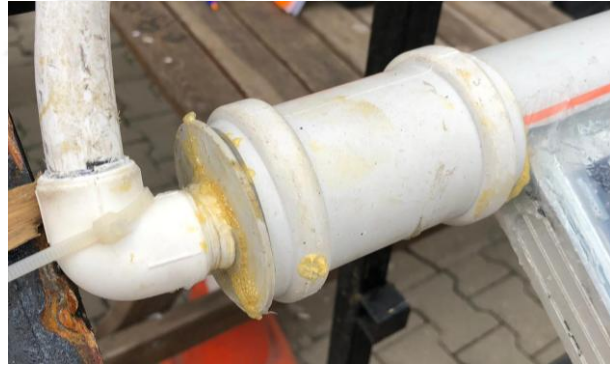
Şekil 3.20 Kollektör çıkış bağlantısı.
