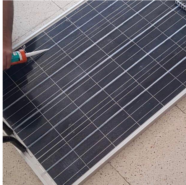
Őekil 3.3 Kanal oluřturacak boruların montajı.
