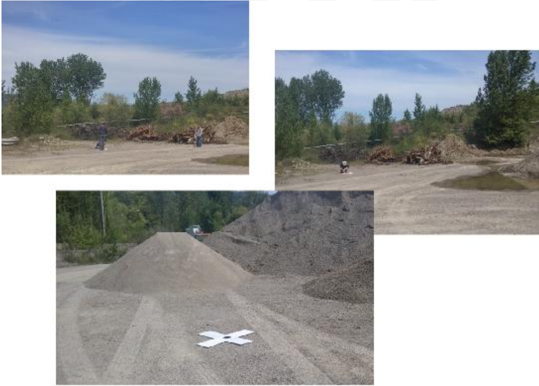
Şekil 3.2 YKN sahada uygulama çalışmaları.
