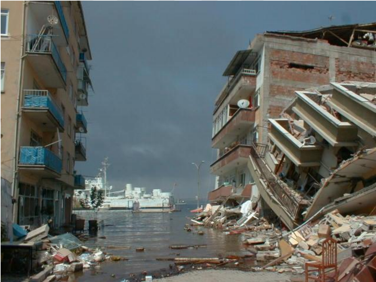
Şekil 4.1 Zemin Sıvılaşması Sonucu Ortaya Çıkan Hasarlar (Gölcük 1999).
