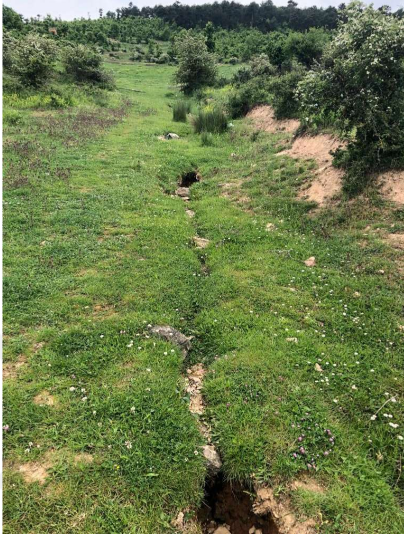
Şekil 7.2 İnceleme alanında oluşmuş yüzeysel su akış hattından genel görünüm
