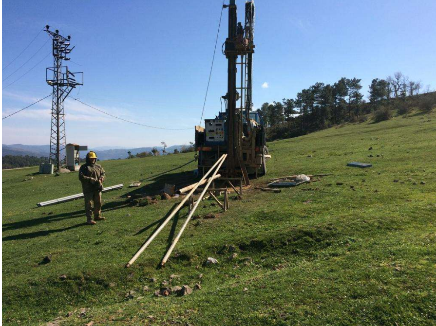
Şekil 4.1 SK-6 nolu sondaj çalışmasından görünüm.
