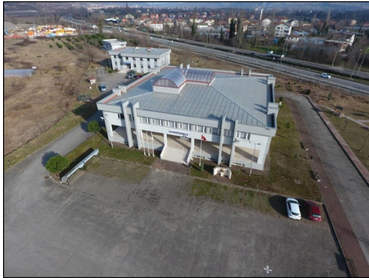
Şekil 3.1 Çalışma alanına ait hava fotoğrafı.
