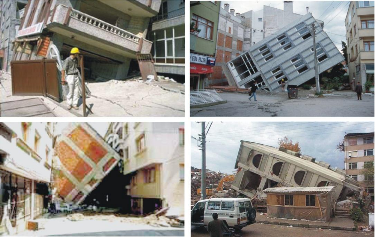
Şekil 3.3 17 Ağustos 1999 İzmit depreminde Sakarya'da sıvılaşmaya bağlı olarak meydana gelen hasarlar.
