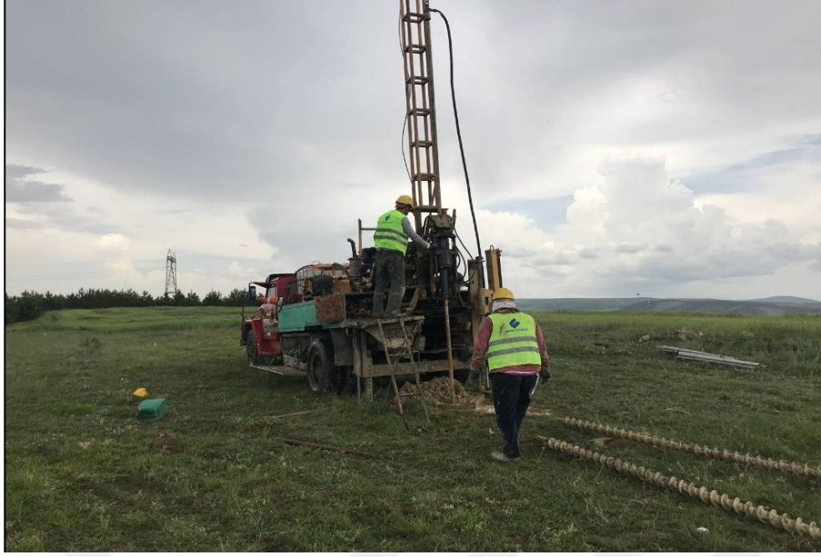
Şekil 4.2 İnceleme alanında SK-13 nolu sondaj çalışmalarından görüntü.
