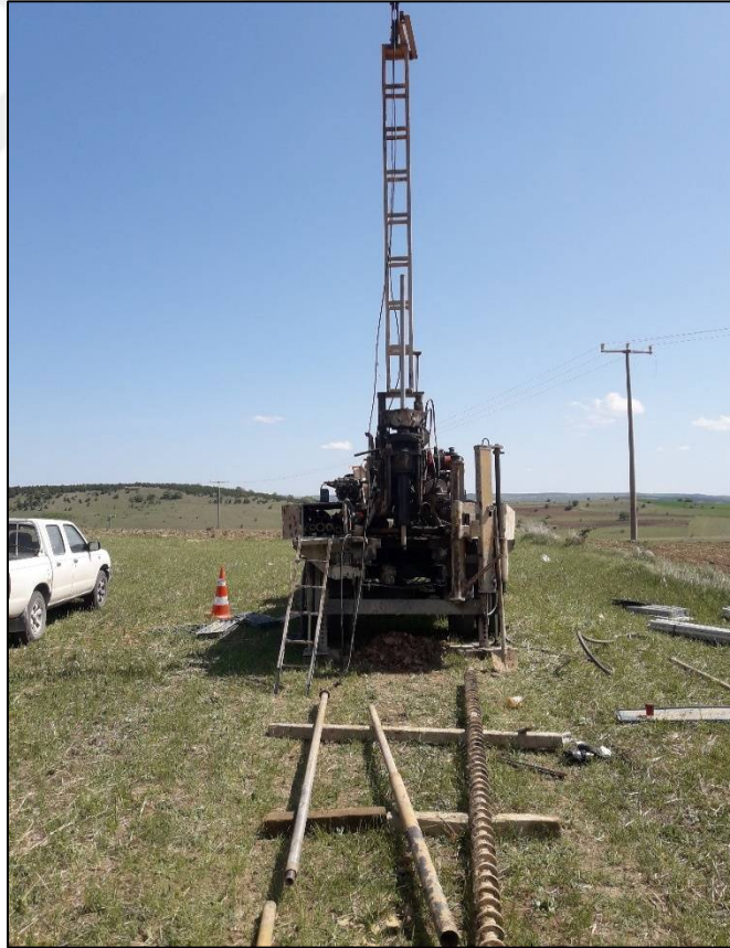
Şekil 4.1 İnceleme alanında SK7 nolu sondaj çalışmalarından görüntü.
