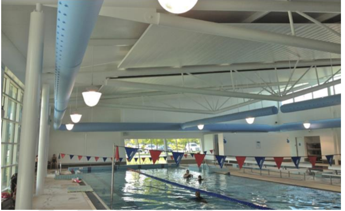
Şekil 2.13 Havuz havalandırma sistemi örneği IV
