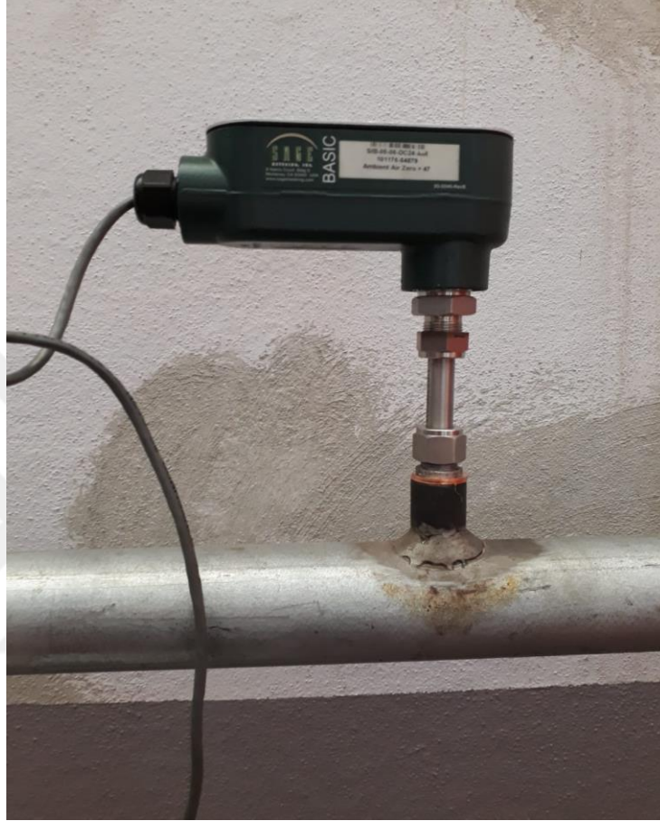
Şekil 3.14. Debimetrenin boru hattına montaj şekli
