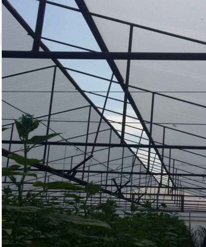
Şekil 4.6. Beşik çatılı plastik serada çatı havalandırma açıklığı
