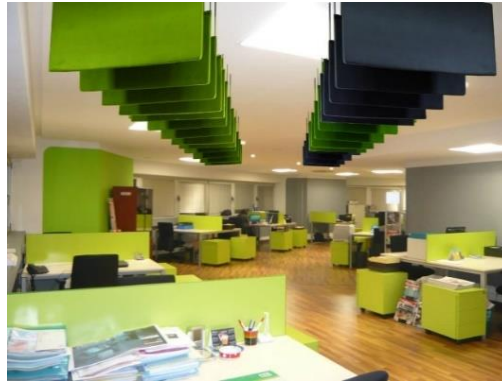
Şekil 2.17. Ofiste ses yalıtımı uygulaması (Anonim 2019i)
