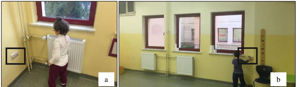
Şekil 4.20. a. Fen merkezi b. Hareketli oyun merkezi, işaretlenen alanlarda açık bırakılan prizler
