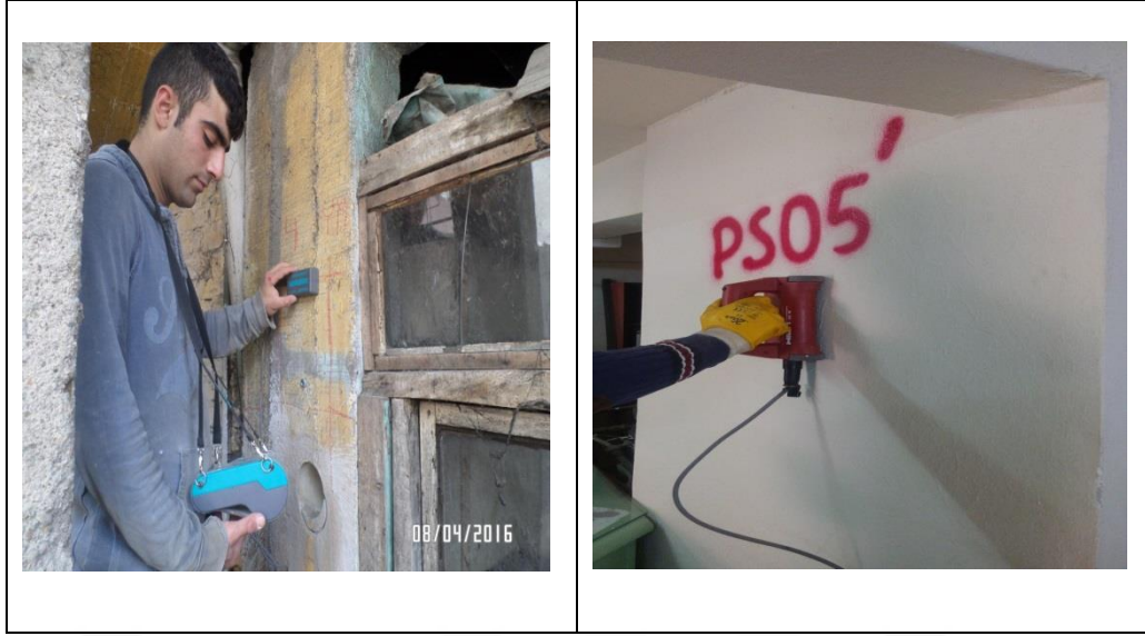
Şekil 2.10. Donatı tarama (tahribatsız) işlemi örneği
