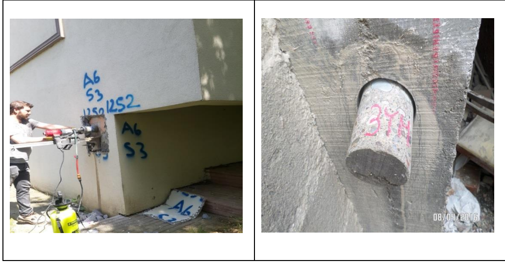
Şekil 2.12. Beton numunesi (karot) alınması işlemi örneği
