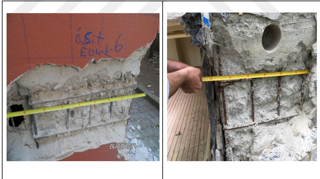
Şekil 2.9. Kabuk betonu sıyrma (tahribatlı) işlemi örneği
