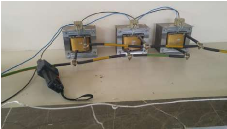
Şekil 4.14. Aşırı akım sonrası deforme olan kablo
