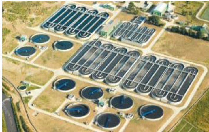
Şekil 3.1. BUSKİ Doğu Atıksu Arıtma Tesisi
