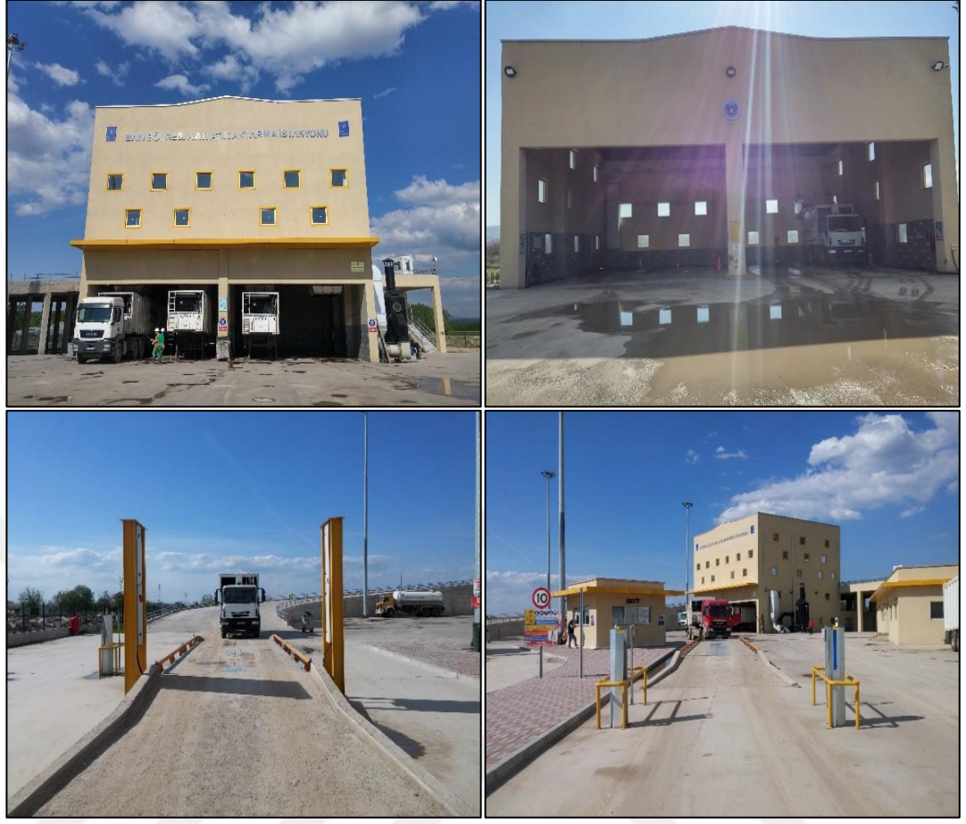
Şekil 3.6. Bursa Batı Bölgesi Katı Atık Aktarma İstasyonu
