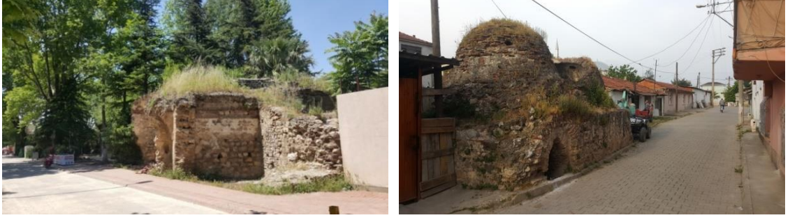
Şekil 4.107. Yeşil Cami Hamamı doğu cephesi, Küçük Hamam güneybatı cephesi günümüz durumu ve çevre yapılaşma
