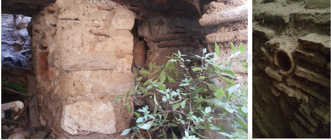
Şekil 4.80. Yeşil Cami Hamamı ve İsmail Bey Hamamı pişmiş toprak boru detayı
