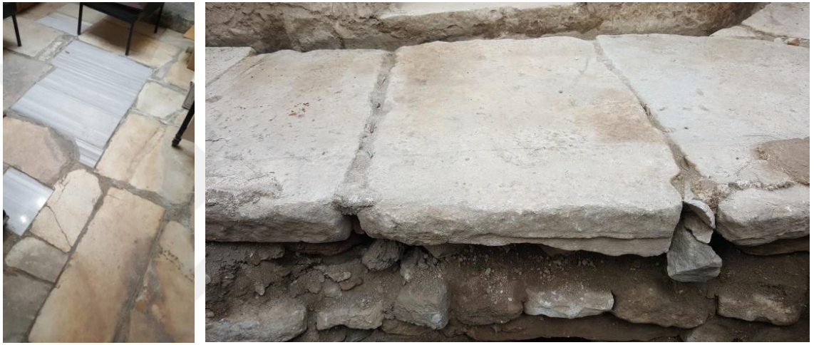
Şekil 4.2. II.Murat Hamamı ve Orhangazi Hamamı sıcaklık mekânları özgün döşeme örnekleri
