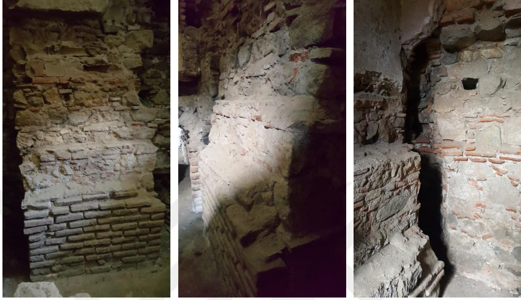
Şekil 3.45. İsmail Bey Hamamı güneydoğu halveti doğu duvarı ve sıcaklık ana mekân kuzey duvarındaki kademelenme görüntüsü
