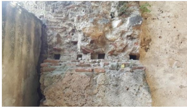
Şekil 4.7. Yeşil Cami Hamamı erkekler bölümü soyunmalık mekânı kuzey duvarı, duvar kesiti boyunca devam eden hatıl boşlukları
