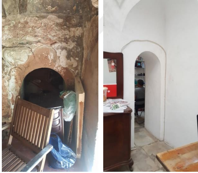
Şekil 4.27. Konak Hamamı, sıcaklık ve ılıklik mekân bağlantısını sağlayan yuvarlak kemerli geçiş açıklığı, II.Murat Hamamı kadınlar bölümü halveti yuvarlak kemerli geçiş açıklığı
