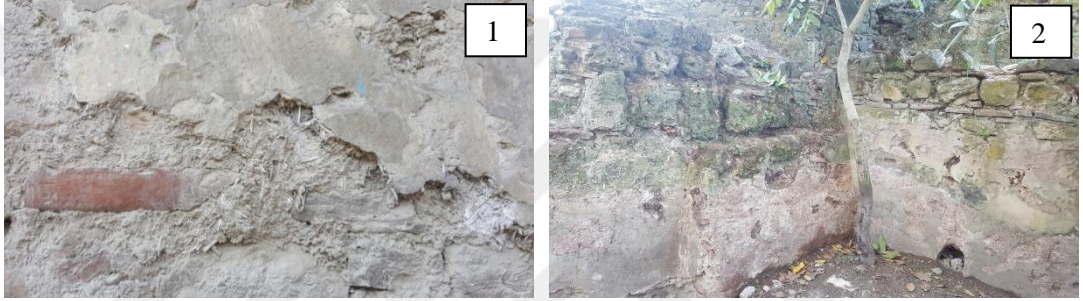
Şekil 4.11. 1) İsmail Bey Hamamı saman katkılı sıva örneği, 2) Orhangazi Hamamı su deposu horasan sıva uygulaması
