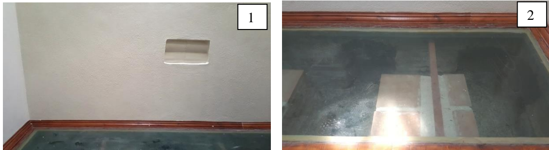
Şekil 3.13. I.Murat Hamamı erkekler bölümü sıcaklık mekânı 1) duvar içindeki künk dizimi, 2) esaslı onarımı yapılmış yığma ayaklar
