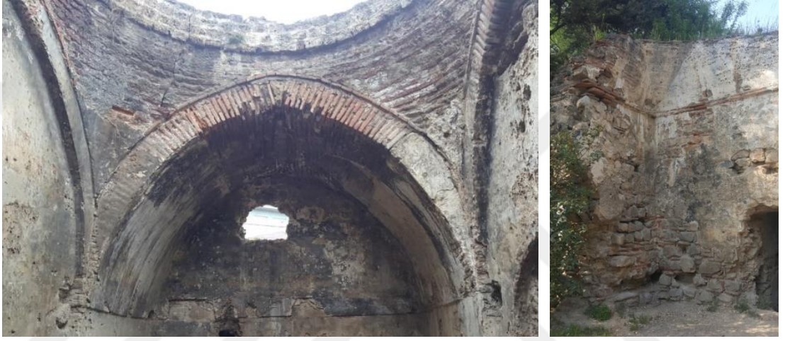
Şekil 3.71. Yeşil Cami Hamamı erkekler bölümü sıcaklık ana mekânında kullanılan pandantifler ve yıkılan kadınlar bölümü soyunmalık mekânında düzlem üçgen kullanımı
