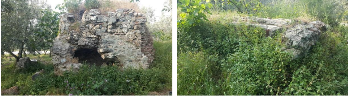
Şekil 3.64. Orhangazi Hamamı yapı üzerinde ve çevresindeki bitki oluşumları (kazı öncesi durumu)
