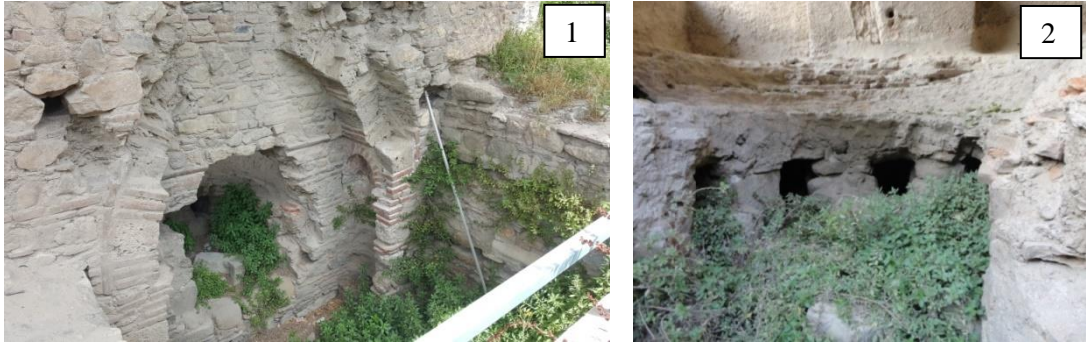
Şekil 3.43. İsmail Bey Hamamı 1) ocak kemeri, 2) ocak ve cehennemlik ana kanalların görünümü (BBB 2016)
