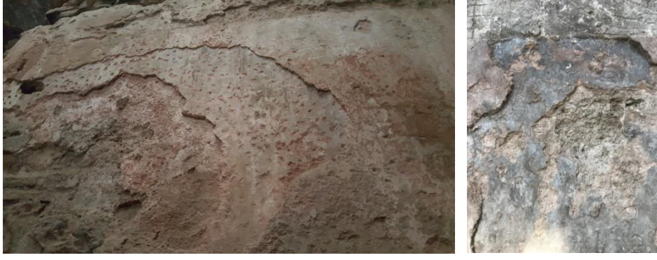
Şekil 4.10. İsmail Bey Hamamı güneydoğu halveti kuzey duvarı üç tabaka sıva uygulaması ve Orhangazi Hamamı kuzeybatı halveti kuzey duvarı sıva katmanları
