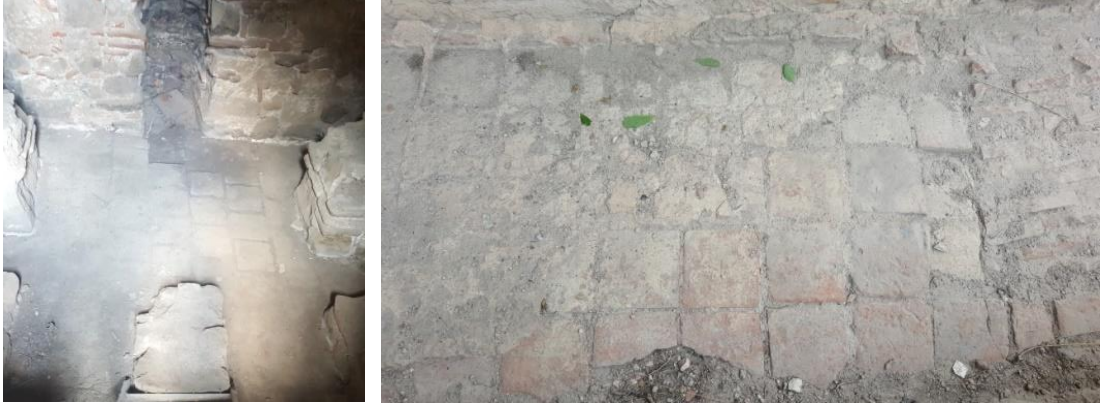
Şekil 4.128. İsmail Bey Hamamı özgün döşeme tuğlalarındaki aşınmalar
