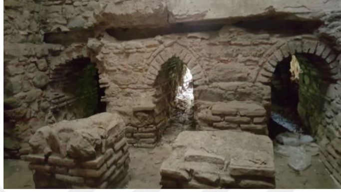
Şekil 4.71. İsmail Bey Hamamı güneydoğu halvetinden külhana bağlanan cehennemlik kanalları
