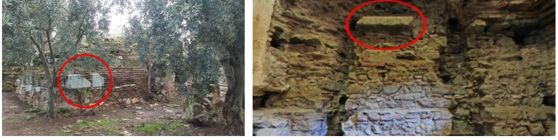
Şekil 4.22. Orhangazi Hamamı su deposu batı duvarı kaba küfeki, tuğla ve devşirme mermer kullanımı, İsmail Bey Hamamı güneydoğu halveti doğu duvarı moloz taş, tuğla ve devşirme mermer kullanımı
