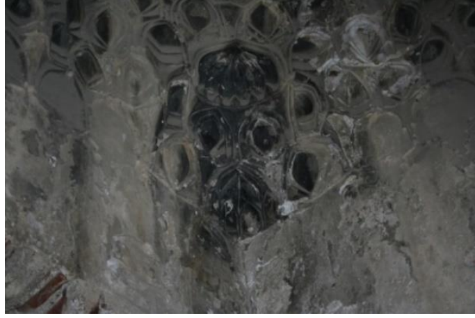
Şekil 4.33. İsmail Bey Hamamı sıcaklık ana mekân mukarnaslı tromp uygulaması (BBB 2016)
