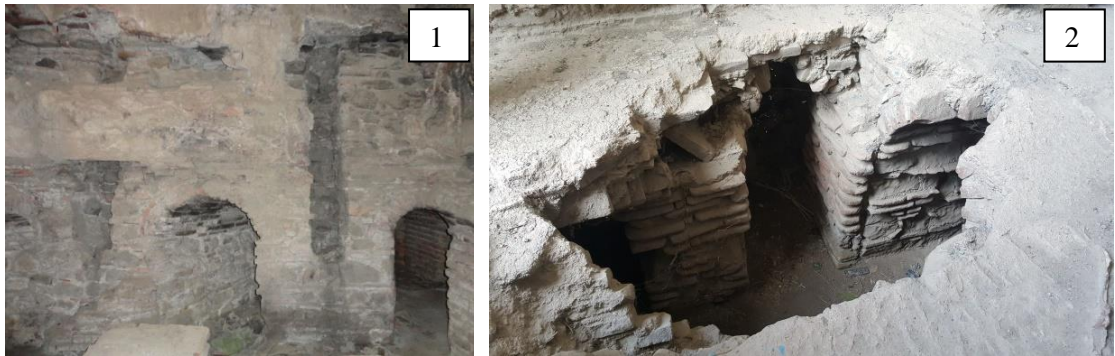
Şekil 3.47. İsmail Bey Hamamı 1) güneydoğu halvetinden, ılık yan birime bağlanan cehennemlik kanalları (BBB 2016), 2) ılık mekânı cehennemlik kanalları
