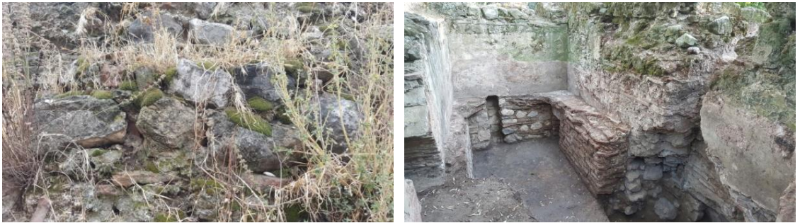
Şekil 4.125. Küçük Hamam kubbelerindeki ve Orhangazi Hamamı su deposu iç duvarlarında kazı sonrası açığa çıkan yosun oluşumları
