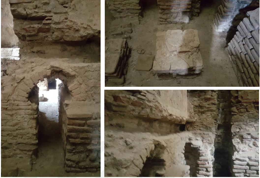
Şekil 4.113. İsmail Bey Hamamı güneydoğu halveti döşeme altındaki cehennemlik kanal kemerleri ve yağma ayaklardaki parça kopmaları
