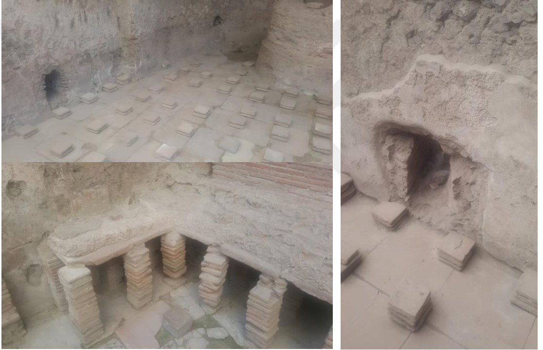
Şekil 4.65. Roma Hamamı Hypocaust sistemi (Pompei hamamı 2018)
