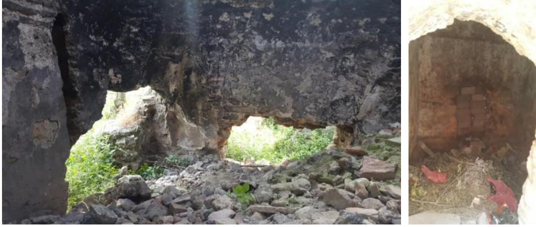
Şekil 4.130. Orhangazi Hamamı (kazı öncesi durumu) ve Küçük Hamam döşemelerindeki moloz ve çöp yığınları
