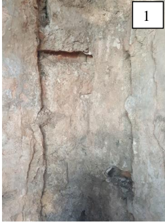
Şekil 3.60. Orhangazi Hamamı kuzeybatı halveti 1) kuzey duvarı, 2) doğu duvarındaki paralel iki sıra künk dizimi ve musluk izi
