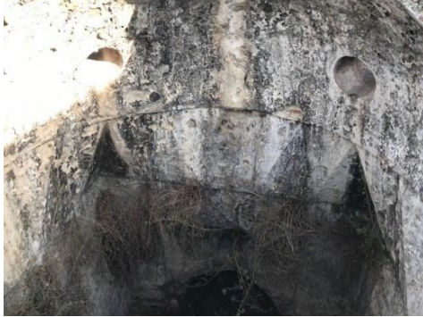
Şekil 4.36. Küçük Hamam sıcaklık ana mekân ve İsmail Bey Hamamı ılıkılık mekânı tek sıra üçgen kuşak kullanımı
