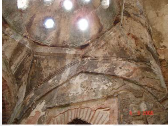
Şekil 4.43. I.Murat Hamamı esaslı onarım öncesi kadınlar bölümü sıcaklık ana mekân sekizgen kubbe tabanı (Kula Say 2007)
