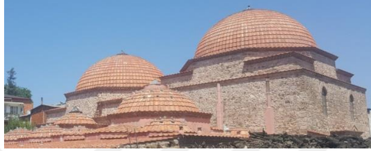
Şekil 4.52. I.Murat Hamamı ve II.Murat Hamamı üst örtülerindeki aydınlık fenerleri
