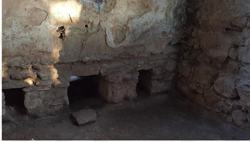
Şekil 4.66. Orhangazi Hamamı mevcut halvet cehennemlik kanal detayları (kazı sonrası durumu)
