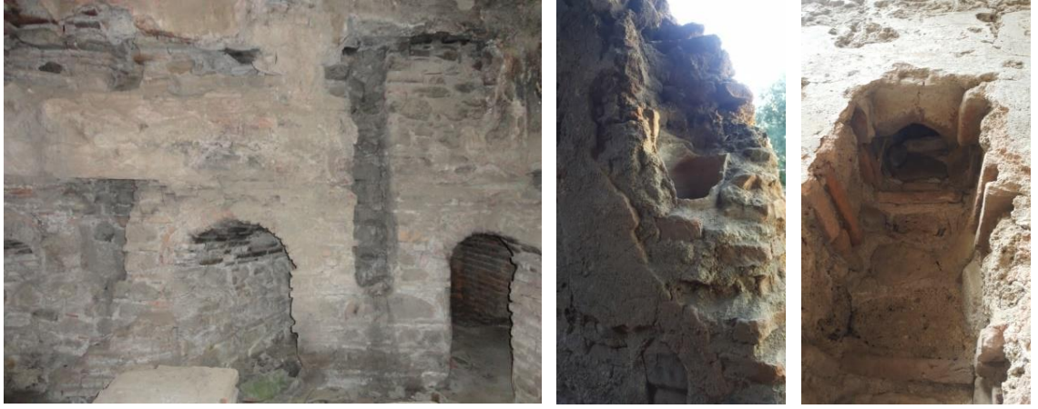
Şekil 4.81. İsmail Bey Hamamı güneydoğu halveti batı duvarı, Orhangazi Hamamı kuzeybatı halveti güney duvarı, Yeşil Cami Hamamı sıcaklık ana mekân batı duvarı tüteklilikleri
