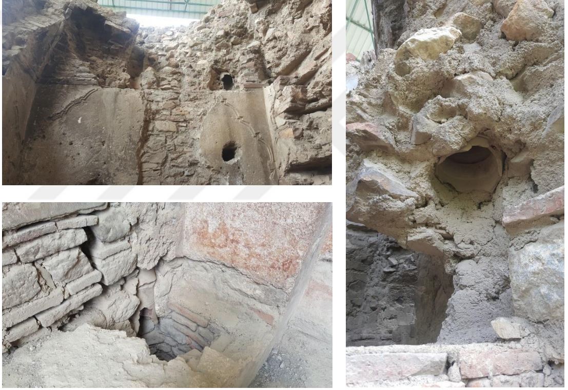
Şekil 3.48. İsmail Bey Hamamı ılıkık mekânı kuzey ve batı duvarı tüteklikleri
