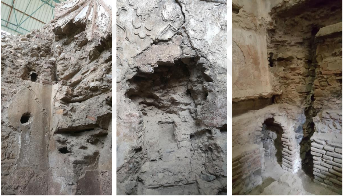
Şekil 4.93. İsmail Bey Hamamı ılıklik mekânı kuzey, ılıklik birimi doğu ve güneydoğu halveti doğu duvarlarındaki malzeme kopmaları, enkesit azalmaları
