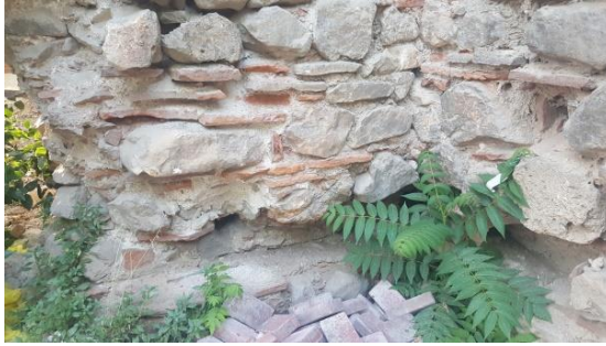
Şekil 4.111. Yeşil Cami Hamamı kadınlar bölümü soyunmalık mekânı duvar kalıntısı, Orhangazi Hamamı kuzeybatı halvet batısındaki duvar kalıntısına ait moloz taş ve tuğla malzemedeki şekil bozulmaları
