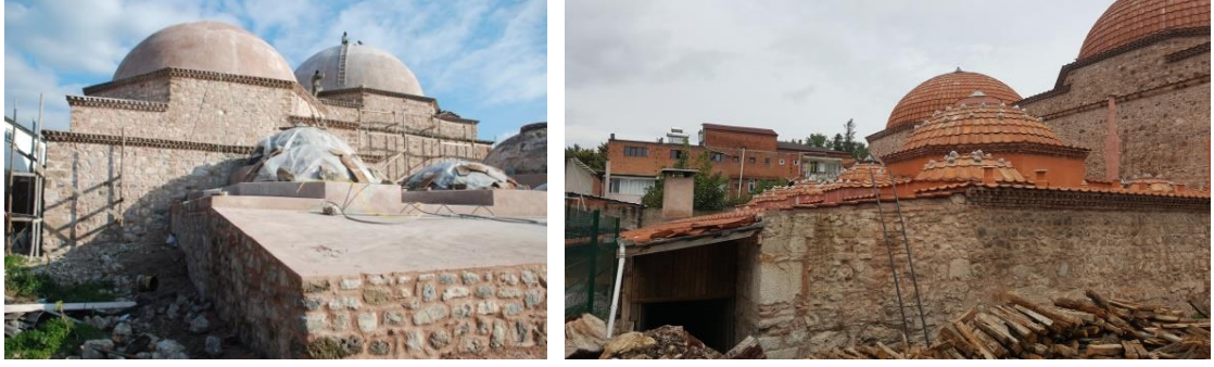
Şekil 4.48. II.Murat Hamamı su deposu ve külhan bölümü restorasyon aşaması (BVBM 2011) ve günümüz durumu
