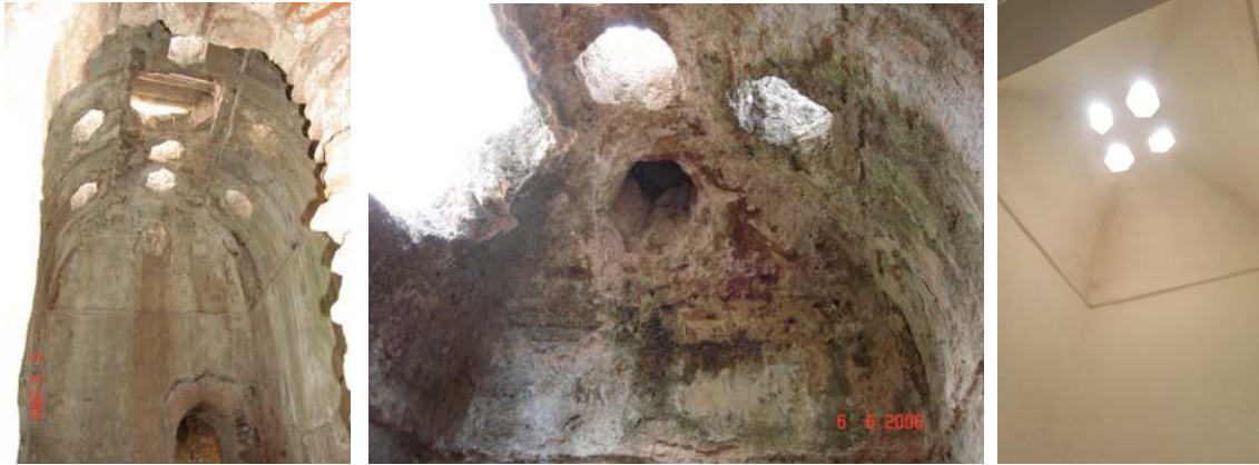
Şekil 4.46. I.Murat Hamamı kadınlar bölümü ılıklik mekânı ve temizlik birimi aynalı tonozları esaslı onarım öncesi durumu (Kula Say 2007), II.Murat Hamamı kadınlar bölümü temizlik birimi
