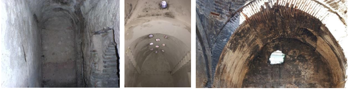
Şekil 4.45. I.Murat Hamamı erkekler bölümü koridor (BVBM 2005), II.Murat Hamamı erkekler bölümü ılıklik mekân kuzeyi, Yeşil Cami Hamamı eyvan beşik tonozları
