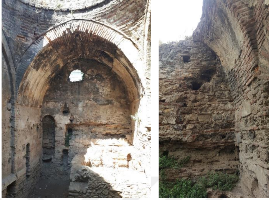
Şekil 3.72. Yeşil Cami Hamamı erkekler bölümü sıcaklık ana mekân kuzey eyvan tonozu ve yıkılan doğu halveti eyvan tonozu
