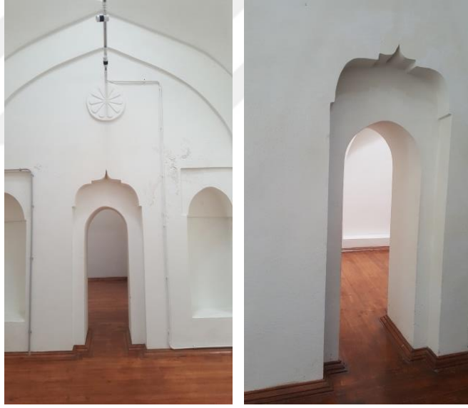
Şekil 4.29. I.Murat Hamamı sıcaklık ana mekânı, halvet ve ılıklik mekânı geçiş boşluk kemerleri
