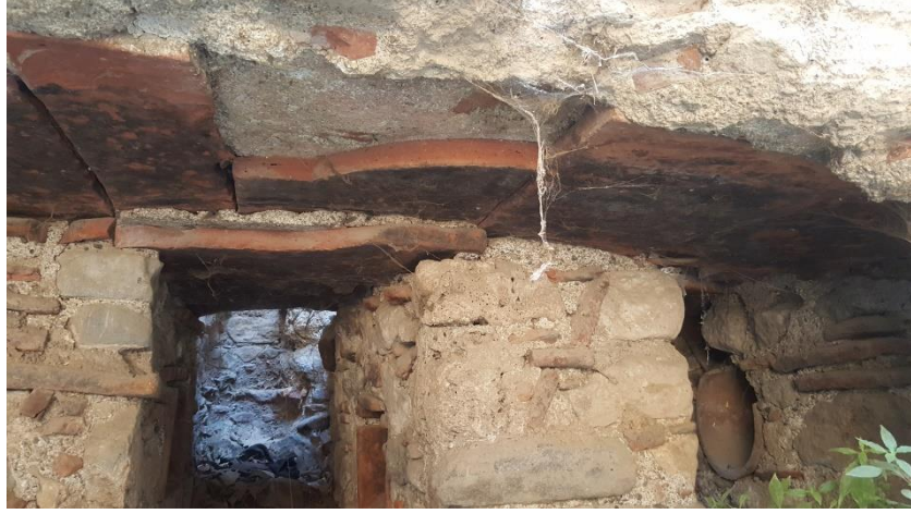
Şekil 4.77. Yeşil Cami Hamamı güney eyvanını taşıyan yığma ayaklar
