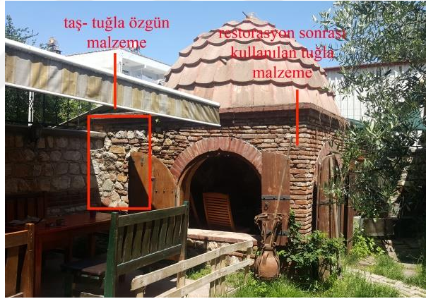
Şekil 4.23. Konak Hamamı duvar bütününde tuğla malzeme kullanımı
