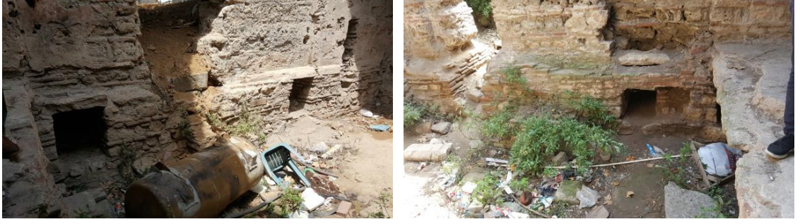
Şekil 3.74. Yeşil Cami Hamamı erkekler bölümü cehennemlik batı ve doğu duvarları
