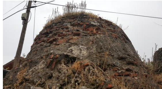
Şekil 4.112. Orhangazi Hamamı ve Küçük Hamam kubbelerini oluşturan tuğla malzemedeki şekil bozulmaları
