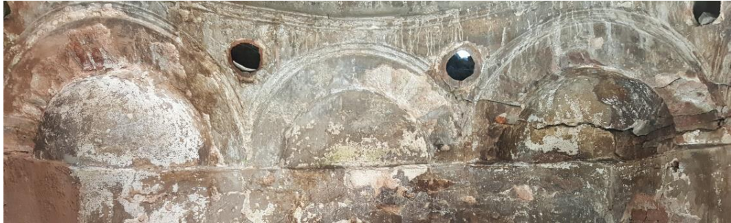
Şekil 3.90. Konak Hamamı sıcaklık mekânı hafifletme küpleri
