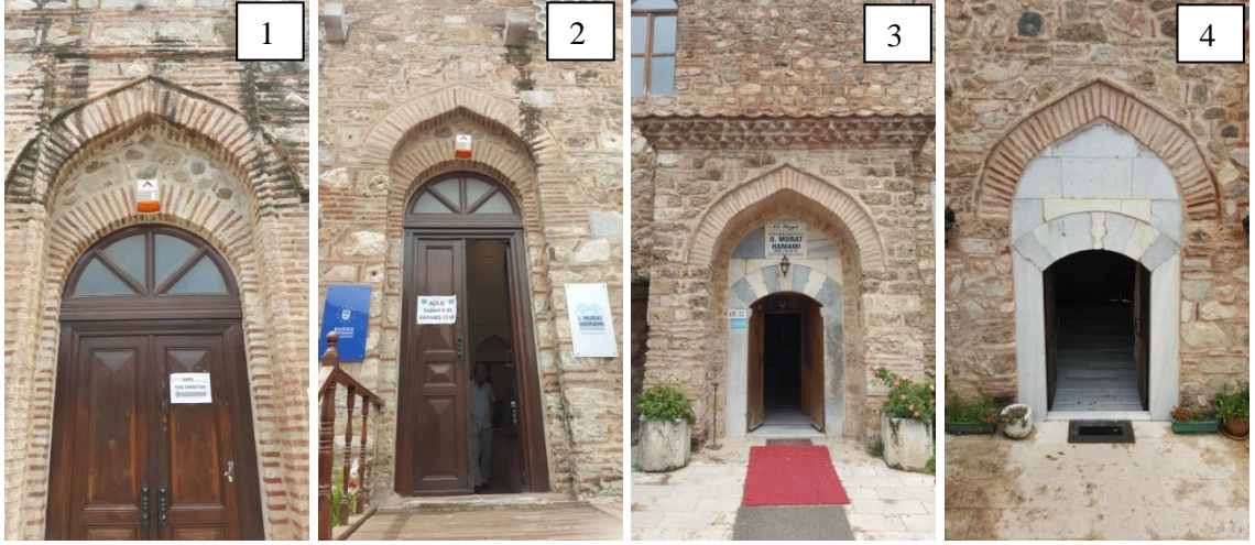
Şekil 4.28. 1) I.Murat Hamamı erkekler bölümü, 2) I.Murat Hamamı kadınlar bölümü, 3) II.Murat Hamamı erkekler bölümü, 4) II.Murat Hamamı kadınlar bölümü soyunmalık mekânları yuvarlak/ basık yuvarlak kemerli ve üzerinde sivri kemer kademeli giriş boşlukları
