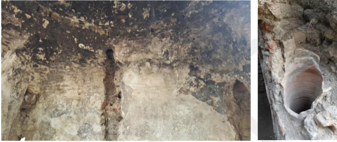
Şekil 3.63. Orhangazi Hamamı kuzeybatı halveti kuzey ve güney duvarındaki tüteklikler
