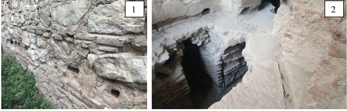
Şekil 3.42. İsmail Bey Hamamı 1) kuzey dış duvarı künk dizimi ve musluk delikleri, 2) ılıklik mekânı zeminindeki pis su kanalı ve pis su borusu
