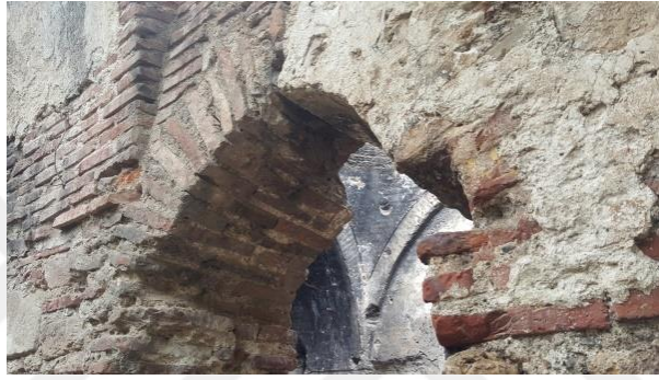
Şekil 4.24. Yeşil Cami Hamamı boşluk kemiği tuğla örgü detayı
