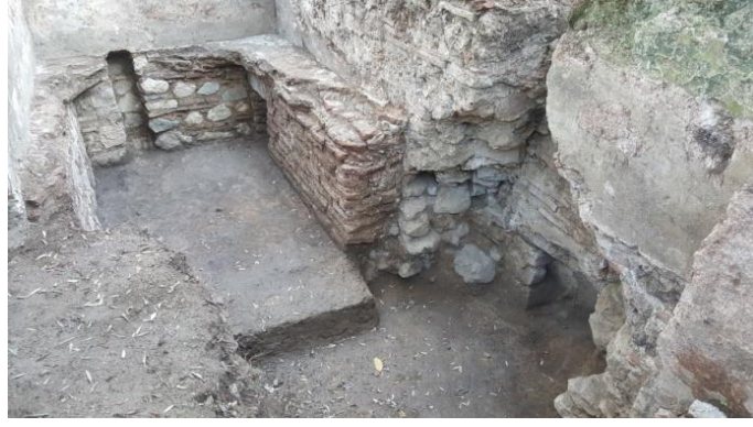
Şekil 3.59. Orhangazi Hamamı su deposu iç mekânı (kazı sonrası durumu)
