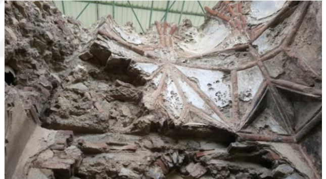
Şekil 4.36. Küçük Hamam sıcaklık ana mekân ve İsmail Bey Hamamı ılıkılık mekânı tek sıra üçgen kuşak kullanımı
