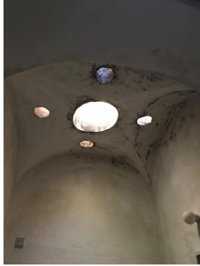
Şekil 4.47. II.Murat Hamamı erkekler bölümü ılıkılık mekânı güneyindeki çapraz tonoz
