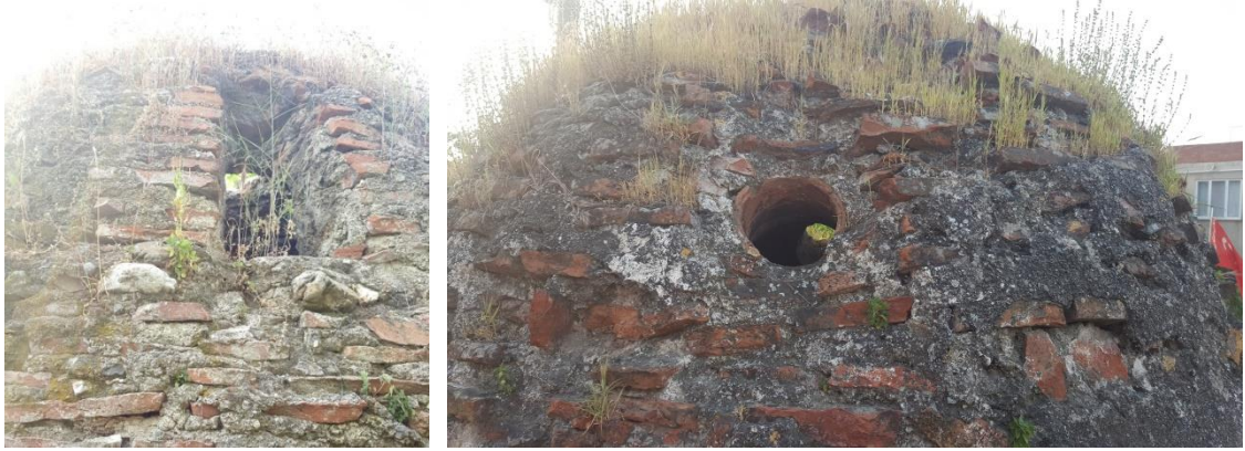
Şekil 4.40. Orhangazi Hamamı ve Küçük Hamam kubbelerindeki tuğla örgüleri
