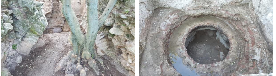
Şekil 3.58. Orhangazi Hamamı ocak kemer kalıntısı ve suyun ısıtıldığı özgün olmadığı düşünülen bakır kazan boşluğu (kazı sonrası durumu)
