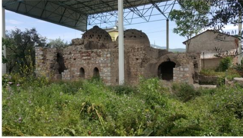
1--> Batı cephesinden görünüm
