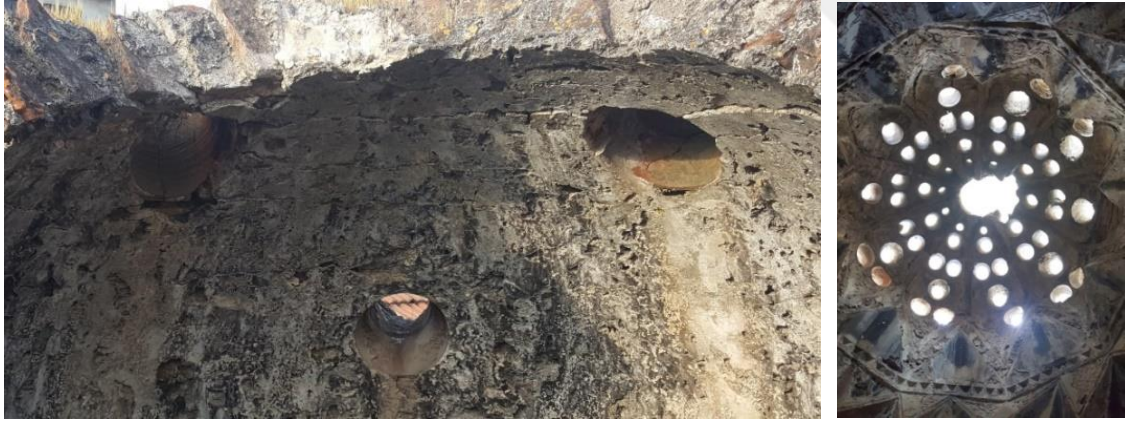
Şekil 4.132. Küçük Hamam kubbesi ve İsmail Bey Hamamı güneydoğu halveti ışık gözü çatlakları
