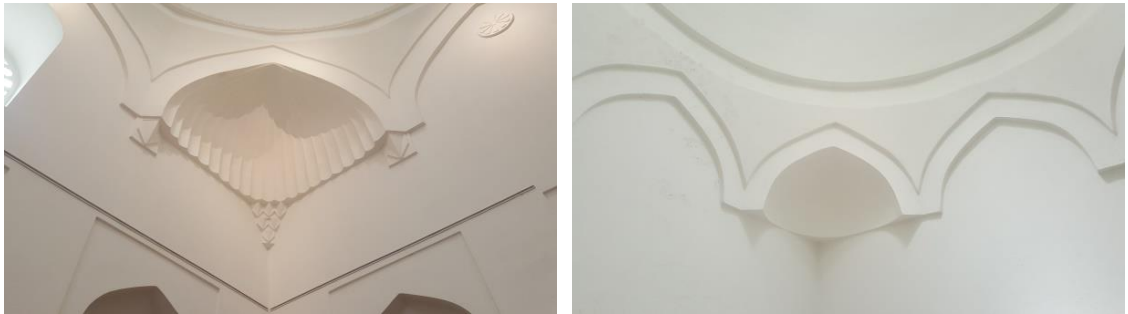
Şekil 3.8. I.Murat Hamamı soyunmalık mekânı dilimli ve halvet işlemez tromp uygulamaları
