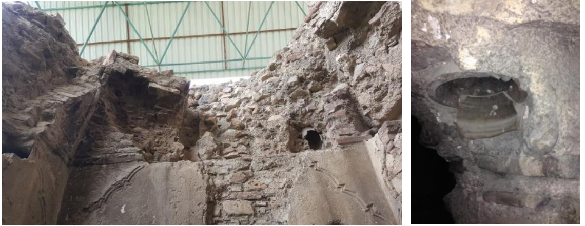
Şekil 4.134. İsmail Bey Hamamı ılıklik mekânı kuzey duvarı, Yeşil Cami Hamamı erkekler bölümü sıcaklık ana mekân güney duvarındaki tüteklik hasarları
