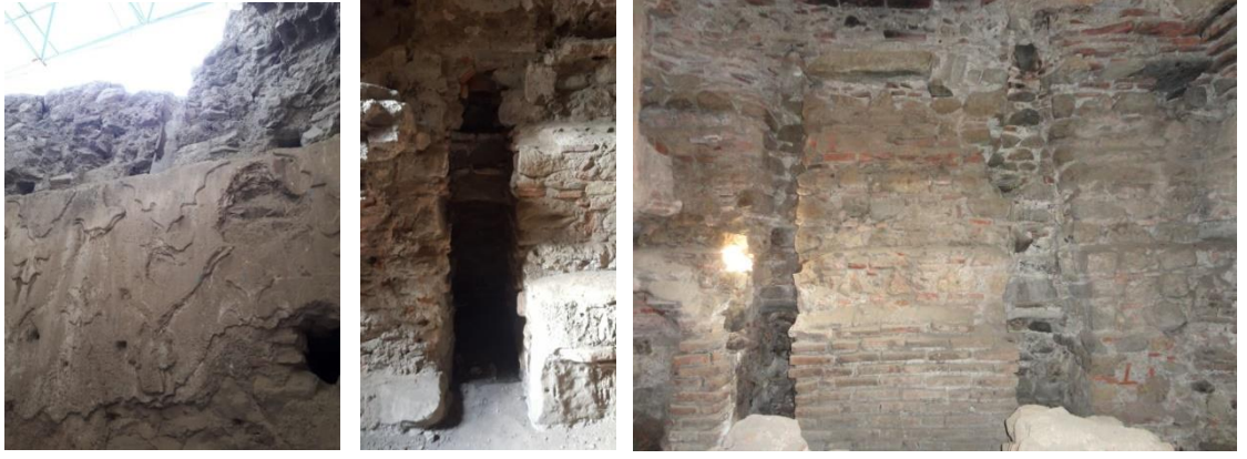
Şekil 3.49. İsmail Bey Hamamı ılıklik yan birim, sıcaklik ana mekân ve güneydoğu halvet tüteklilikleri
