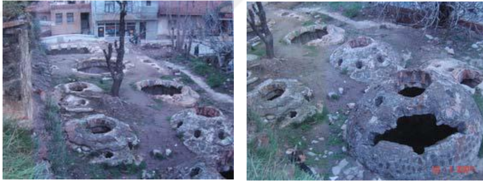
Şekil 4.87. I. Murat Hamamı esaslı onarım öncesi sıcaklık ana mekân ve halvet kubbe hasarları (BKVKBK 2006)
