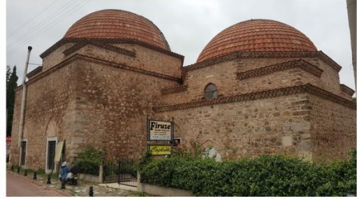
2--> Kuzey cephesinden görünüm
