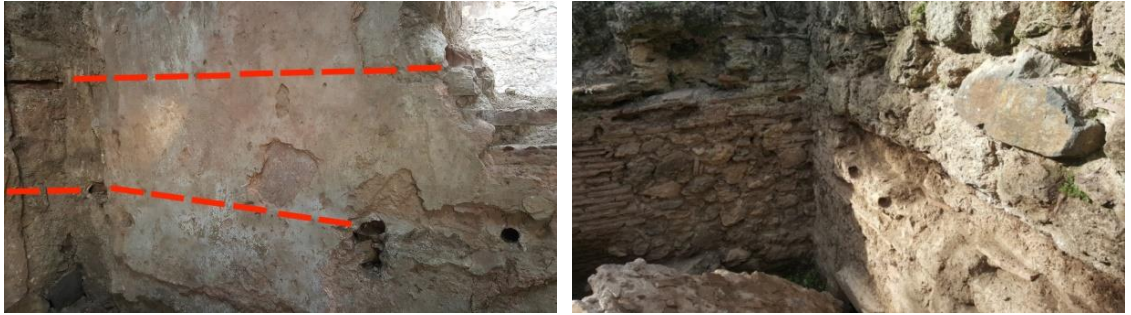
Şekil 4.63. Orhangazi Hamamı kuzeybatı halveti ve kuzeydoğu halveti iki sıra künk yerleşimi (kazı sonrası durumu)
