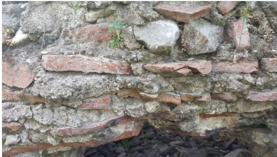
Şekil 4.112. Orhangazi Hamamı ve Küçük Hamam kubbelerini oluşturan tuğla malzemedeki şekil bozulmaları
