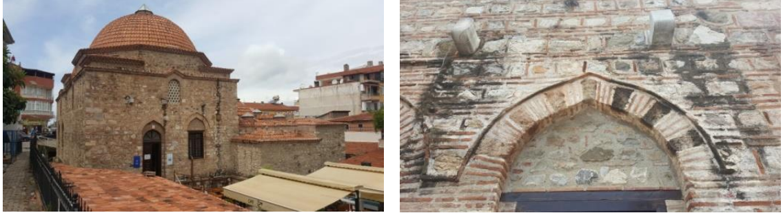
Şekil 4.115. I.Murat Hamamı kadınlar ve erkekler bölümleri soyunmalık mekânları dış duvarlardaki renk değişimleri
