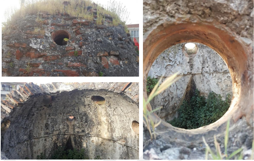
Şekil 4.51. Küçük Hamam kubbelerindeki ışık gözleri
