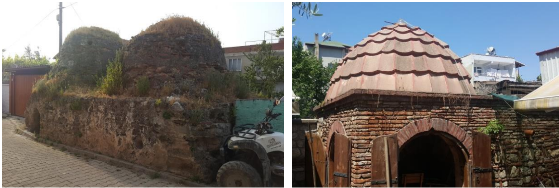
Şekil 4.42. Küçük Hamam kubbeleri, Konak Hamamı onarım geçirmiş kubbe
