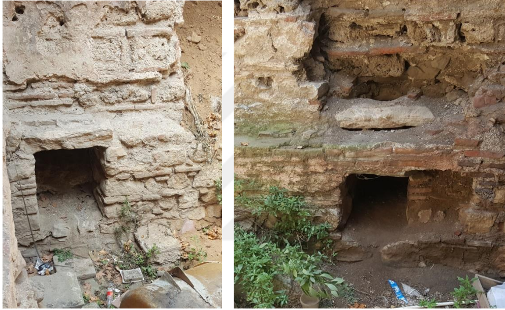
Şekil 4.69. Yeşil Cami Hamamı batı ve doğu duvarı cehennemlik kanalları
