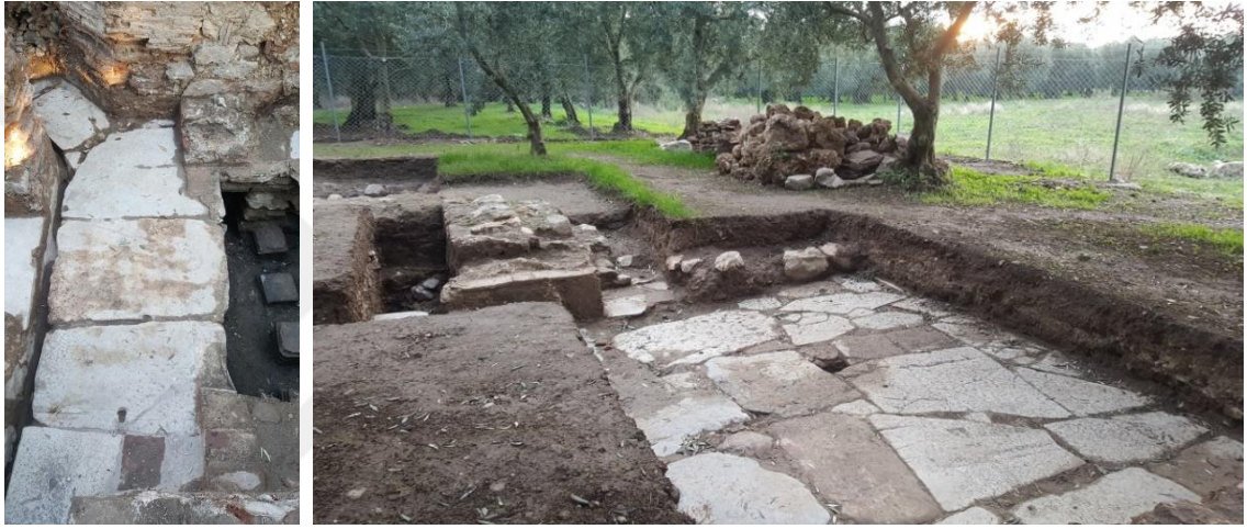
Şekil 3.56. Orhangazi Hamamı sıcaklık ve soyunmalık mekânları özgün döşemeleri
