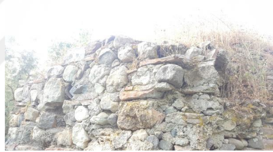
Şekil 4.111. Yeşil Cami Hamamı kadınlar bölümü soyunmalık mekânı duvar kalıntısı, Orhangazi Hamamı kuzeybatı halvet batısındaki duvar kalıntısına ait moloz taş ve tuğla malzemedeki şekil bozulmaları
