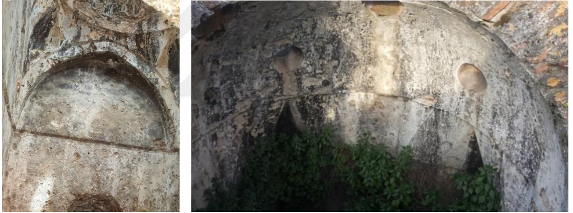
Şekil 3.84. Küçük Hamam ılıklık mekânındaki pandantif ve sıcaklık ana mekândaki üçgen kuşak uygulaması
