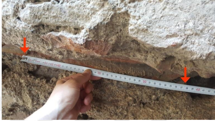
Şekil 3.73. Yeşil Cami Hamamı'nda kullanılan künk uzunluğu
