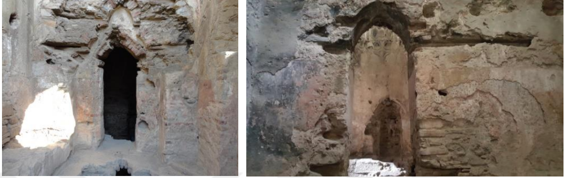
Şekil 4.5. İsmail Bey Hamamı ılıklik mekânı doğu duvarı ve güneydoğu halveti kuzey duvarı çift cidarlı hatıl boşlukları
