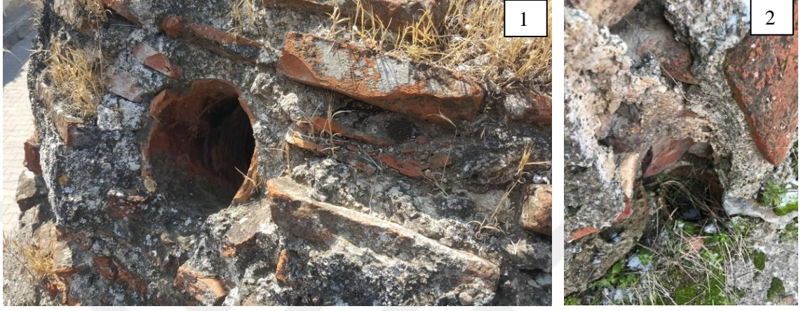
Şekil 3.85. Küçük Hamam pişmiş toprak malzemeden oluşturulmuş 1) ışık gözü, 2) tüteklik görselleri
