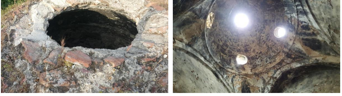
Şekil 4.55. Orhangazi Hamamı kuzeybatı halveti kubbe tepe ışıklığı (kazı öncesi durumu), Küçük Hamam ılıklik mekânı kubbe tepe ışıklığı
