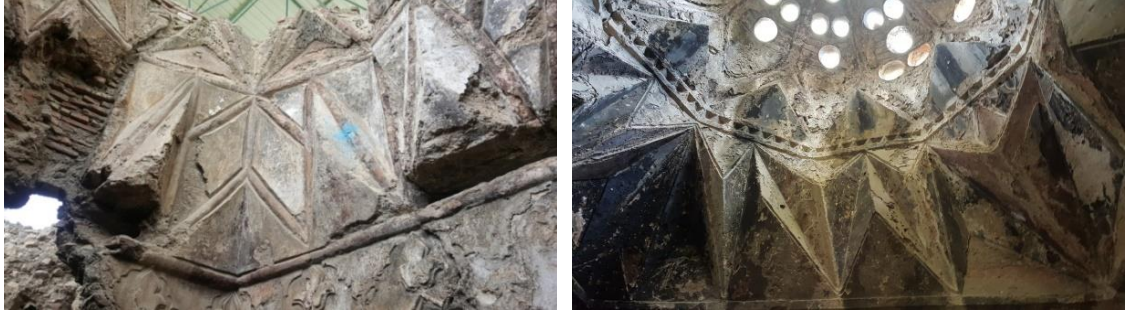
Şekil 4.37. İsmail Bey Hamamı ılıklik birimi ve güneydoğu halveti çift sıra üçgen kuşak kullanımı
