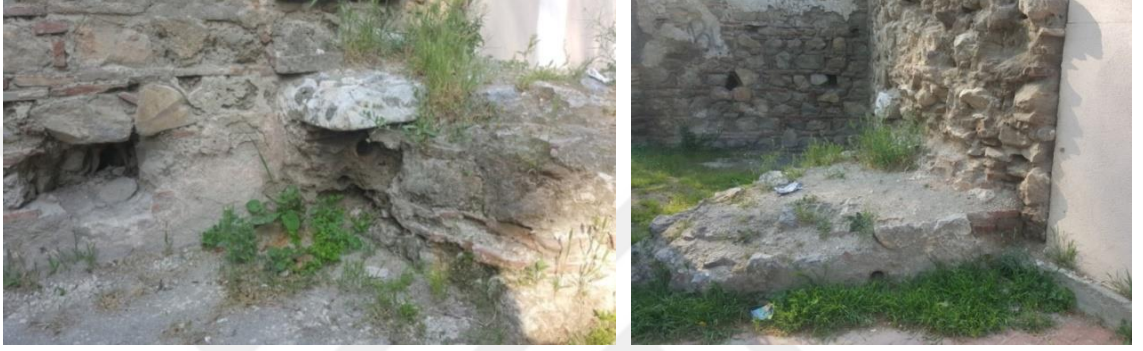
Şekil 3.69. Yeşil Cami Hamamı kadınlar bölümü halvet duvarı içten ve dıştan gözüken mevcut su künkleri
