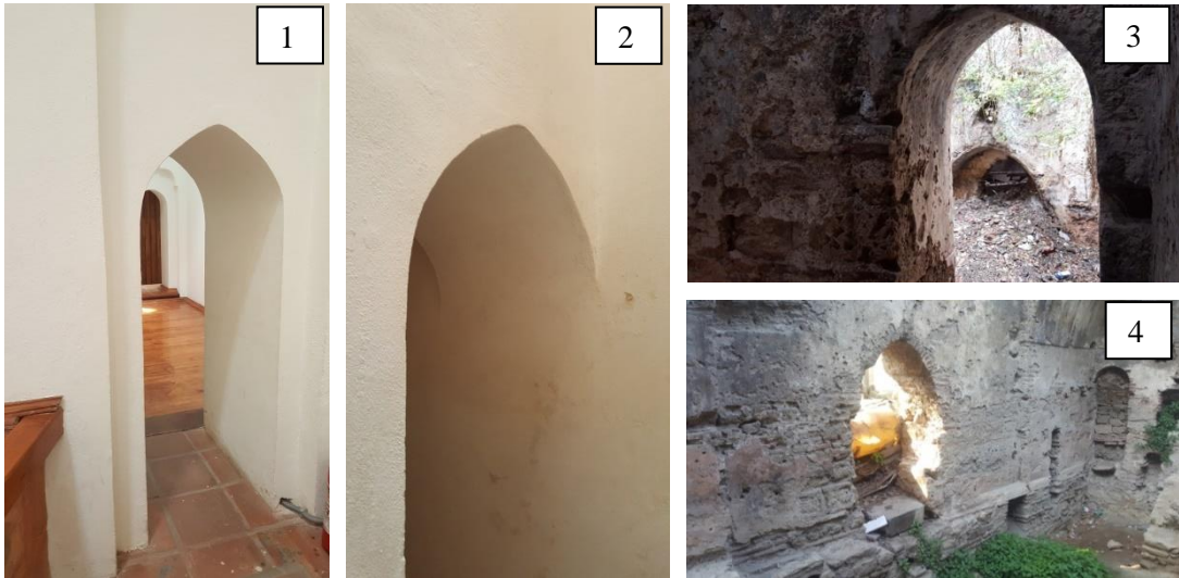
Şekil 4.25. 1) I.Murat Hamamı kadınlar bölümü ılık mekânı geçiş boşluğu, 2) II.Murat Hamamı sıcak mekânı geçiş boşluğu, 3) Küçük Hamam ılık mekânı geçiş boşluğu, 4) Yeşil Cami Hamamı erkekler bölümü sıcak ana mekândan soyunmalık mekânına geçiş boşluğu kademersiz sivri kemer kullanımları
