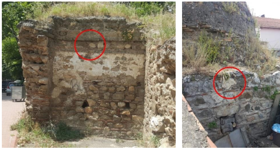
Şekil 4.21. Yeşil Cami Hamamı kadınlar bölümü batı duvarı ve Küçük Hamam doğu dış duvarı taş, tuğla, devşirme malzeme kullanımı
