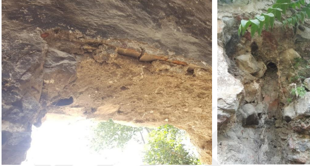
Şekil 3.78. Yeşil Cami Hamamı erkekler bölümü sıcaklık güney duvarı ve halvet batı duvarı tütelikleri
