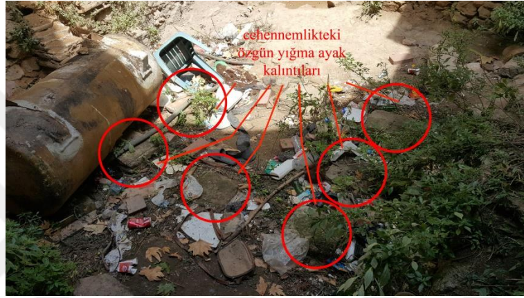
Şekil 3.75. Yeşil Cami Hamamı erkekler bölümü sıcaklık ana mekân cehennemlik kotundaki özgün yığma ayak kalıntıları
