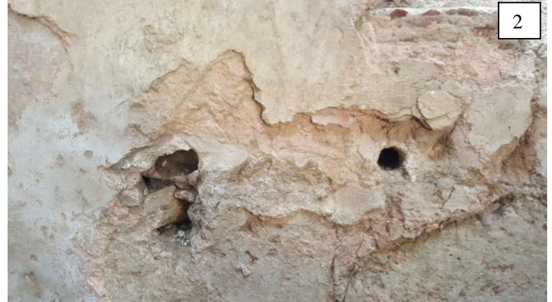
Şekil 3.60. Orhangazi Hamamı kuzeybatı halveti 1) kuzey duvarı, 2) doğu duvarındaki paralel iki sıra künk dizimi ve musluk izi
