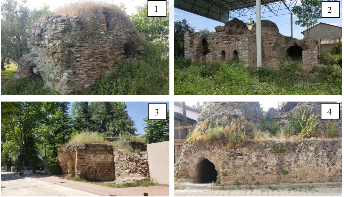
Şekil 4.121. 1) Orhangazi Hamamı (kazı öncesi durumu), 2) İsmail Bey Hamamı, 3) Yeşil Cami Hamamı, 4) Küçük Hamam bakımsızlık ve terk etkileri sonucu görülen biyolojik oluşumlar
