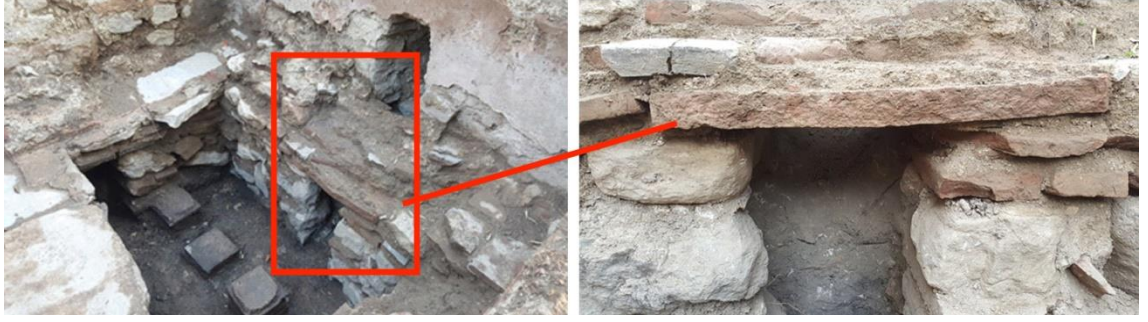
Şekil 4.68. Orhangazi Hamamı cehennemlik kanalı üzeri tuğla kullanımı
