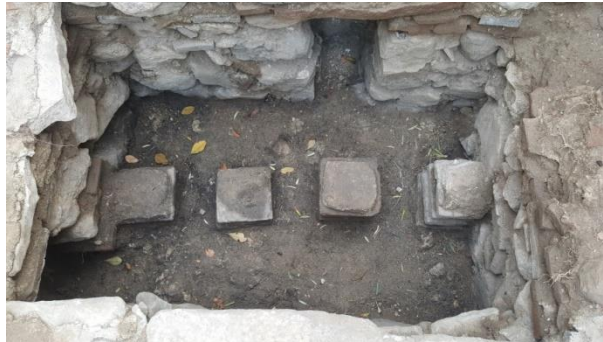
Şekil 4.74. Orhangazi Hamamı tuğla yığma ayaklar (kazı sonrası durumu)
