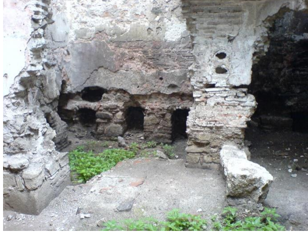
Şekil 3.14. II.Murat Hamamı esaslı onarım öncesi sıcaklık mekânlarındaki cehennemlik kanalları (BVBM 2005)
