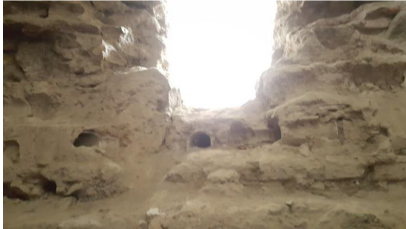
Şekil 3.40. İsmail Bey Hamamı güneydoğu halveti, su deposundan gelen ve kollara ayrılan künk dizimleri
