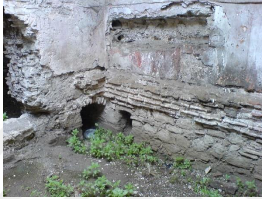
Şekil 4.58. I.Murat Hamamı esaslı onarım öncesi iki sıra künk dizimi (BVBM 2005)
