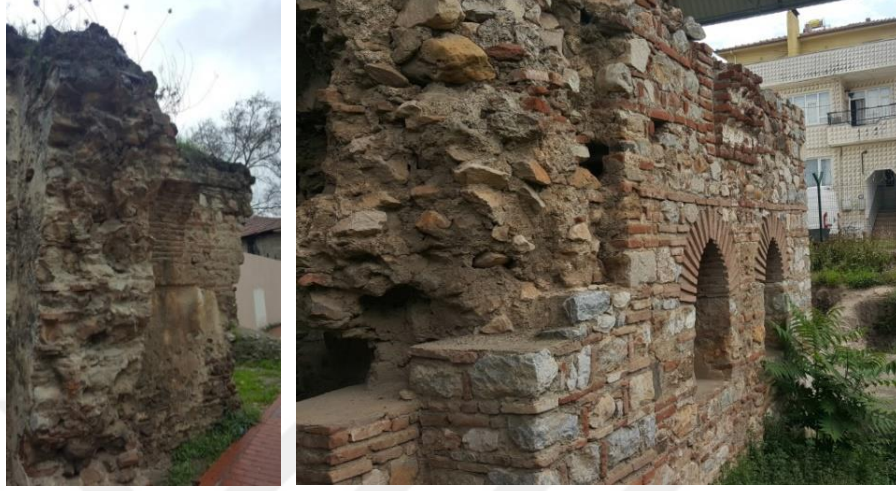
Şekil 4.3. Yeşil Cami Hamamı kadınlar bölümü soyunmalık mekânı duvar kalıntısı, İsmail Bey Hamamı ılıkılık mekânı batı duvarı, duvar içi dolgu uygulamaları
