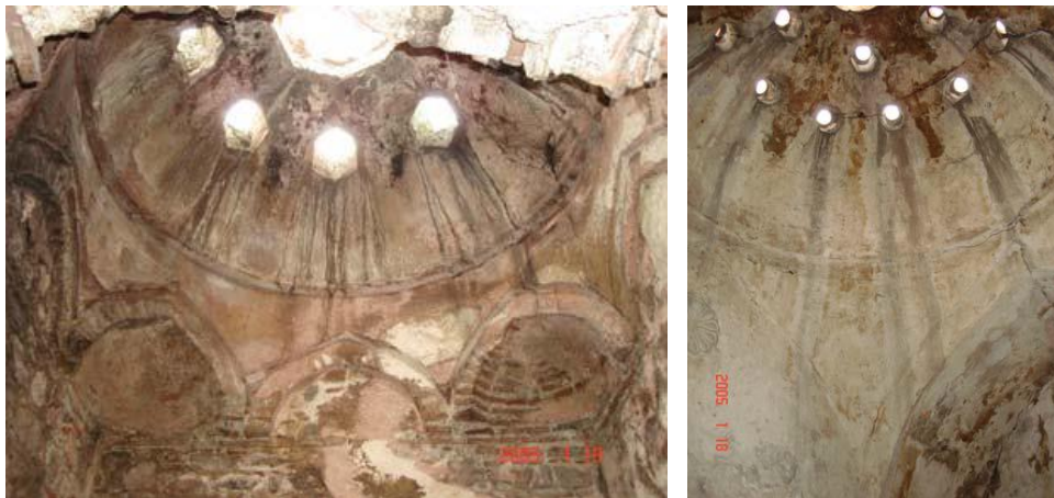
Şekil 4.117. I.Murat Hamamı kadınlar bölümü halvet ve II.Murat Hamamı kadınlar bölümü sıcaklık ana mekân kubbesinde ışık gözleri etrafındaki renk değişimi ve lekelenmeler (Kula Say 2007)
