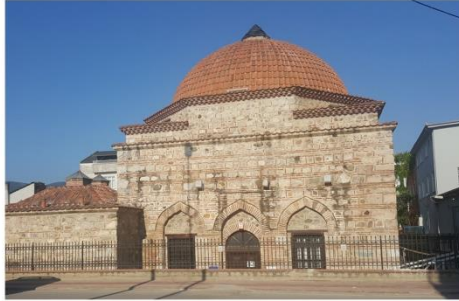
1--> Batı cephesinden görünüm
