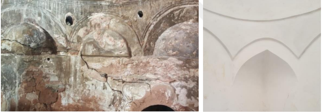
Şekil 4.32. Konak Hamamı sıcaklık mekânı ve II.Murat Hamamı kadınlar bölümü halvetlerinde işlemsiz tromp kullanımı
