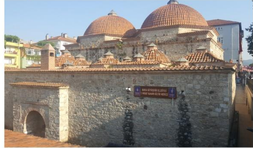
2--> Kuzey cephesinden görünüm
