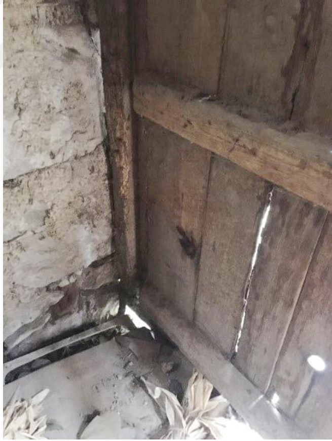
Şekil 4.18. Binili kasa, binisiz kanat bağlantılı kapı örneği.
