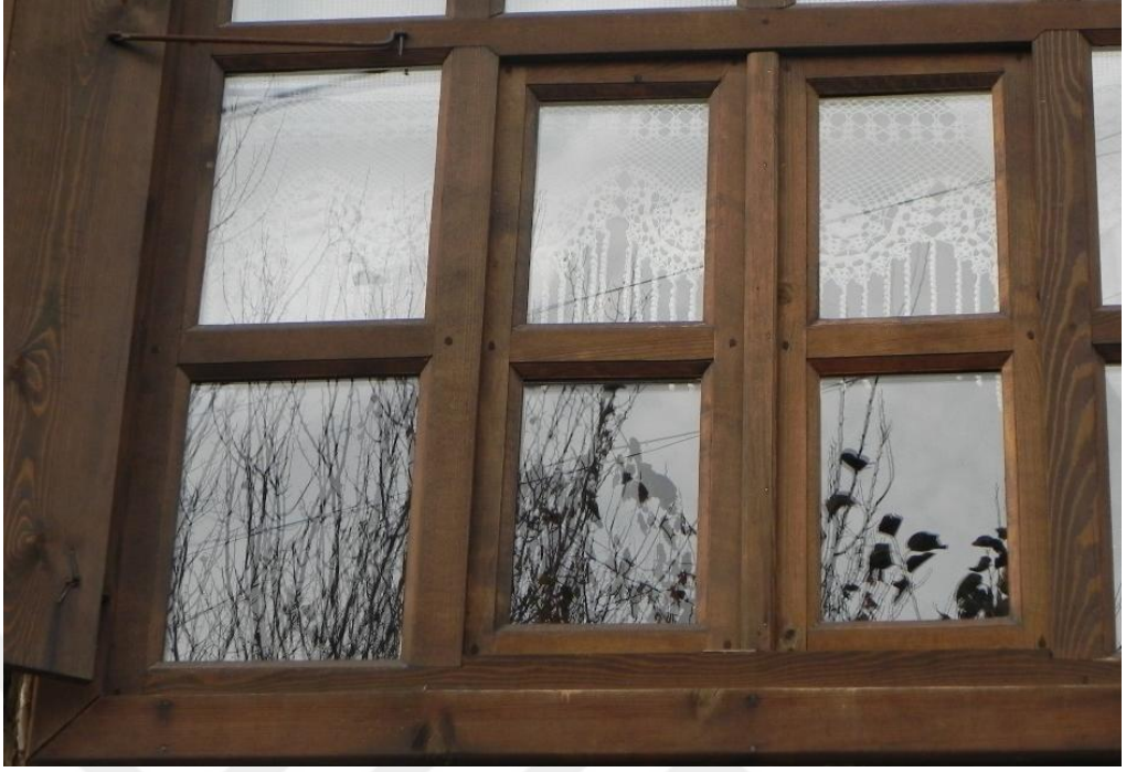
Şekil 4.84. Kasa – kanat ilişkisi lambalı olan pencere örneği.
