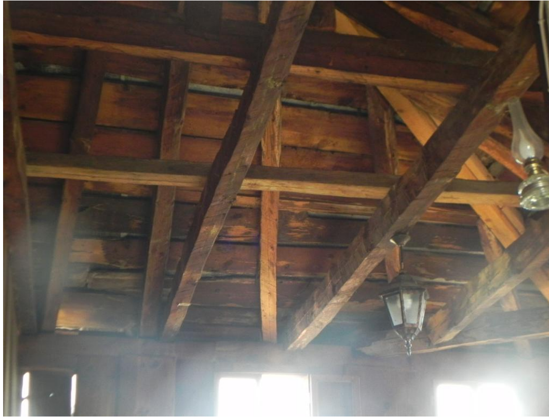
Şekil 3.19. Çatı konstrüksiyonu – Sipahioğlu Konağı.
