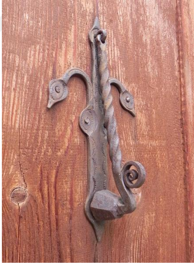
Şekil 4.50. Düz ayrı bir tutma yeri olan tokmak türüne sahip kapı örneği.
