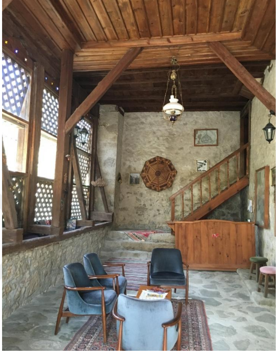
Şekil 3.6. Zemin katta bir tarafı ahşap kafesle örtülü taşlık mekânı – Muratoğlu Konağı.
