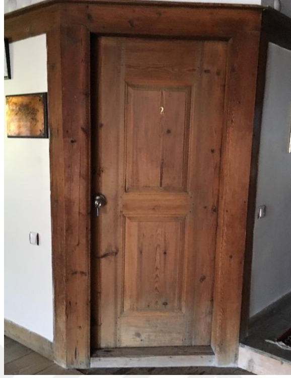
Şekil 4.38. Kapı kanadı, düşeyde bir, yatayda iki olacak şekilde bölümlenmiş kapı örneği.
