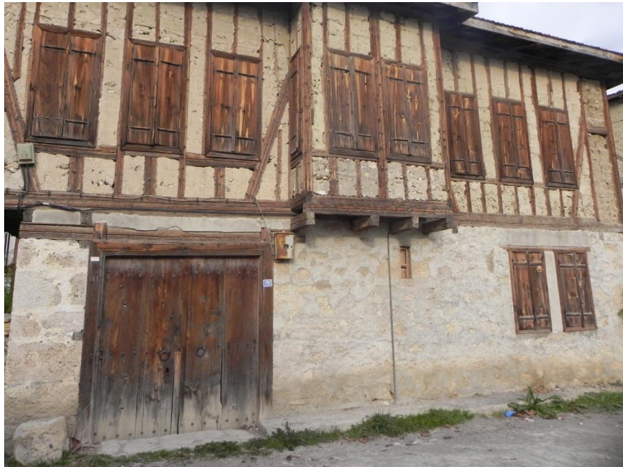
Şekil 3.25. Cephe merkezinde tek katta çıkması bulunan konut.
