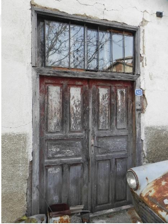
Şekil 4.6. Kireç sıvalı duvar üzerinde konumlanan kapı örneği.
