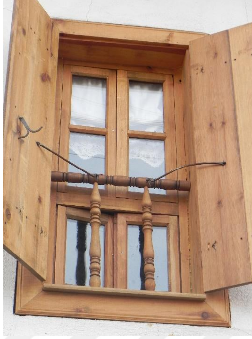
Şekil 4.82. Duvar iç kısmında bulunan pencere örneği.
