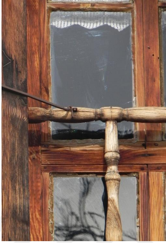
Şekil 4.92. Cam tespitinin macunla yapıldığı pencere örneği.
