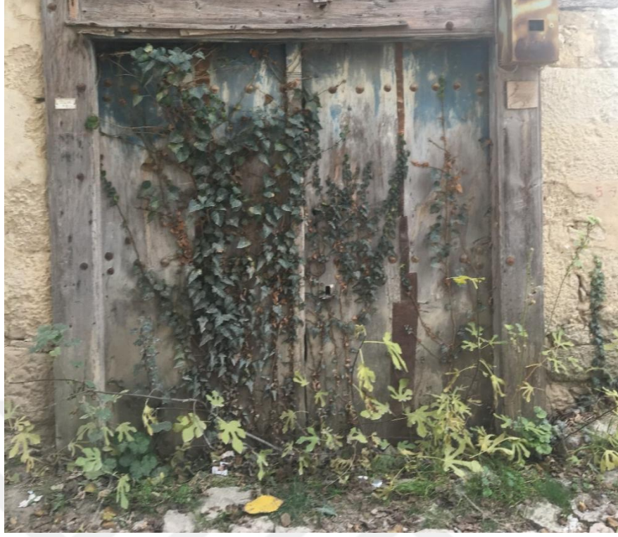
Şekil 4.69. Bitki oluşumu görülen kapı örneği.
