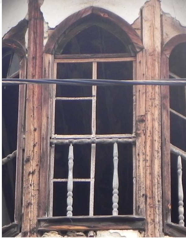
Şekil 4.132. Biçimsel deformasyona maruz kalan pencere örneği.
