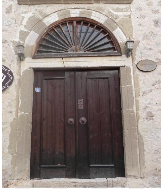
Şekil 4.57. Ahşap pervaz elemanı bulunmayan kapı örneği.
