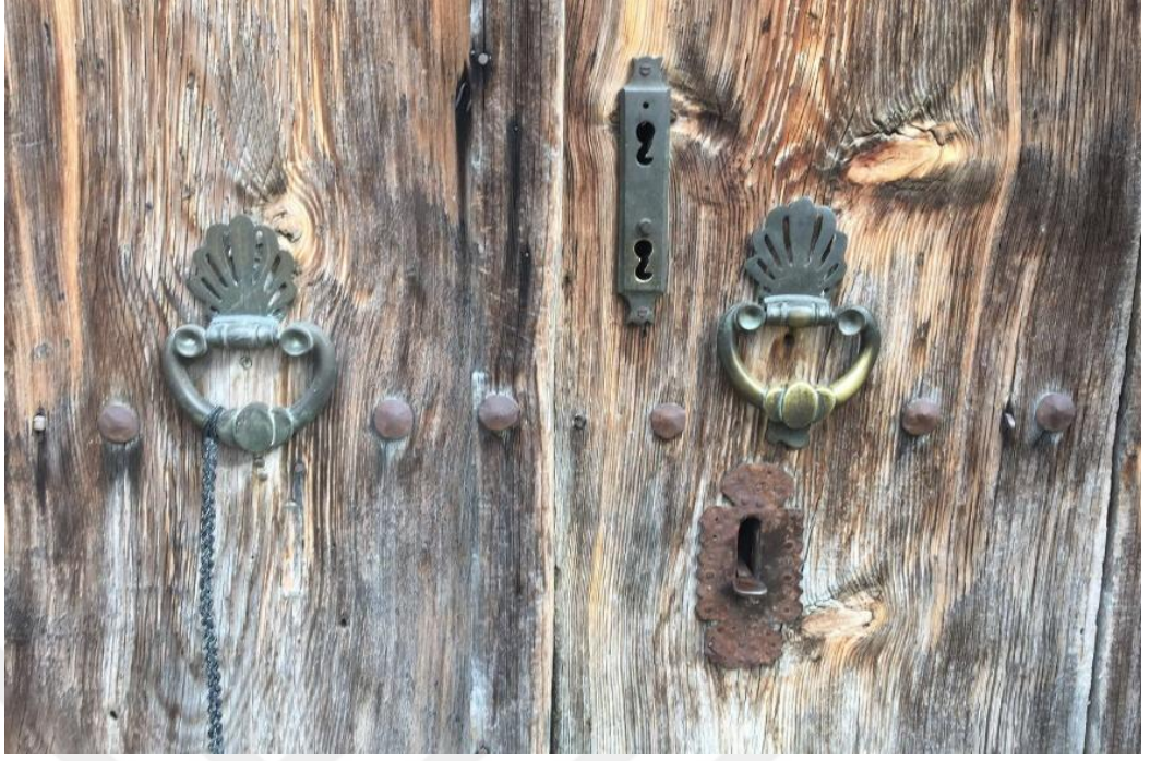
Şekil 4.49. Göbeği valutlu tokmak türüne sahip kapı örneği.
