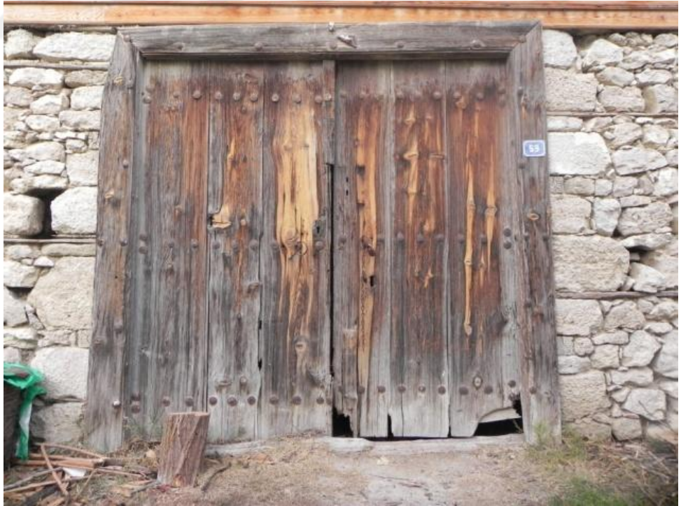
Şekil 4.2. Taş yığma duvar üzerinde konumlanan kapı örneği.
