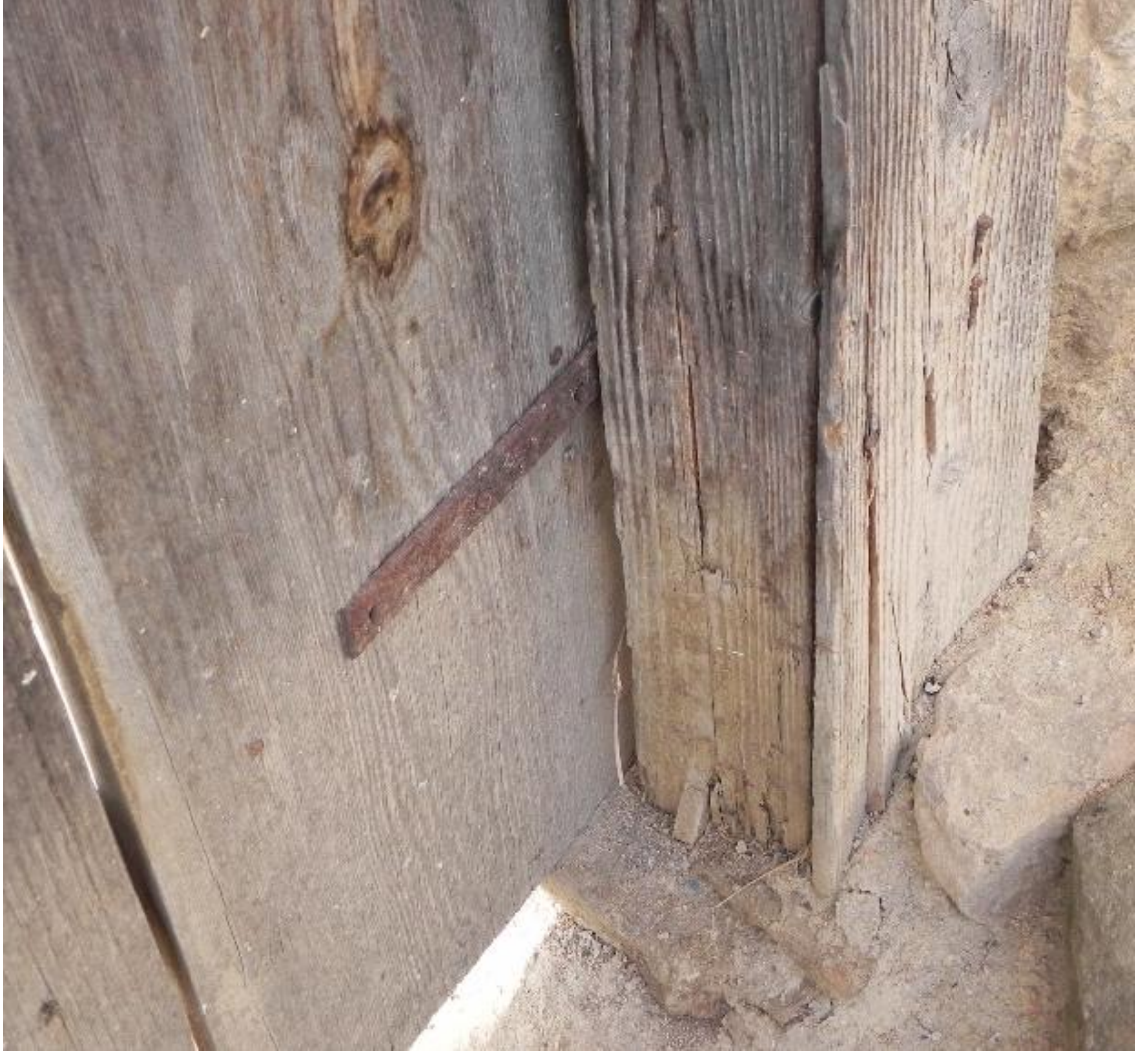
Şekil 4.19. Binisiz kasa, binisiz kanat bağlantılı kapı örneği.
