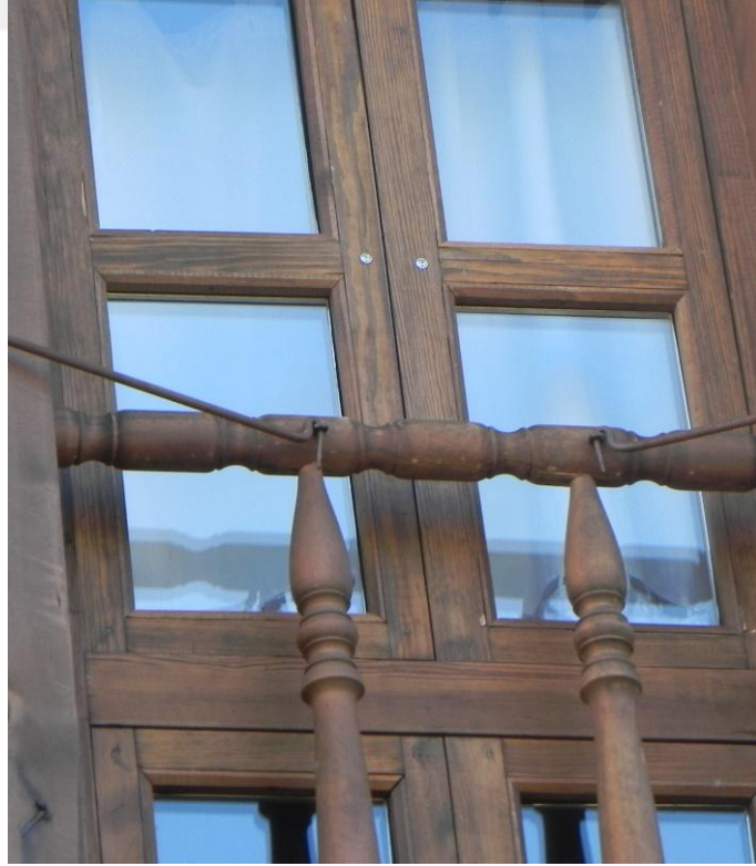
Şekil 4.93. Cam tespitinin çitalarla yapıldığı pencere örneği.
