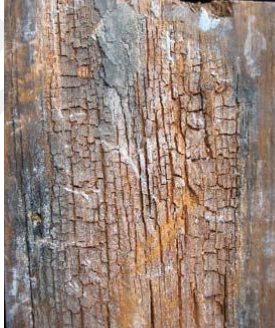
Şekil 3.91. Mantar oluşumundan kaynaklı çürüme (Yaman 2007).
