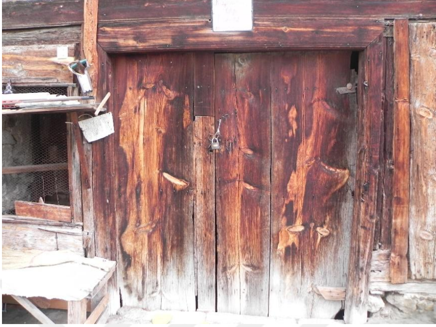
Şekil 4.63. Nem sorunu olan kapı örneği.
