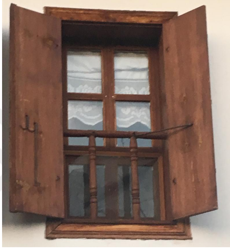
Şekil 4.127. Ahşap pervaz elemanına sahip pencere örneği.
