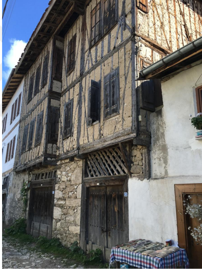
Şekil 3.5. Yörük Köyü'ndeki zemin katı kagir üstü ahşap çatklı konut örneği.
