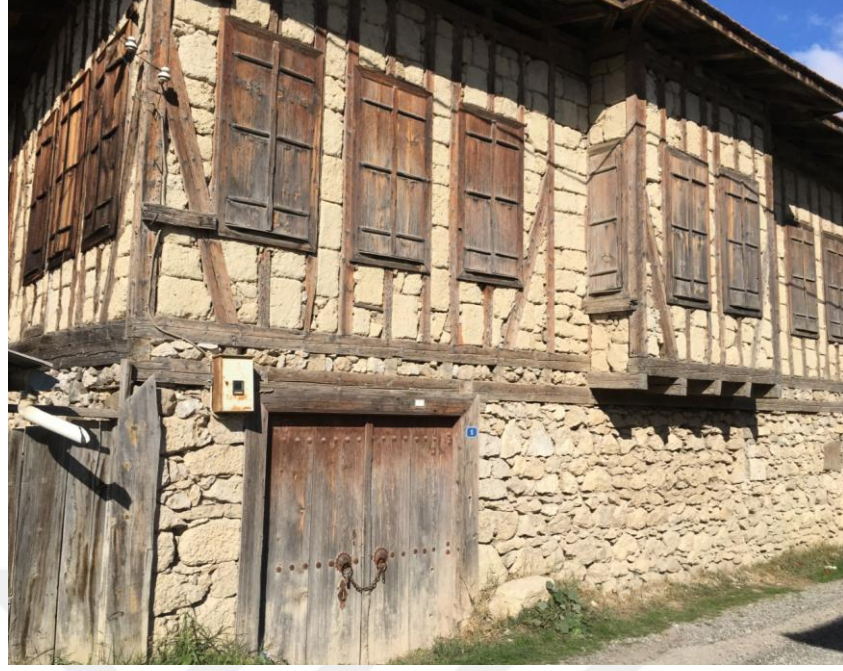
Şekil 3.17. Ahşap çatkı arası kerpiç dolgulu ve konsol çıkmalı yapı örneği.
