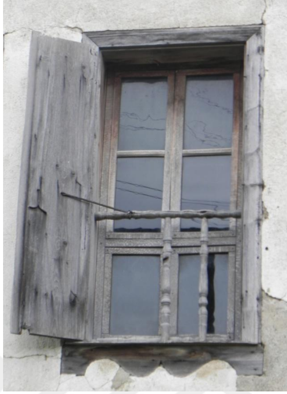
Şekil 4.97. Pencere boşluğu kenar oranı 1x2 olan pencere örneği.
