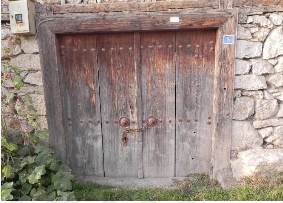
Şekil 4.5. Sıvasız duvar üzerinde konumlanan kapı örneği.
