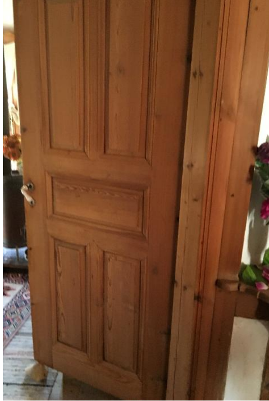
Şekil 4.9. Blok kasa türüne sahip kapı örneği.
