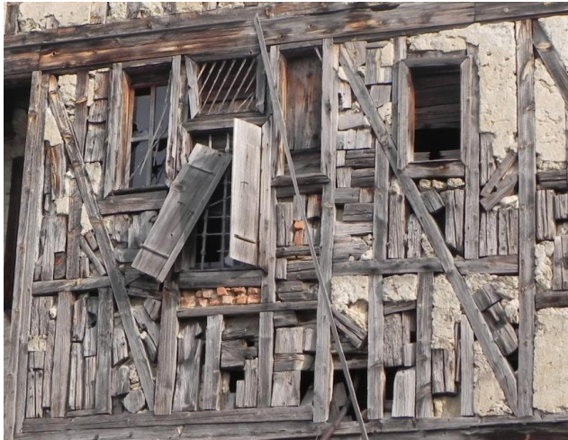
Şekil 3.93. Bağlantı sorunu örneęi.
