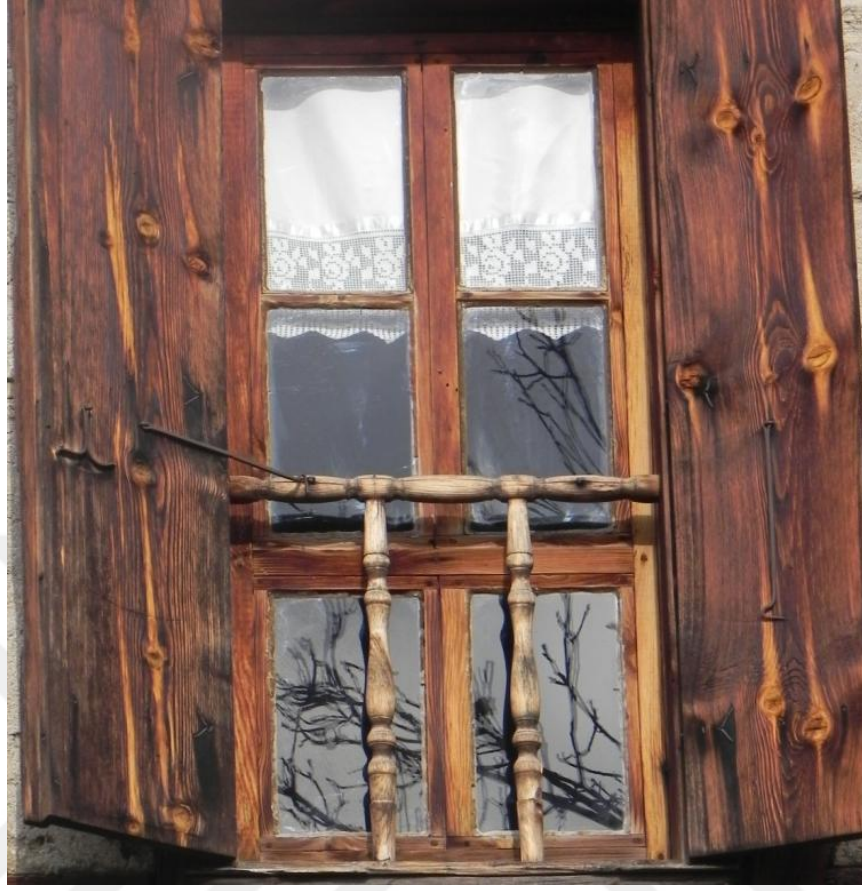
Şekil 4.120. Yan dönel açılan pencere örneği.
