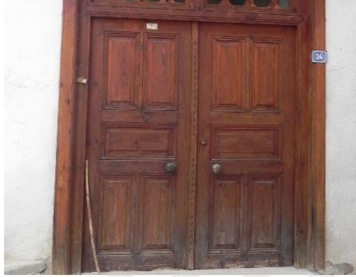
Şekil 4.12. Tablalı kapı kanat türüne sahip kapı örneği.
