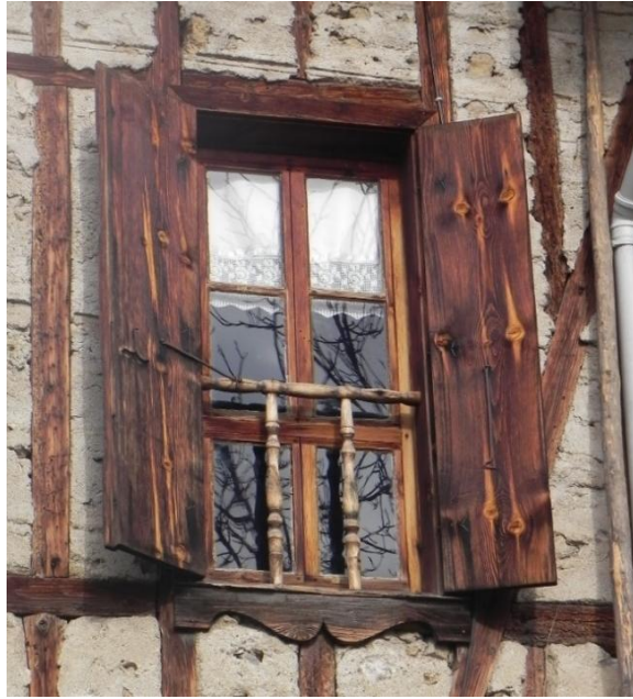
Şekil 4.77. Sıvasız duvarda bulunan pencere örneği.
