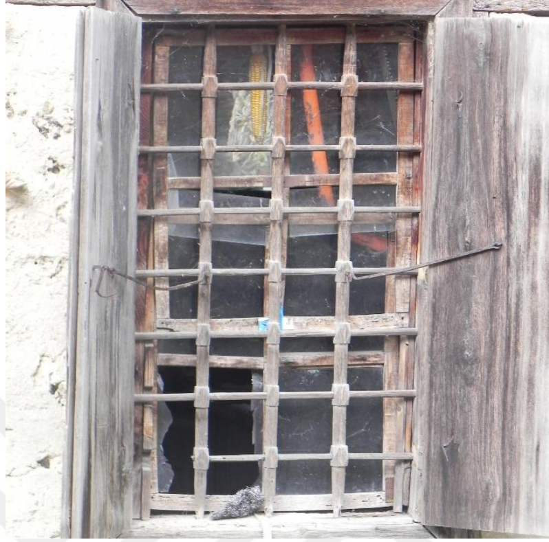
Şekil 4.88. Kanat-kanat ilişkisi kurtağızlı olan pencere örneği.
