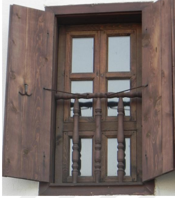
Şekil 4.86. Kasa – kanat ilişkisi düz olan pencere örneği.
