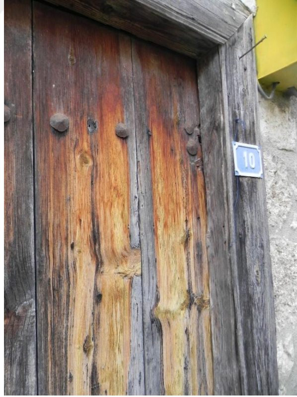
Şekil 4.70. Renk değişimi görülen kapı örneği.
