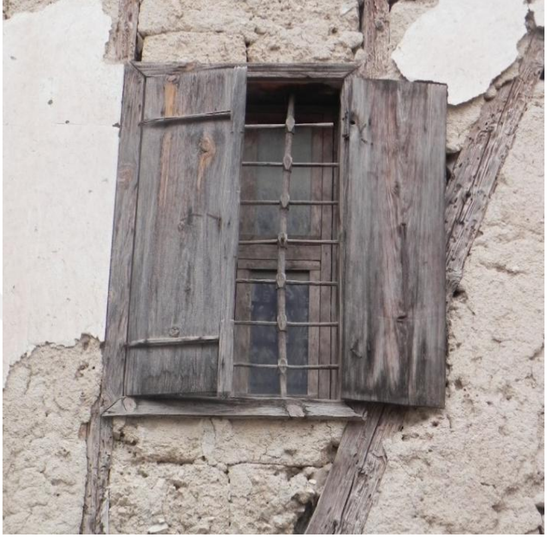
Şekil 4.79. Derin kasa türüne sahip pencere örneği.
