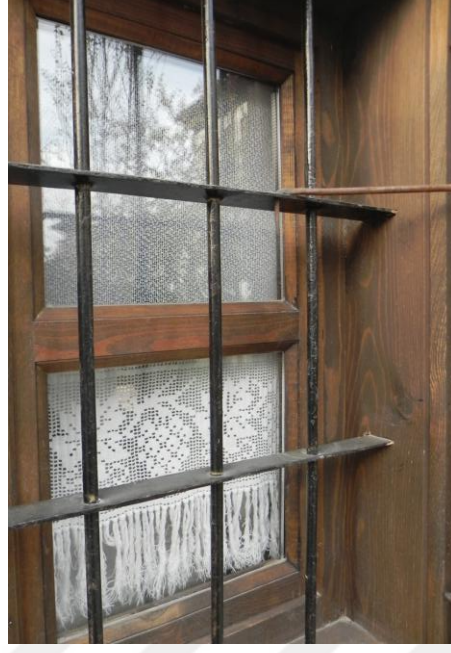
Şekil 4.125. Metal korkuluk bulunan pencere örneği.
