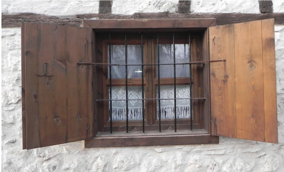
Şekil 4.96. Pencere boşluğu kenar oranı 1x1 olan pencere örneği.
