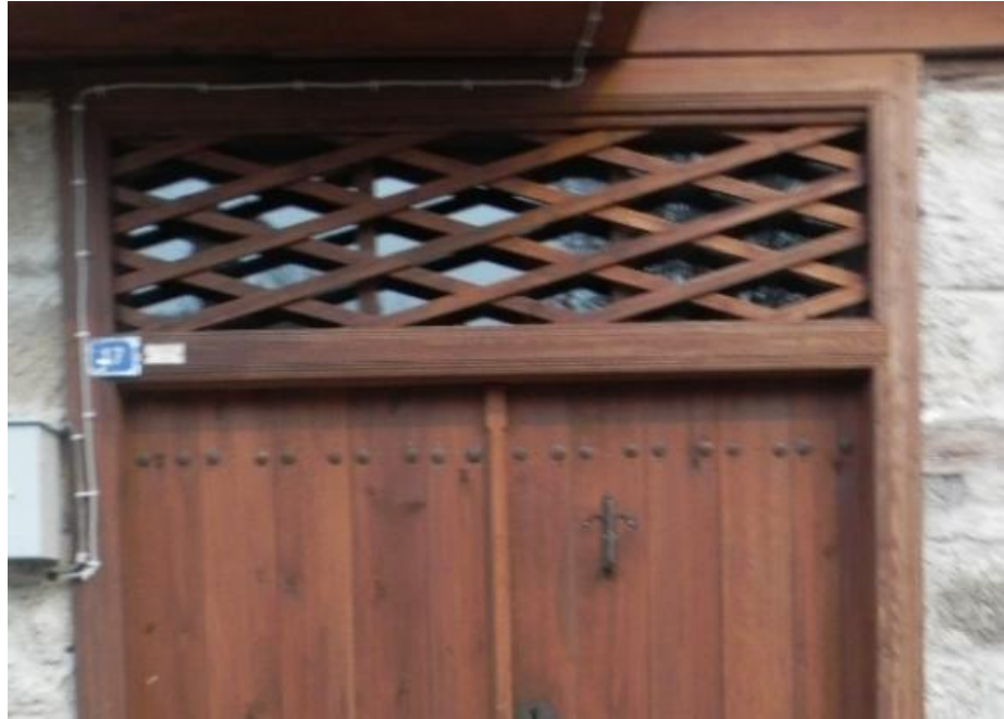
Şekil 4.23. Cam tespitinin ahşap çıtalar yardımı ile yapıldığı kapı örneği.
