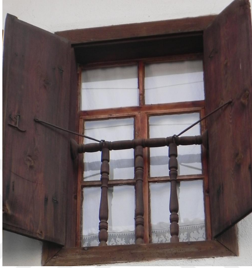
Şekil 4.106. Sabit kanat bölümleri yatayda iki, düşeyde bir olan pencere örneği.
