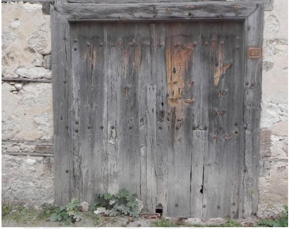
Şekil 4.8. Derin kasa türüne sahip kapı örneği.
