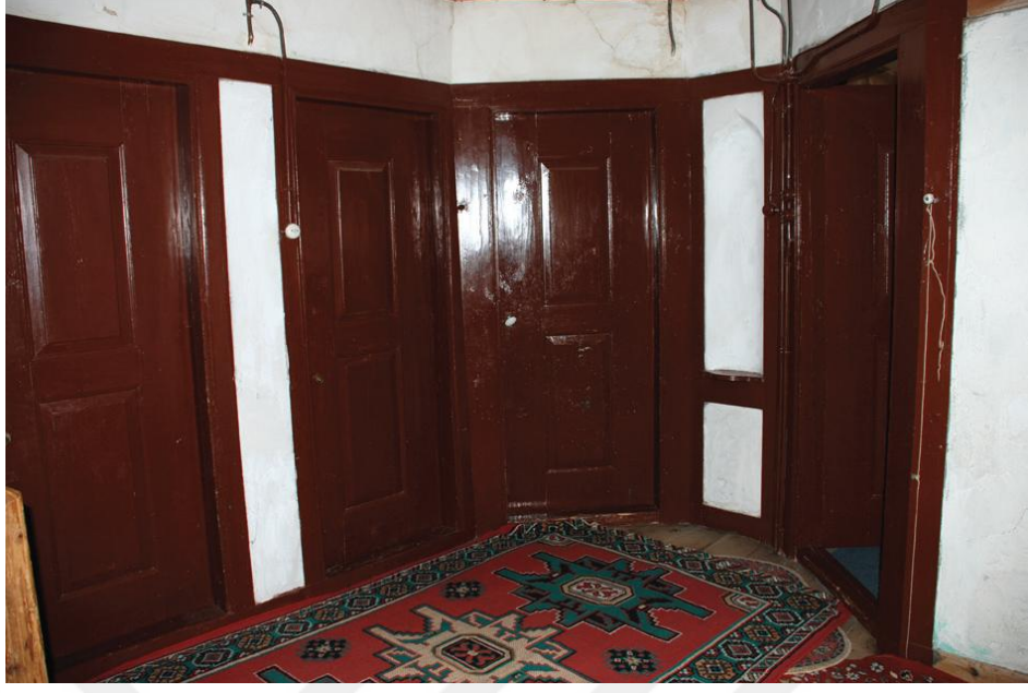
Şekil 3.8. Pahlı sofalı plan tipine sahip yapılarda oda kapılarının yerleşimi- Sucu Hafız Konağı (Demirarslan 2011).
