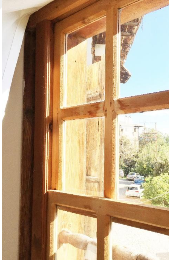
Şekil 4.85. Kasa-kanat ilişkisi kınışlı olan pencere örneği.
