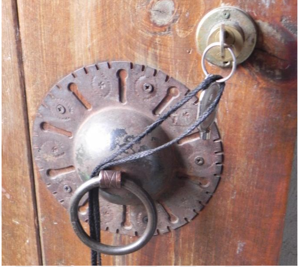
Şekil 4.45. Kapazlama kilit mekanizmasına sahip kapı örneği.
