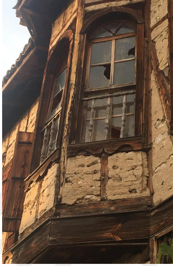
Şekil 4.74. Ahşap iskeletli kerpiç dolgulu duvar üzerinde bulunan pencere örneği.
