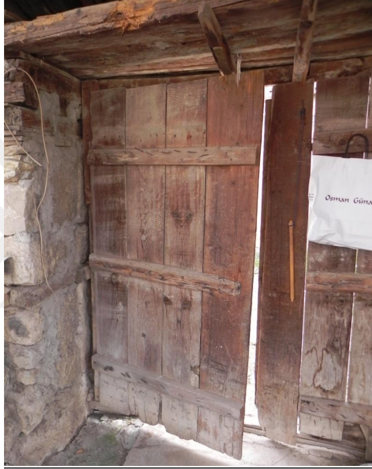
Şekil 3.34. Kapı kanadı oluşumu.
