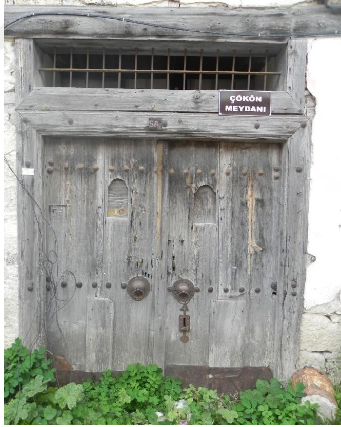
Şekil 4.37. Kapı kanadı, düşey elemanların yan yana gelmesiyle oluşan kapı örneği.
