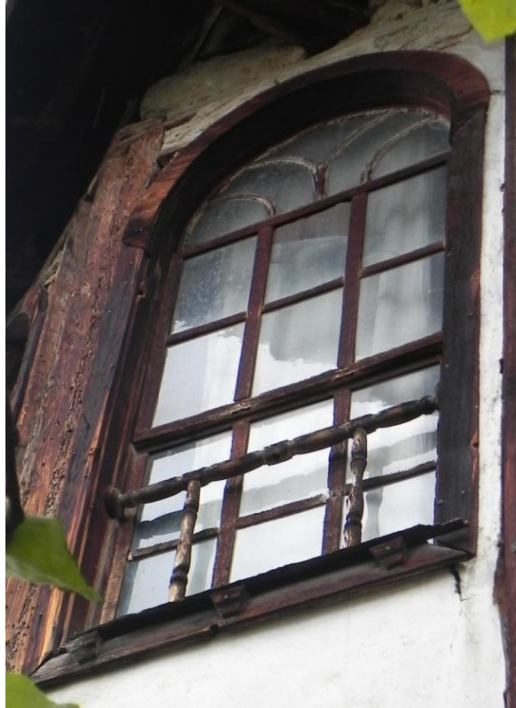
Şekil 4.102. Sabit kanat bölümleri yatayda iki, düşeyde üç olan pencere örneği.
