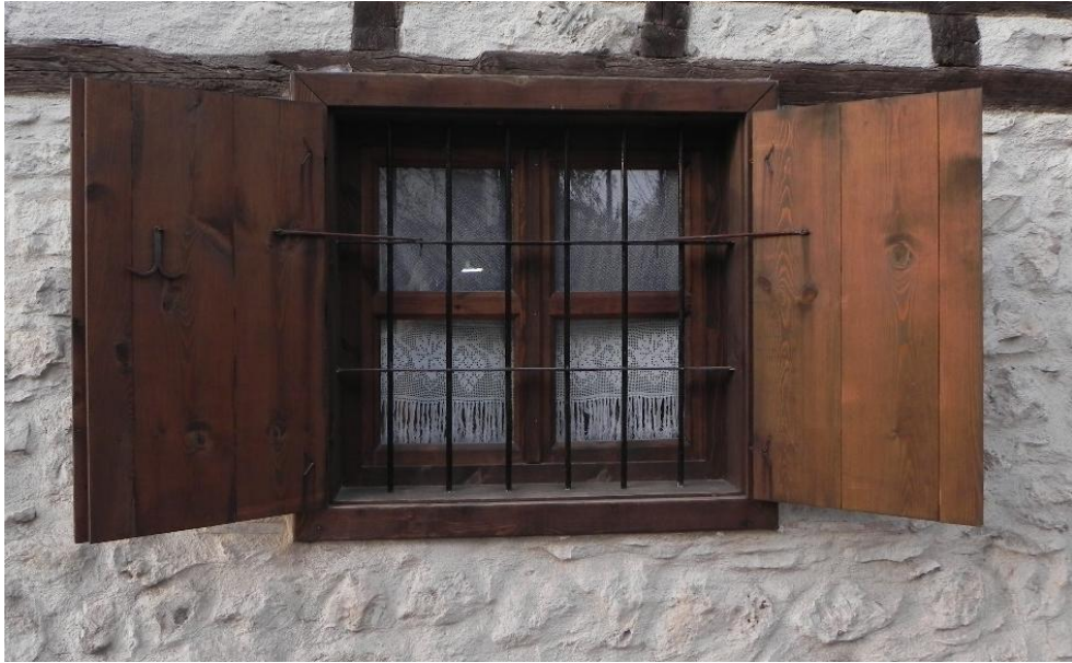
Şekil 4.73. Yığma taş duvar üzerinde bulunan pencere örneği.
