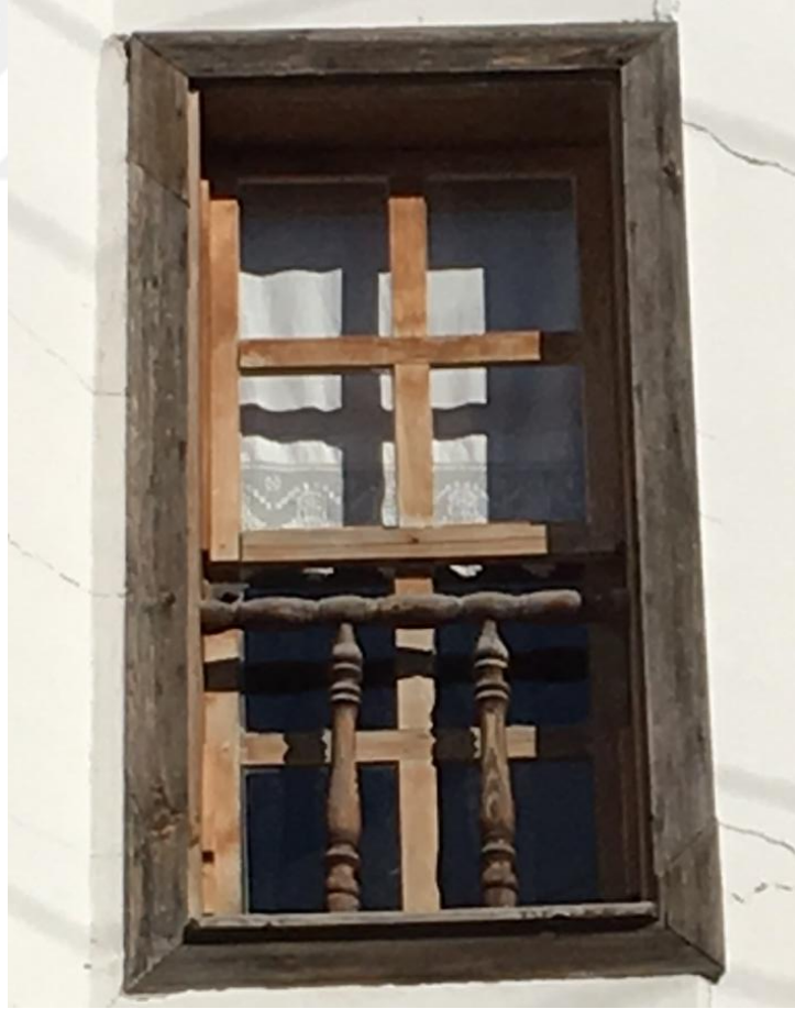
Şekil 4.105. Sabit kanat bölümleri yatayda ve düşeyde iki olan pencere örneği.
