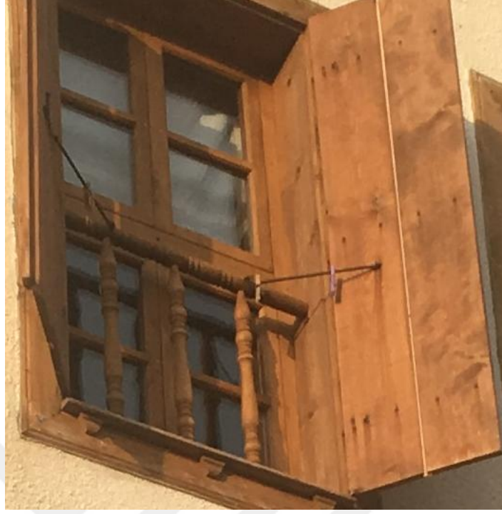
Şekil 4.110. Hareketli kanat bölümleri altta ve üstte; yatayda bir, düşeyde iki olan pencere örneği.
