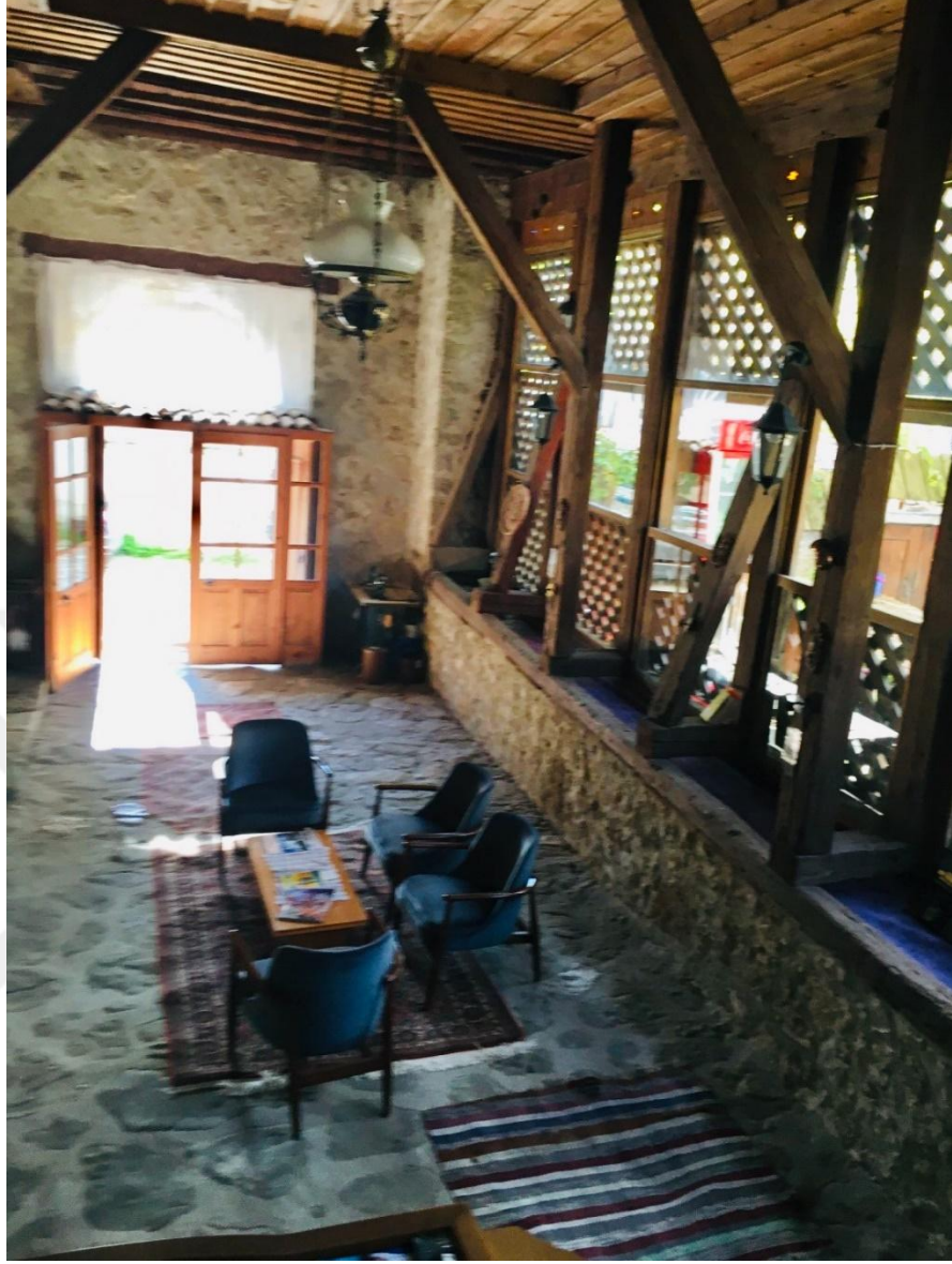
Şekil 3.40. İçeriden dışarıyı gizleyen ahşap kafes ile oluşturulan yarı geçirgen duvarı bulunan yapı – Muratoğlu Konağı.
