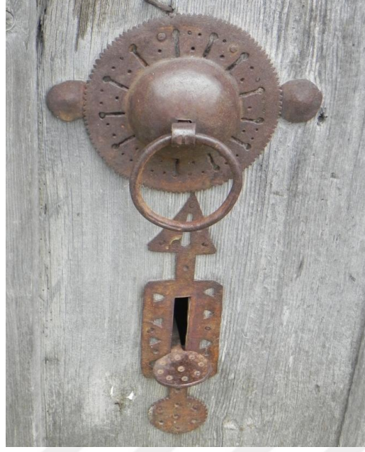
Şekil 3.54. Kapılarda yer alan mandal mekanizması.
