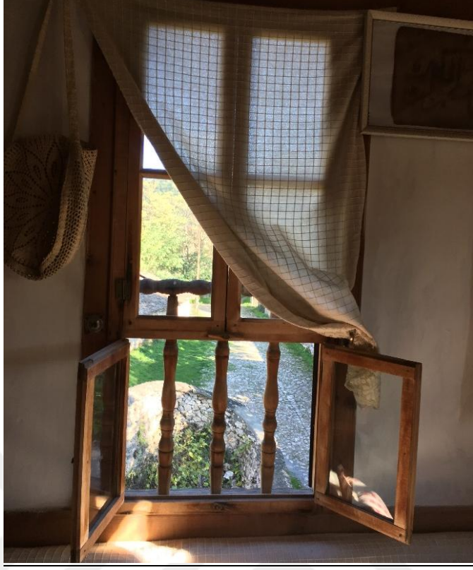
Şekil 3.37. Ahşap korkuluk bulunan pencere- Sucu hafız evi.
