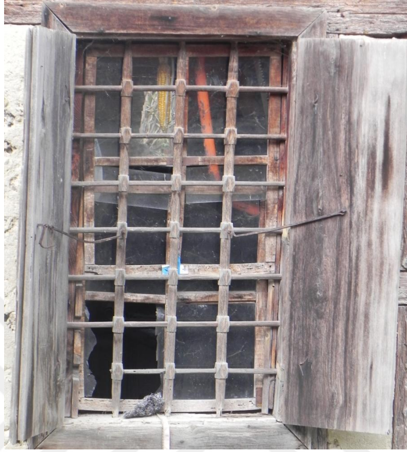
Şekil 4.129. Nem sorunu, aşınma ve renk deęişimi olan pencere örneęi.
