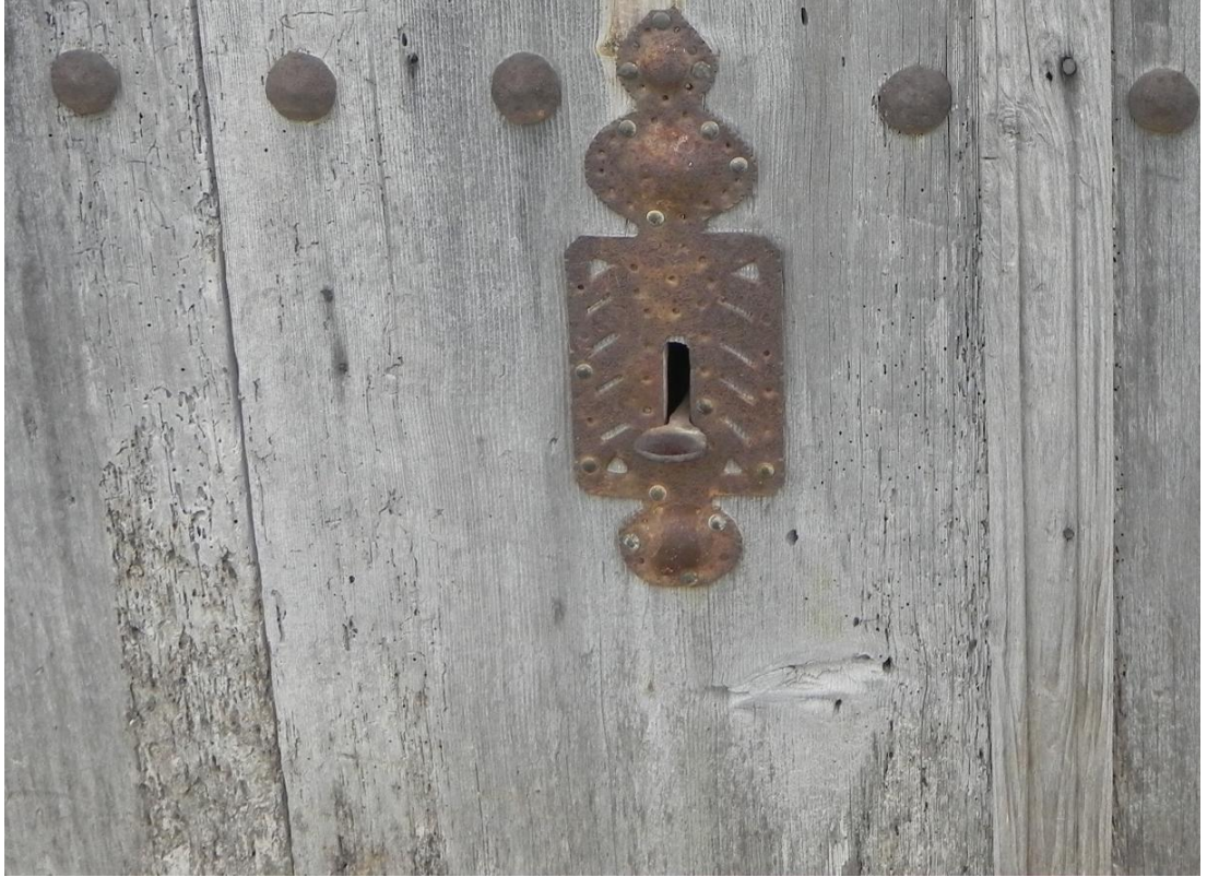
Şekil 4.68. Uçma delikleri bulunan kapı örneği.
