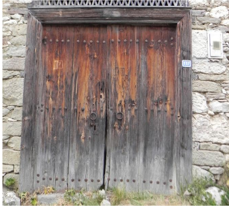
Şekil 4.11. Lata kapı kanat türüne sahip kapı örneği.
