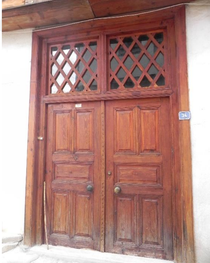
Şekil 4.34. Kapı boşluğu kenar oranı 9x15 olan kapı örneği.
