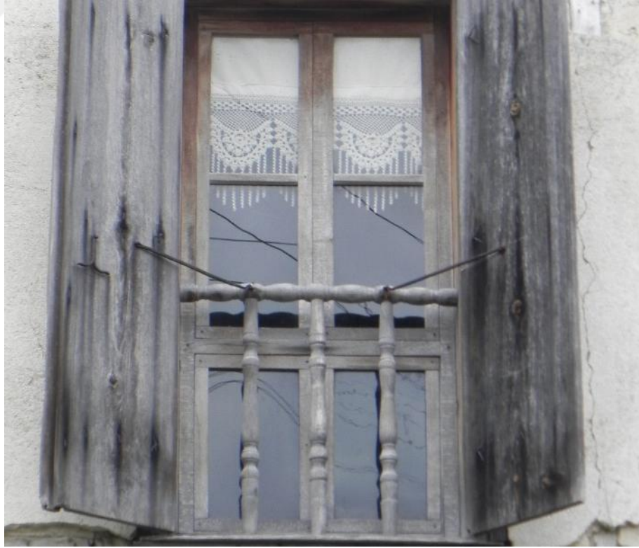
Şekil 4.89. Kanat-kanat ilişkisi lambalı olan pencere örneği.
