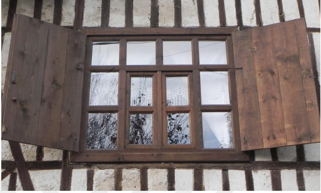
Şekil 4.104. Sabit kanat bölümleri üstte; simetrik dört, iki yanda iki olan pencere örneği.
