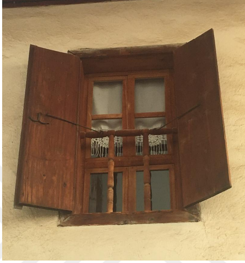
Şekil 4.78. Kireç sıvalı duvarda bulunan pencere örneği.
