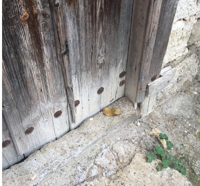
Şekil 4.25. Eşik malzemesi olarak taş malzeme kullanılan kapı örneği.
