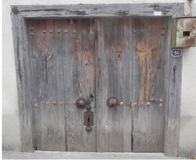
Şekil 4.41. Çift kanatlı kapı örneği.
