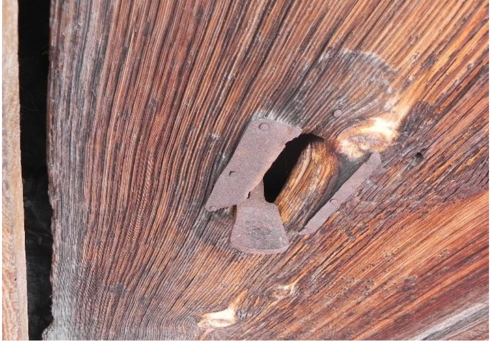
Şekil 4.46. Mandallı kilit mekanizmasına sahip kapı örneği.
