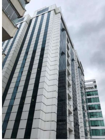
Şekil 4.53 Mihraplı Plaza -Cephe Detayı
