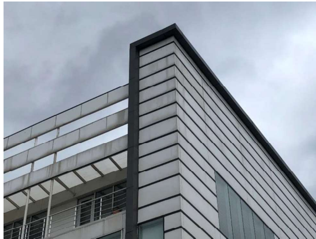
Şekil 4.65 Tezeller İş Merkezi - Yüzey Kirlenmesi
