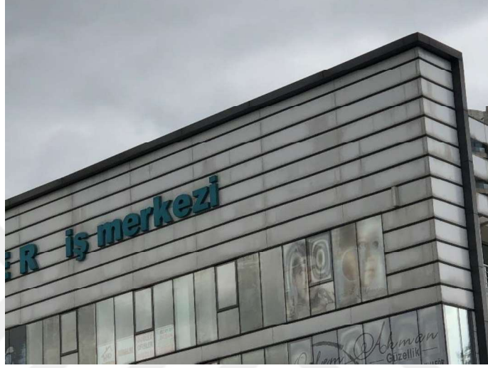
Şekil 4.64 Tezeller İş Merkezi - Yüzey Kirlenmesi
