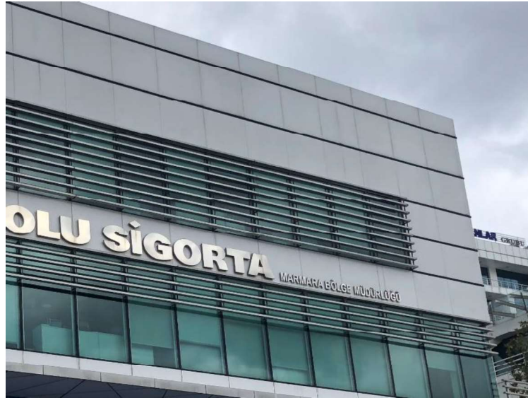
Şekil 4.50 Zeno Center - Yüzey Kirlenmesi
