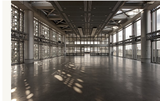
Şekil 4.61. Arab World Institute, çelik strüktür ve cephe elemanları ( https://www.imarabe.org/en/architecture , 2019)
