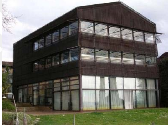
Şekil 4.115. Archipel Theater, yapıya giydirilen çelik ızgara ve açılabilir paneller (Anonim 1996)
