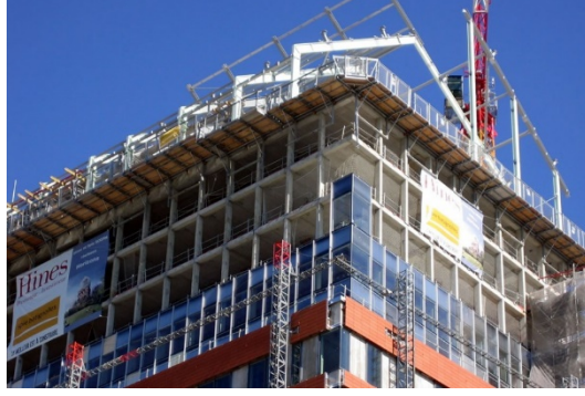
Şekil 4.74. C1 Horizons, çatı katındaki cam kütleinin şantiye aşaması ( http://www.arcora.com/projets/tour-c1-horizons/ , 2019)
