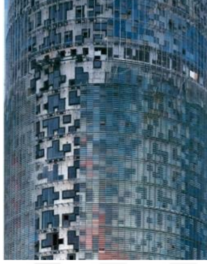
Şekil 4.56. Agbar Tower, binanın yapım aşamasında görülen malzeme katmanlaşması ( http://www.old.awn.it/AWN/Engine/RAServeFile.php/f/Area_nouvel-barcellona2-ind.pdf , 2017)
