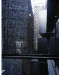
Şekil 4.102. Leeum Samsung Art Museum, çelik ızgara içerisinde taş dolgu duvar ( http://www.jeannouvel.com/en/projects/musee-leeum/ , 2019)
