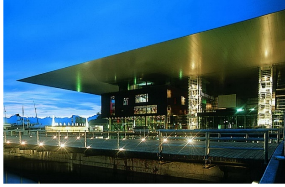
Şekil 4.30. Lucerne Culture And Congress Center, yapının bir görünümü ( https://tuchs Schmid.ch/en/projekte/kultur-und-kongresszentrum-luzern/ , 2019)
